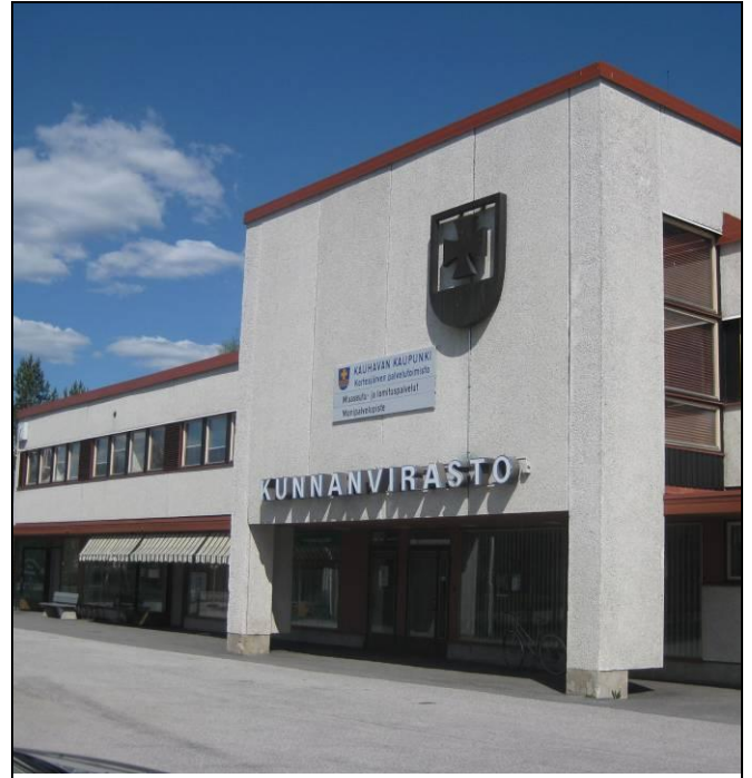
RAK-kuva 18 Julkisivujen pesubetonipintaisia seinäelementtejä
