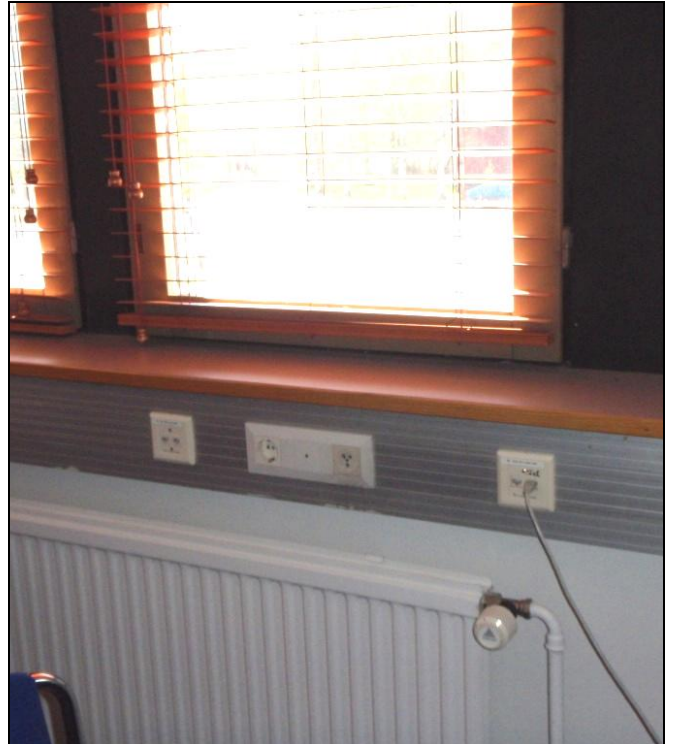
S-kuva 11 Yleiskuva toimistokourun työpisteasennuksesta
