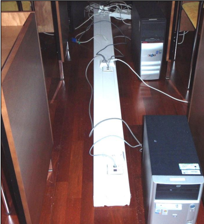
S-kuva 10 Yleiskuva kokoustilän toimistokouru-asennuksesta.
