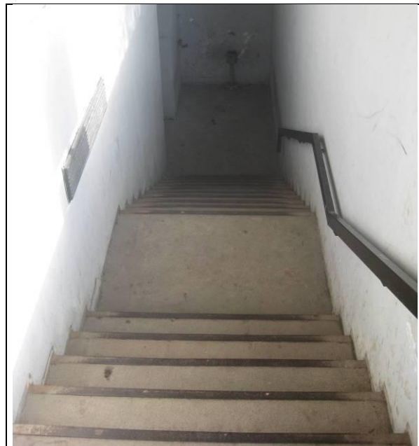
RAK-kuva 4 Kellariin johtava betoniporras
