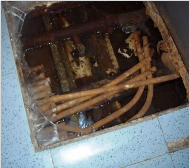
LVI-kuva 3 Vanhat lämpöverkoston runkolinjat on poistettu käytöstä ja uudet putket on asennettu kellarikerroksen kattoon
