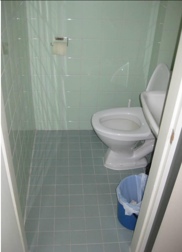
RAK-kuva Toisen kerroksen uusittua wc-tilaa 37
