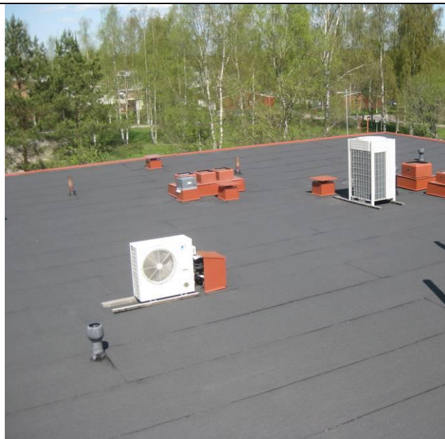
RAK-kuva 27 Vesikattoa varusteineen
