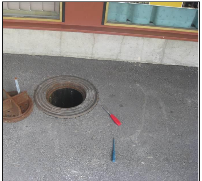
RAK-kuva 8 Salaojakaivo etupihan puolella
