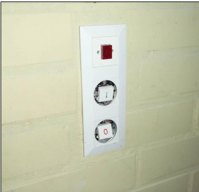
S-kuva 12 Kytkimien puuttuvat keskiölevyt tulee asentaa.
