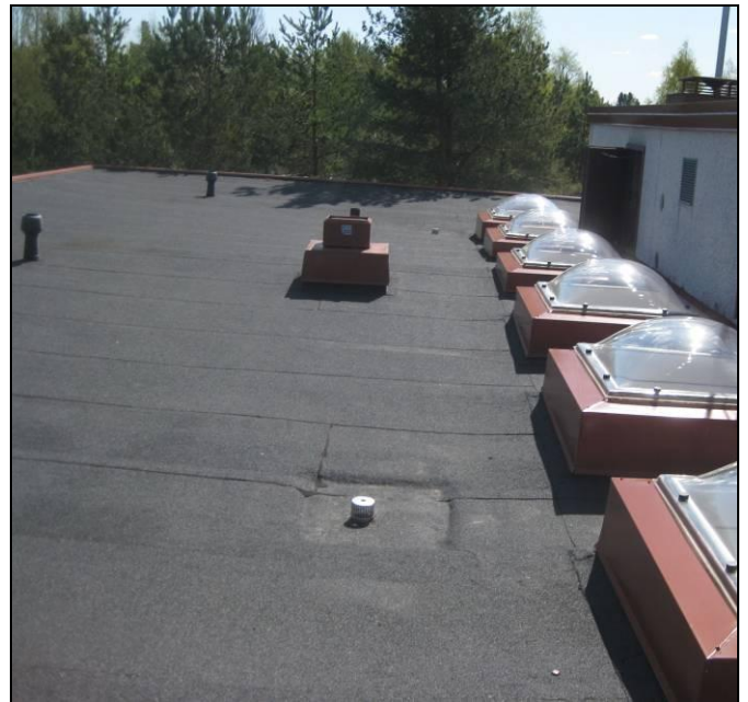
RAK-kuva 28 Vesikattoa varusteineen
