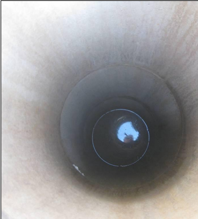
RAK-kuva 9 Salaojakaivossa vesi
