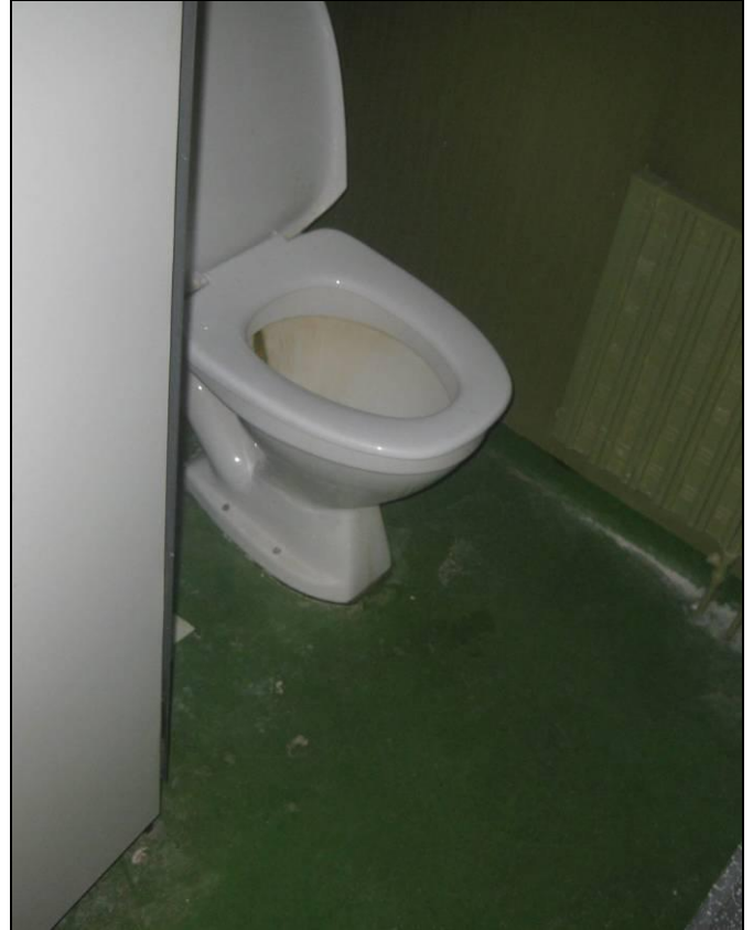
RAK-kuva Ensimmäisen kerroksen alkuperäistä wc-tilaa 38
