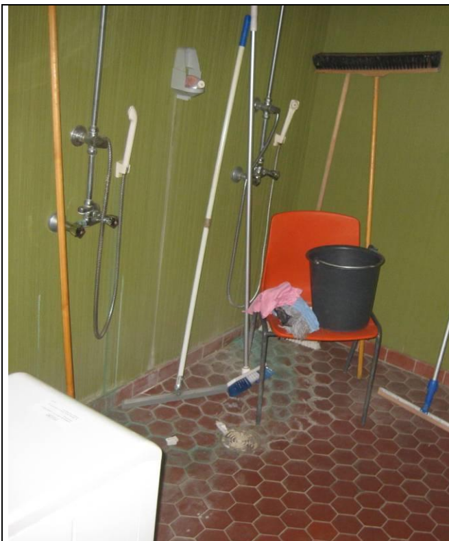
RAK-kuva 35 Kellarikerroksen alkuperäistä pesuhuonetilaa. Tila lähinnä varastokäytössä
