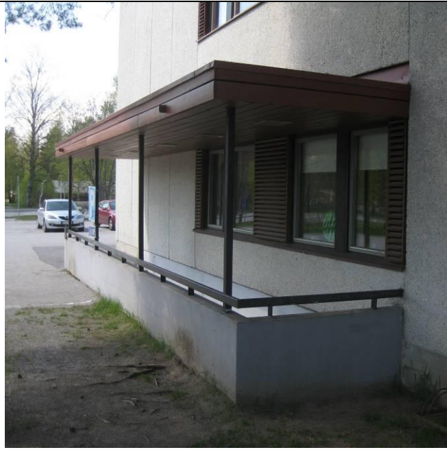
RAK-kuva 25 Kellarisisäänkäynnin kohdalla oleva katos
