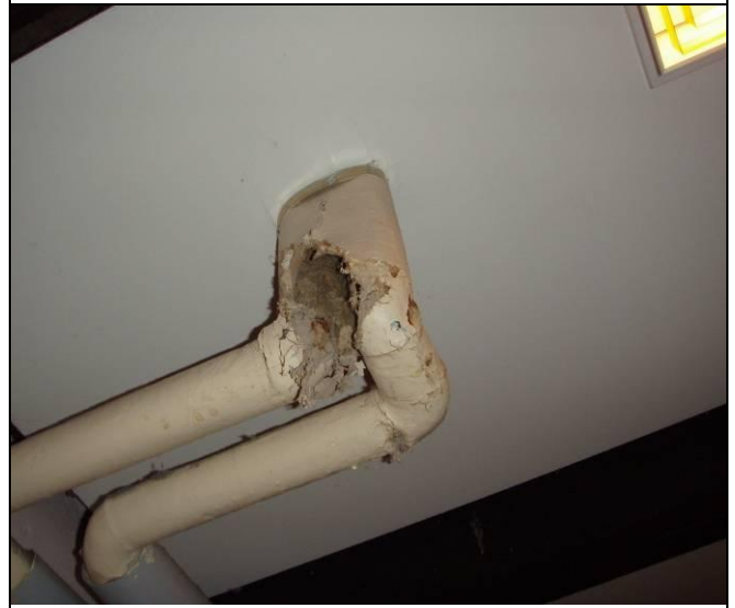
LVI-kuva 6 Kuntoarviokierroksella havaittujen kolhiintuneiden massaeristeiden korjaus oli tilattu.
