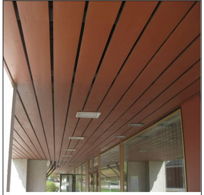
RAK-kuva 26 Katosten alakattojen puuverhoiluja
