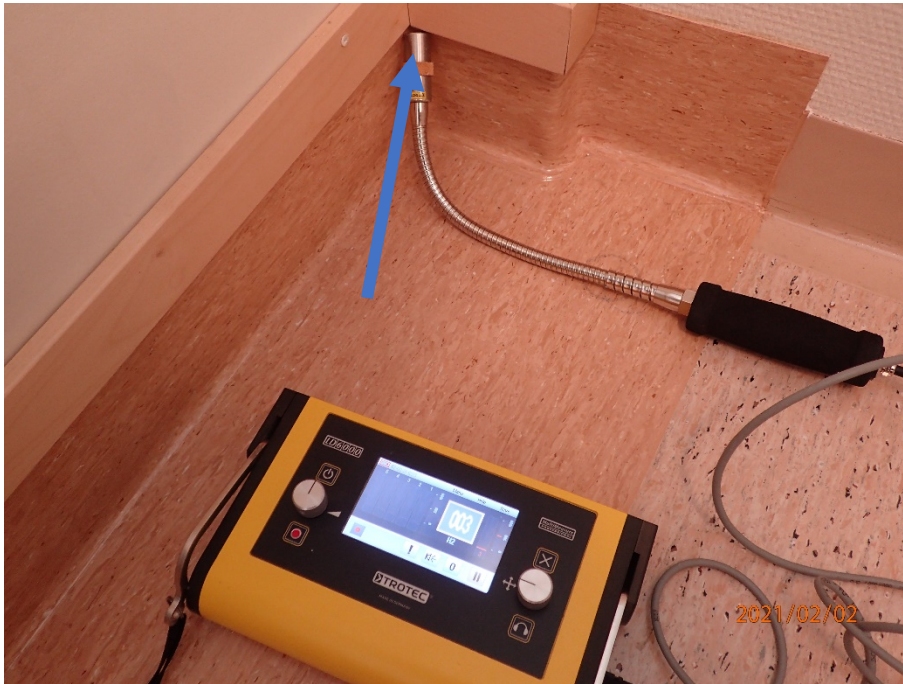
Kuva 4. Ulkoseinustoilla tehty tiivistyskorjauksia. Matto uusittu noin 300...400 mm:n leveydeltä. Nurkassa havaittiin lievää vuotoa.
