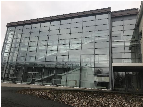
Kuva 8 Lasisiipirakennuksen sokkelin vierustalla on pääosin asfaltointi tai pensasistutukset.
