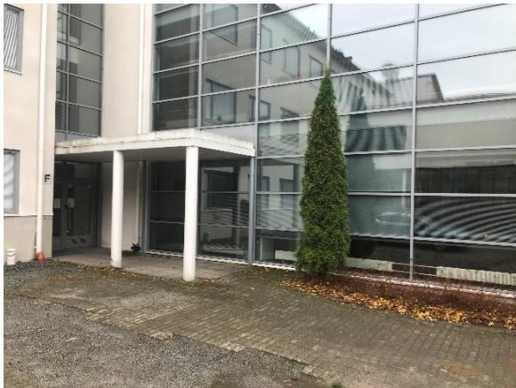
Kuva 6 Lasisiipirakennuksen sokkelin vierustalla on pääosin asfaltointi tai pensasistutukset.
