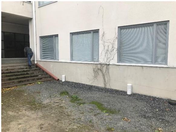
Kuva 14 Lasisiipirakennuksen vierellä olevalla laajennusosalla sokkelin vierusta on sorastettu. Sokkeli on yleisilmeeltään siisti.
