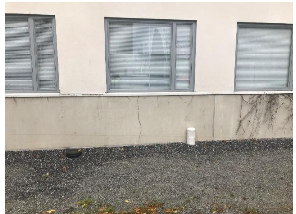
Kuva 15 Lasisiipirakennuksen vierellä olevalla laajennusosalla sokkelin vierusta on sorastettu. Sokkeli on yleisilmeeltään siisti.
