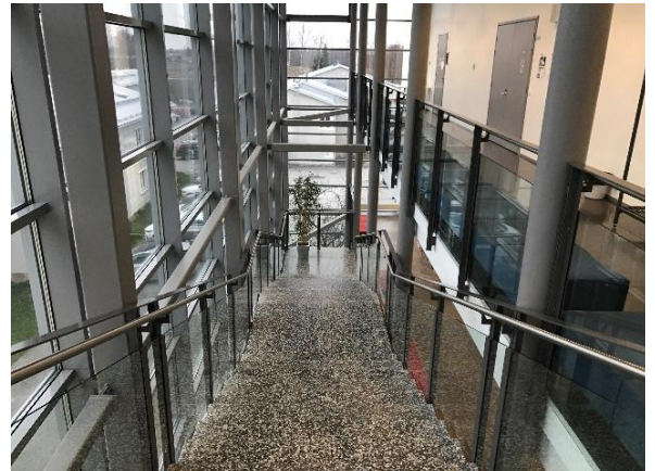
Kuva 32 Tarkasteltavien rakennusosien ulkoseinärakenteissa ei havaittu viitteitä painumisesta, kosteudesta tai muusta vaurioitumisesta.
