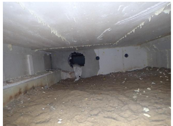
Kuva 24 Yleiskuva laajennusosien ryömintätilasta. Ryömintätilat olivat yleisesti suhteellisen siistit.
