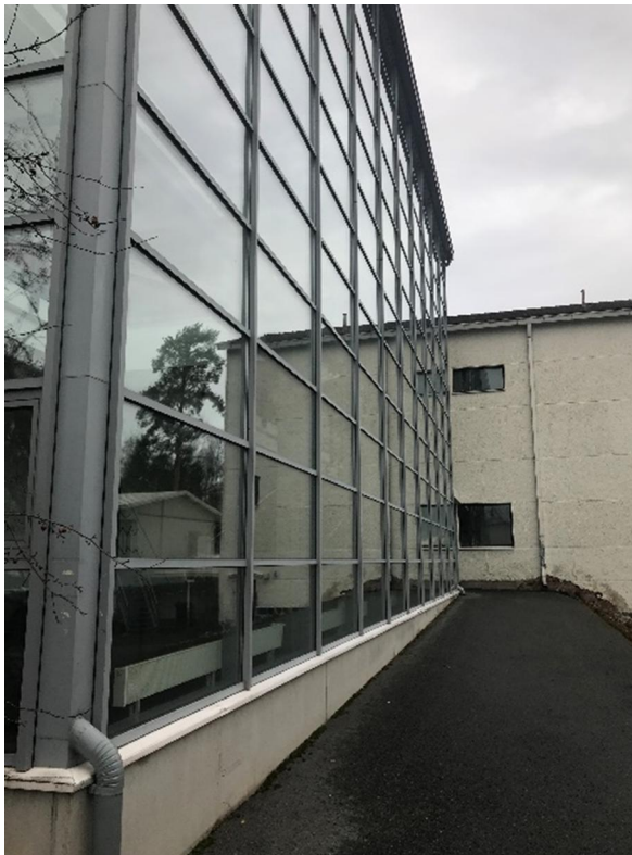
Kuva 16 Lasisiipirakennuksen sokkelin vierusta on osin asfaltoitu. Sokkeli on yleisilmeeltään siisti.
