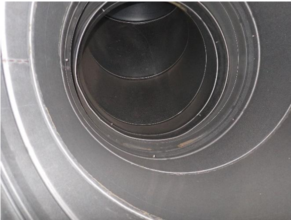
Kuva 55 Tuloilman runkokanava IV-koneen TK2/PK2 palvelualueella. Ei merkittävää pölykertymää.
