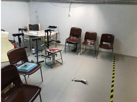
Kuva 21 Yleiskuva lasisiipirakennuksen kellaritiloista. Kuvassa meneillään mattopinnoitteiden alustan kosteusmittaus, ns. viiltomittaus.
