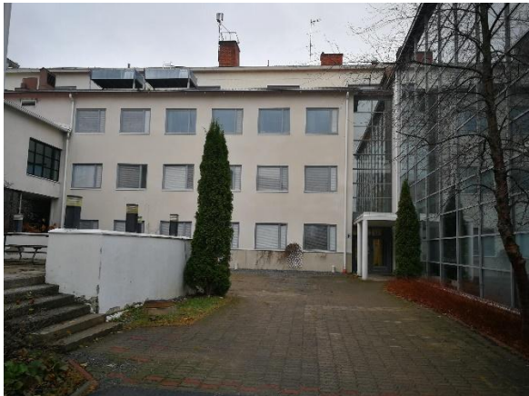
Kuva 27 Yleiskuvaa kivi-koulun länsipuolelle rakennetusta laajennusosasta sekä lasisiipirakennuksesta.
