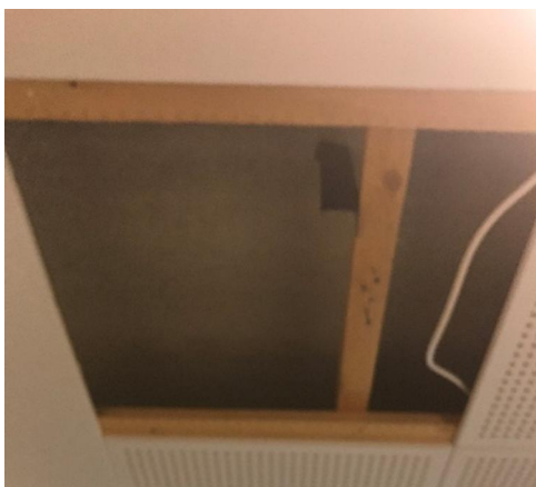
Kuva 44 Alakattorakenteissa ei havaittu merkittäviä pölykertymiä tai muita epäpuhtauksia.
