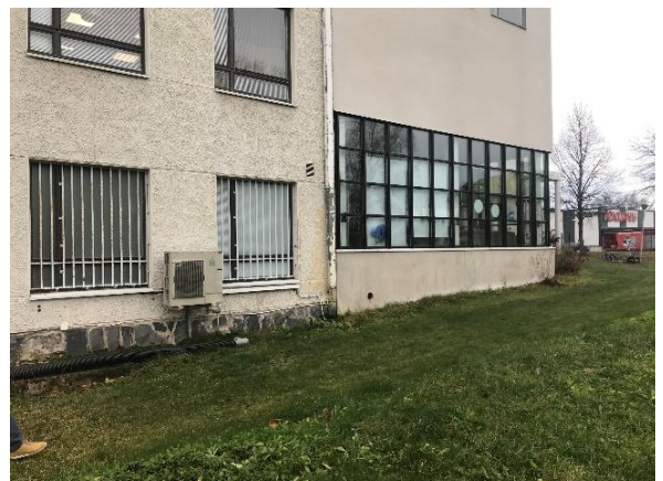
Kuva 11 Kadunpuoleisen laajennusosan sokkelin vierustalla on nurmimaa.
