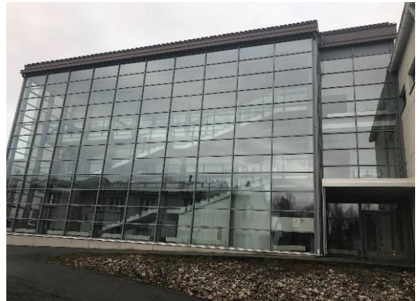
Kuva 5 Lasisiipirakennus kuvattu etelästä.
