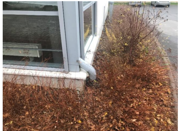
Kuva 7 Lasisiipirakennuksen sokkelin vierustalla on pääosin asfaltointi tai pensasistutukset.
