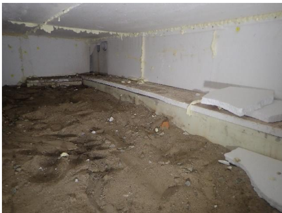
Kuva 23 Yleiskuva laajennusosien ryömintätilasta. Ryömintätilassa oli paikoitellen vähän rakennusjätettä.
