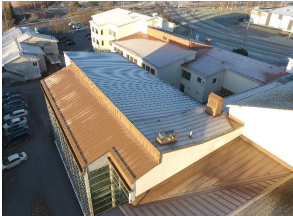
Kuva 38 Yleiskuvaa lasisiipirakennuksen vesikatteesta.
