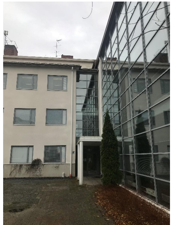
Kuva 17 Lasisiipirakennuksen sokkelin vierustalla on osin pensasistutuksia. Sokkeli on yleisilmeeltään siisti.
