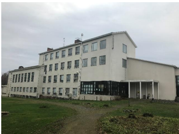
Kuva 10 Kadunpuoleisen laajennusosan sokkelin vierustalla on nurmimaa.
