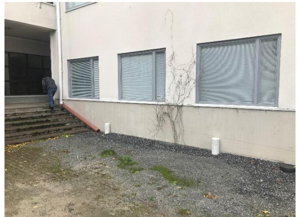
Kuva 9 Lasisiipirakennuksen vierellä olevalla laajennusosalla sokkelin vierusta on sorastettu.
