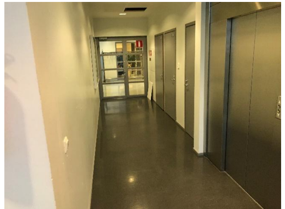
Kuva 43 Alakattorakenteita tarkasteltiin irrottamalla alakattolevyjä.
