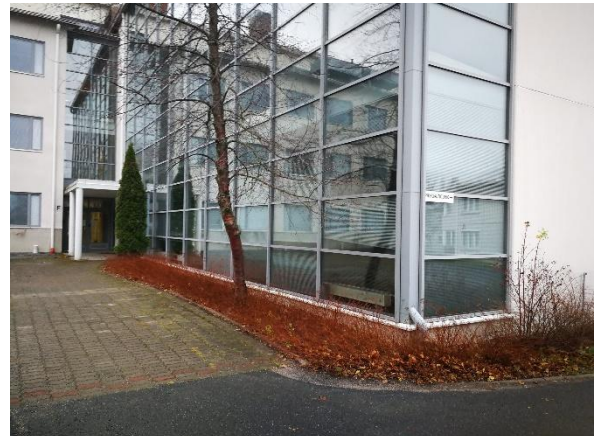
Kuva 28 Lasisiipirakennuksen osalla suurin osa julkisivusta on lasijulkisivua.
