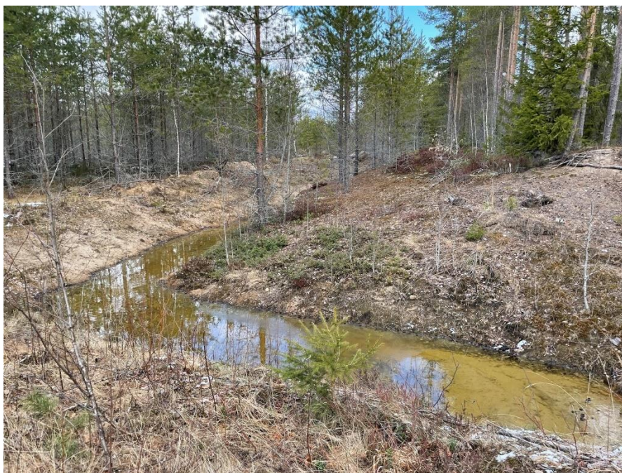
Kuva 7-2. Pohjavesialueella sijaitseva kuivatusoja.
