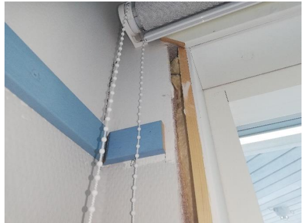
Kuva 9. Ikkuna- ja seinärakenteen liitos ikkunan sivulla.
