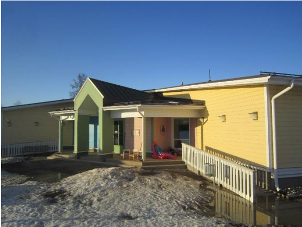
Kuva 19. Julkisivut ovat hyväkuntoiset.
