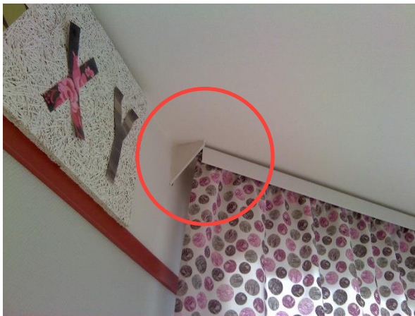
Kuva 23: Pienryhmähuone 149, palkin metallinen kannake.
