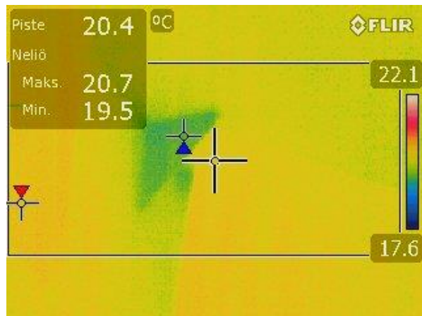
Kuva 24: Metallikannakkeen kohdalla ei havaittavissa kylmäsilta- tai ilmavuotokohtia.
