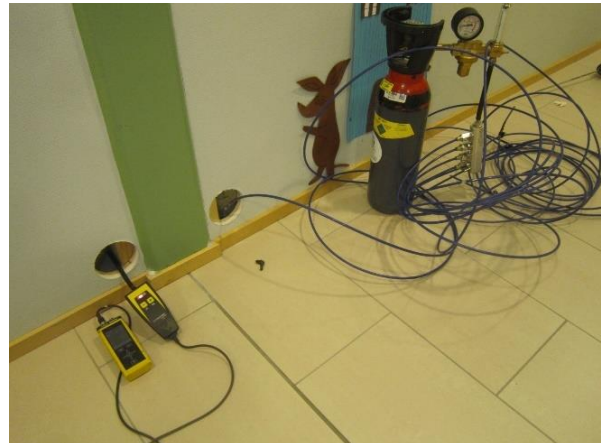
Kuva 15: Lattian ja pilarien liitoskohdat epätiivitä. Merkkiainetta havaittiin pilarin toisella puolella, kun sitä laskettiin lämmöneristekerrokseen.
