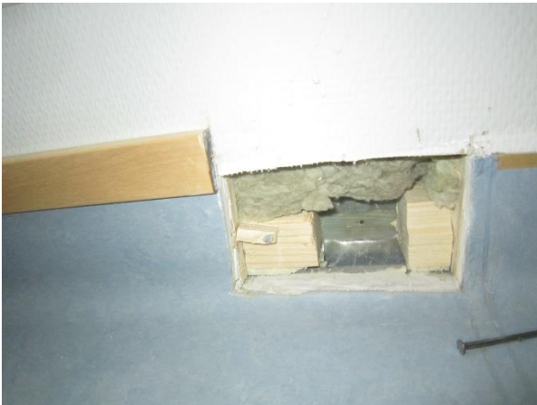
Kuva 20. Ulkoseinän avaus lattian ja ulkoseinän liittymästä.
