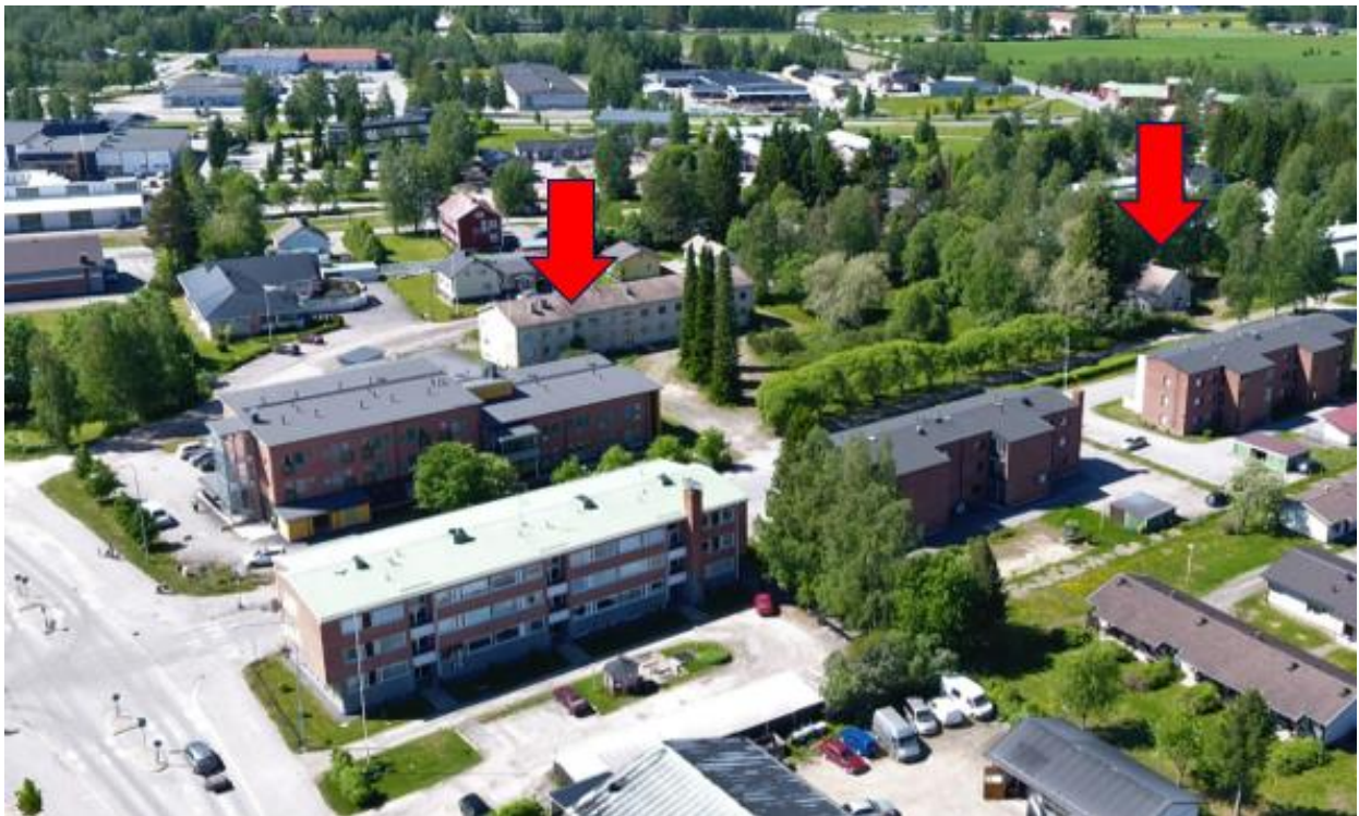
Kuva 3. Suunnittelu alueen rakennettua ympäristöä.
