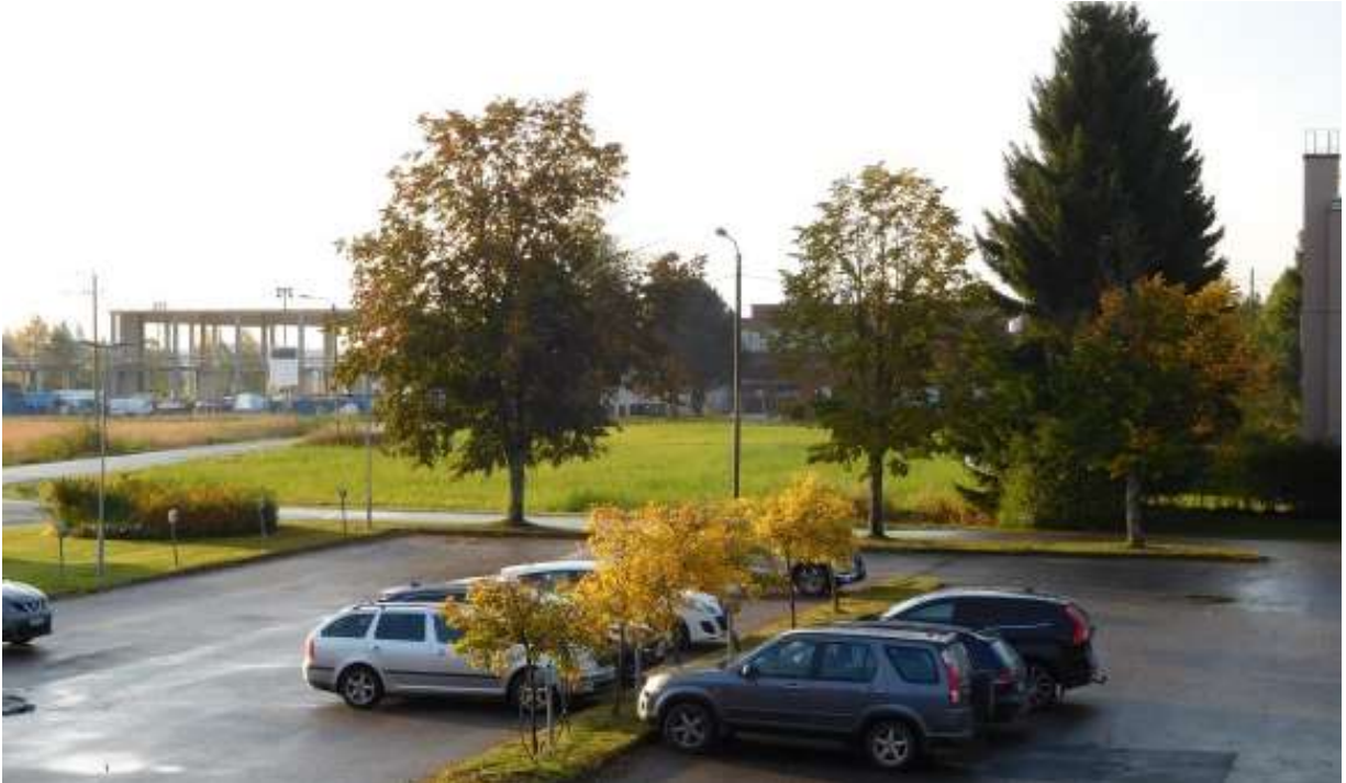
Kuva 22: Rakenteilla oleva Ylihärman yhtenäiskoulu syksyllä 2020.
