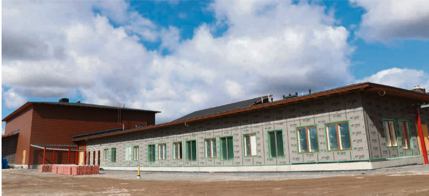
Näkymä Ylihärman koulutyömaalta pihan puolelta: tähän nousee koulukeskuksen uudisrakennus. Siihen rakentuvat myös tilat liikuntasalille.
