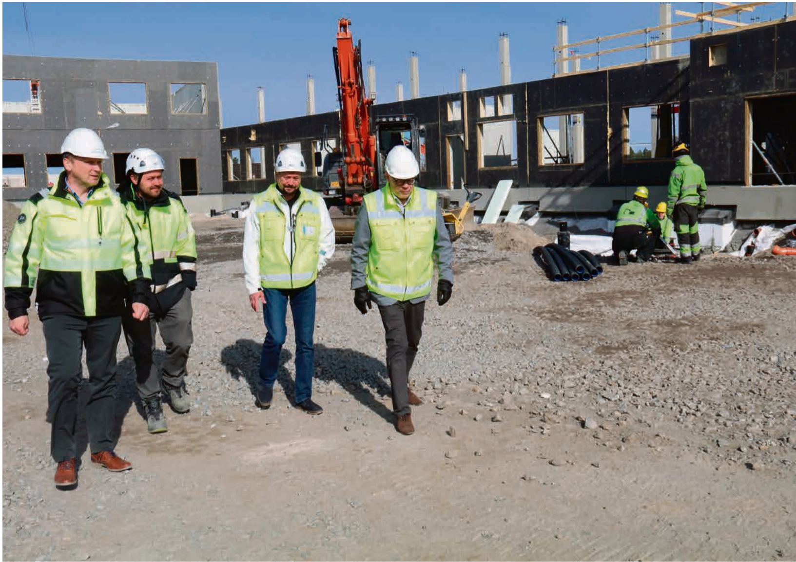
Työmaakatselmusta pitämässä Hyvinvointikeskus Oy:n toimitusjohtaja Hannu Ristaniemi, kohteen rakentajan, Hämäläiset Oy:n vastaava työnjohtaja Juhamatti Nurmela ja työpäällikkö Kari Hämäläinen sekä Kauhavan kaupunginjohtaja Markku Lumio. Kuvaushetkellä on käynnissä hyvinvointikeskuksen seinäelementtien asennus.
