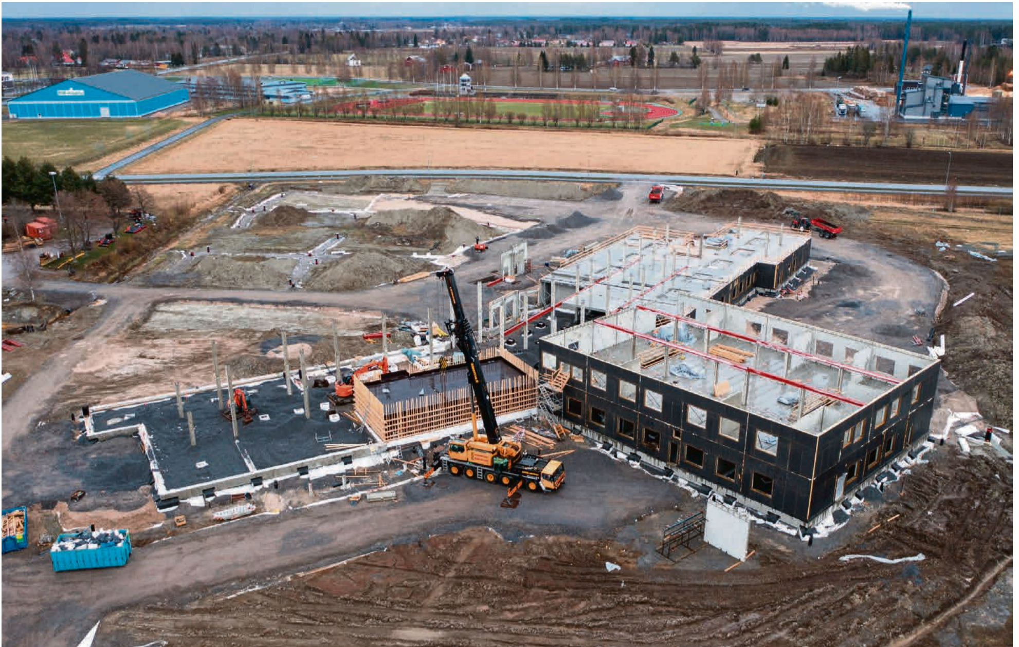
Rakentava hyvinvointikeskus kuvattuna ilmasta kantatien suunnasta. Kuva: Antti Järvinen
