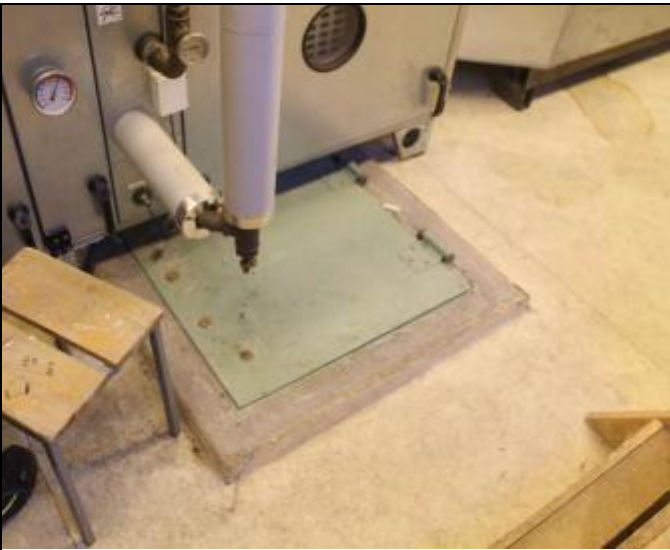
RAK-kuva 83. Kirjasto-osan iv kojehuone. Kojeen alle on jäänyt osittain vanhan kirjasto-autohallin kulkuluukku. Ilmayhteys kirjastoon.
