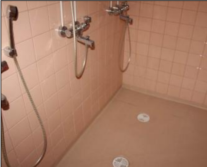
RAK-kuva Liikuntasaliosan pesuhuone 69.
