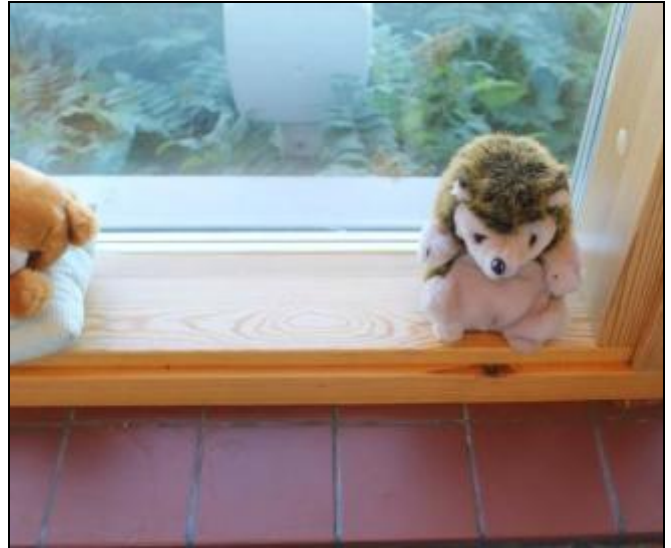
RAK-kuva 34. Yleiskuva kirjasto-osan kiinteästä lämpölasielementein varustetusta ikkunasta.
