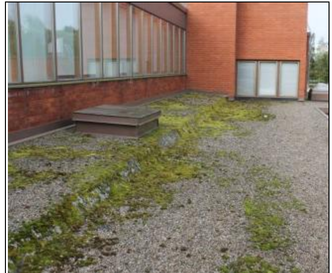
RAK-kuva 48. Yleiskuva ruokala- keittiötilan kohdalla olevasta vesikattoalueesta.
