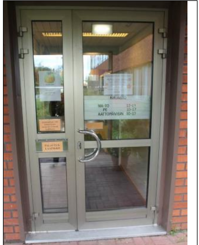
RAK-kuva 46. Uusittu kirjaston pääsisäänkäynnin alumiiniprofiilirakenteinen ulko-ovi
