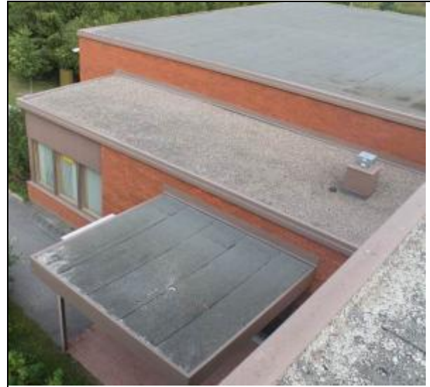
RAK-kuva Kirjasto-osan vesikattoja. 50.
