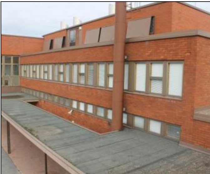
RAK-kuva 27. Yleiskuva tiilijulkisivuista rakennuksen eteläpuolen alueella
