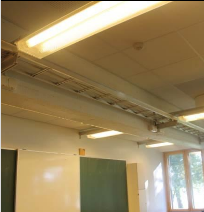
RAK-kuva 25. Yleiskuva kantavista betonipalkkirakenteista
