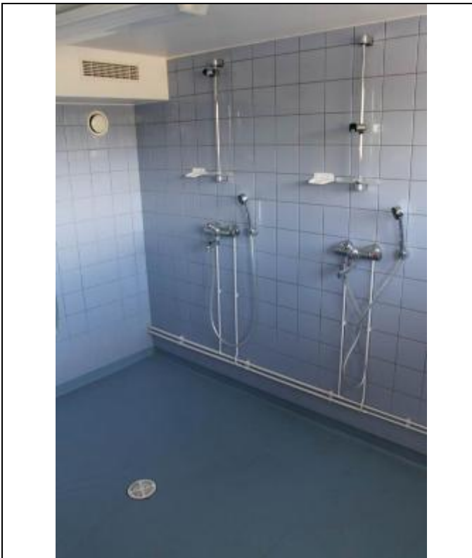
RAK-kuva Liikuntasaliosan pesuhuone. 71.
