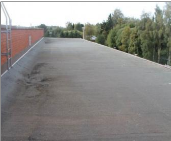
RAK-kuva Luokkasiiven osalla oleva länsipuolen vesikatto 51.
