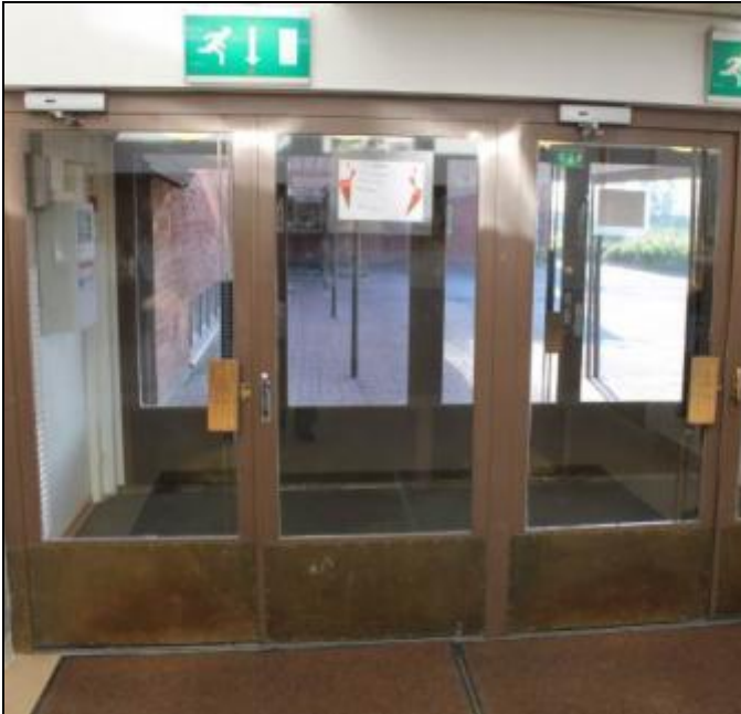
RAK-kuva 41. Yleiskuva koulun pääsisäänkäynnin metalliprofiilirakenteisista ulko – ja tuulikaappiovista.
