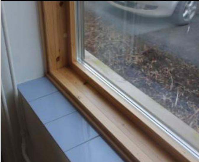
RAK-kuva 33. Yleiskuva ruokalan kiinteästä lämpölasielementein varustetusta ikkunasta.
