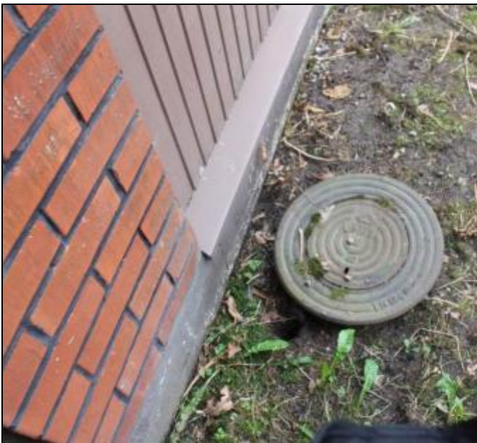
RAK-kuva 7. Salaojien tarkastuskaivo rakennuksen pohjoispuolella
