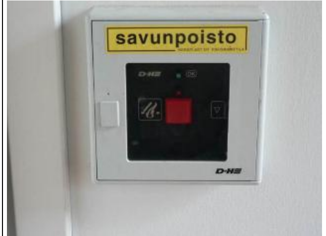
S-kuva 30. Savunpoistoikkunan avauspainike.
