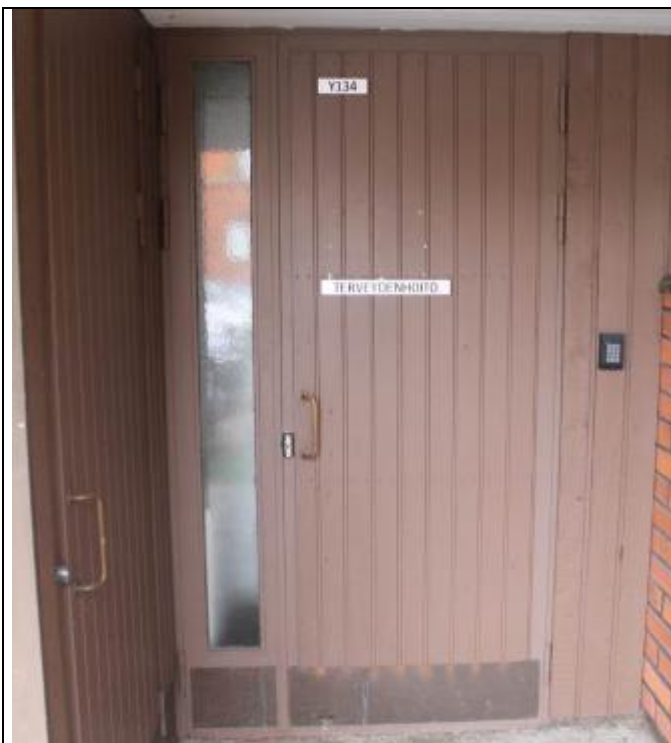
RAK-kuva 43. Yleiskuva entisen asunnon metalliprofiilirakenteisesta, puupaneloidusta ulko-ovesta.
