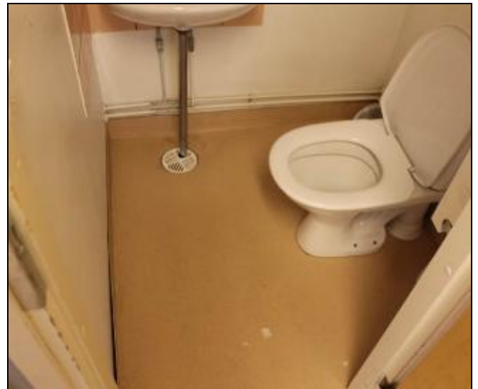
RAK-kuva 68. Wc-tilaa pintamateriaaleineen
