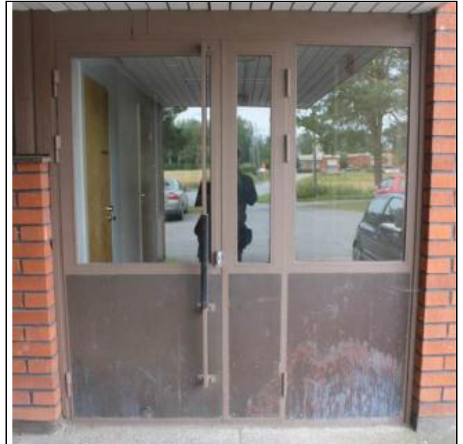
RAK-kuva 42. Yleiskuva koulun laajennusosan metalliprofiilirakenteisesta ulko-ovesta
