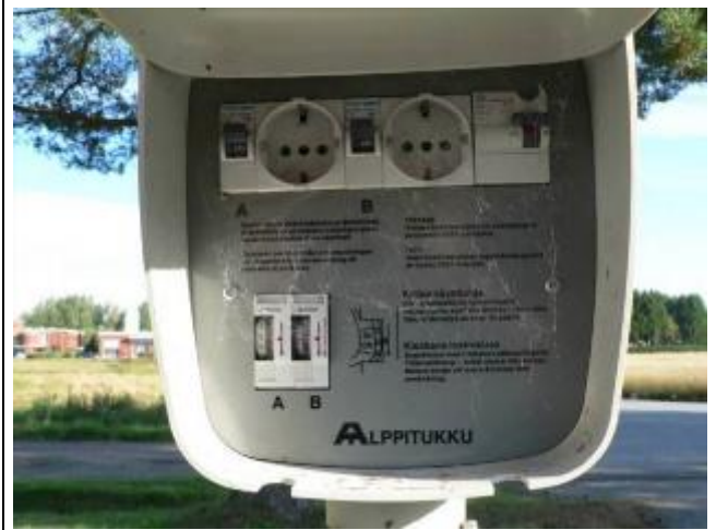
S-kuva 16. Yleiskuva autolämmityspistorasias- ta.
