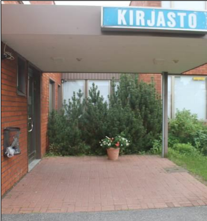
RAK-kuva Kirjaston pääsisäänkäynnin katoslippa 21.
