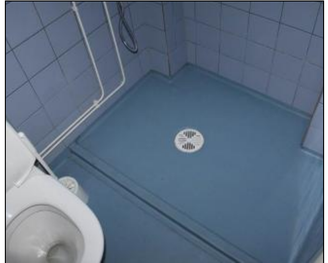
RAK-kuva Henkilökunnan wc- / suihkuhuone 70.
