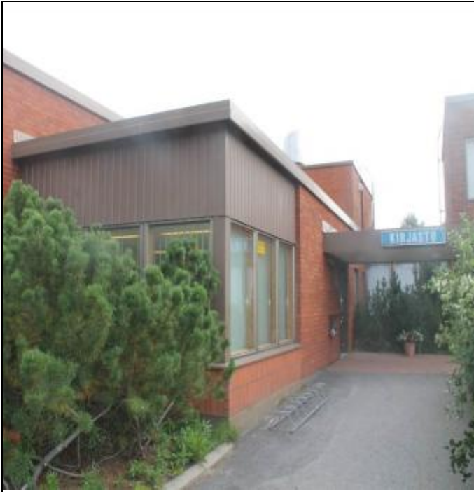
RAK-kuva 5. Kirjaston pääsisäänkäynnin edusta on sidekiveyspinnoitettu, kulkuväylä on asfaltoitu.
