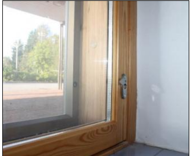
RAK-kuva 38. Kellarikerroksen pukuhuoneen ikkuna
