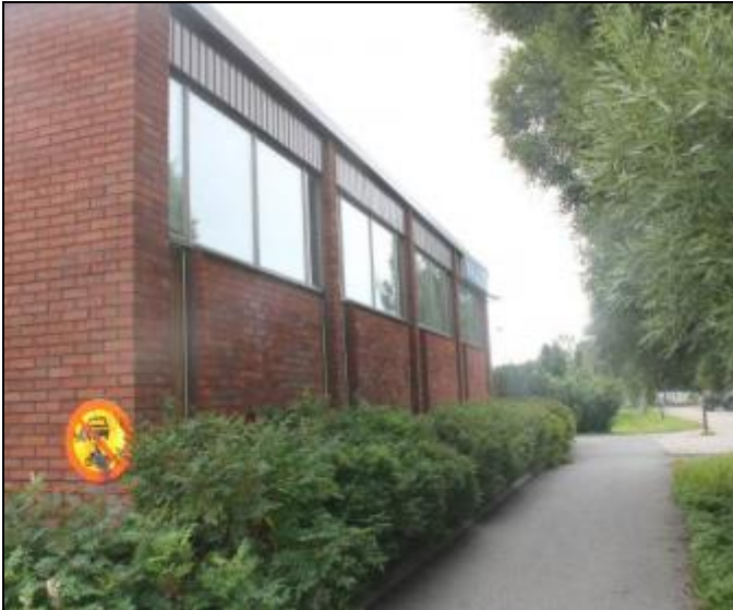
RAK-kuva 29. Kirjasto-osan tiilijulkisivua länsipuolen alueella
