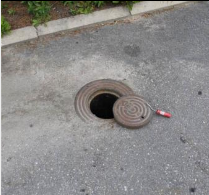
RAK-kuva 9. Kirjaston pääsisäänkäynnin puoleisella väylällä oleva salaojan tarkastuskaivo.
