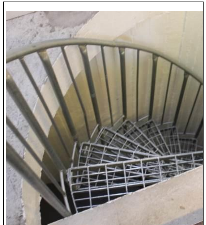
RAK-kuva Metallirakenteinen kierreporras kouluosan ilmanvaihtokojehuoneeseen 64.
