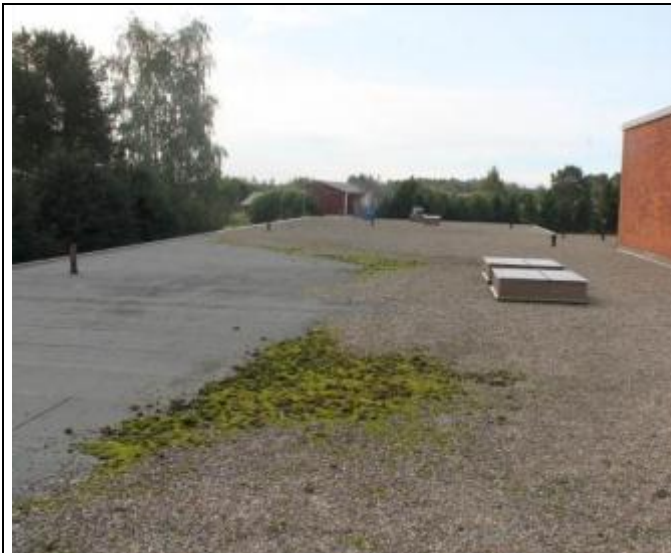
RAK-kuva 47. Yleiskuva laajennusosan vesikatolta.
