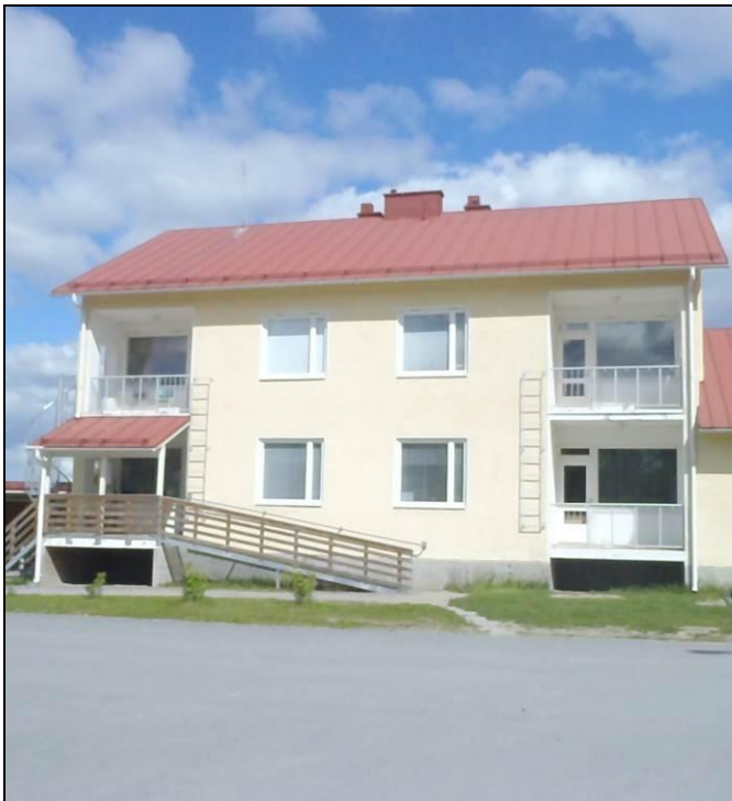
RAK-kuva 13 Yleiskuva parvekelinjoista
