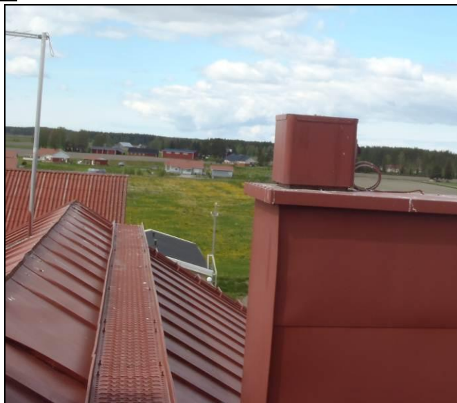
RAK-kuva 18 Vesikattoa varusteineen
