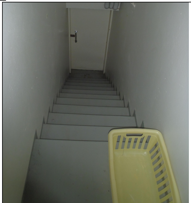
RAK-kuva Sisäinen porras 22
