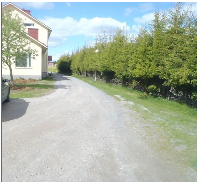
RAK-kuva 2 Sorapintainen kulkuväylä rakennuksen pohjoispuolella
