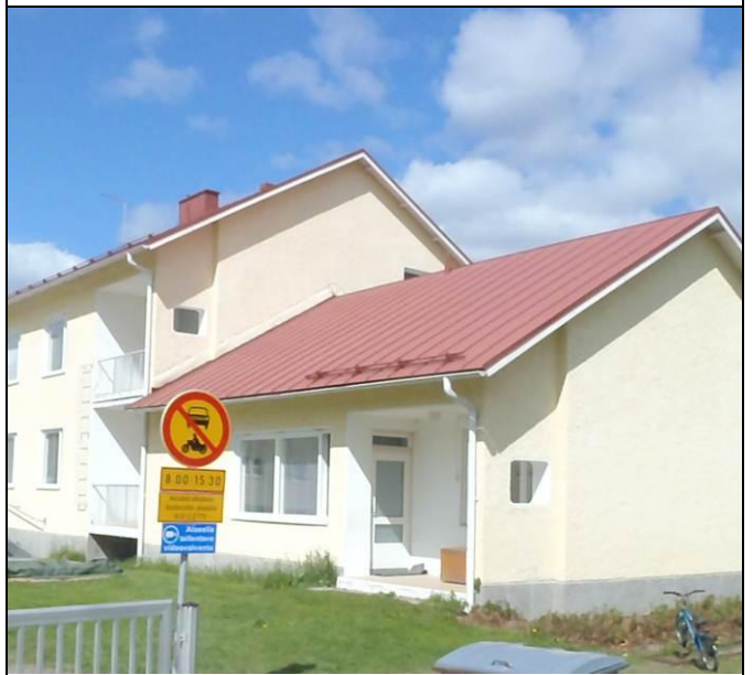
RAK-kuva 8 Julkisivujen roiskerapattuja pintoja
