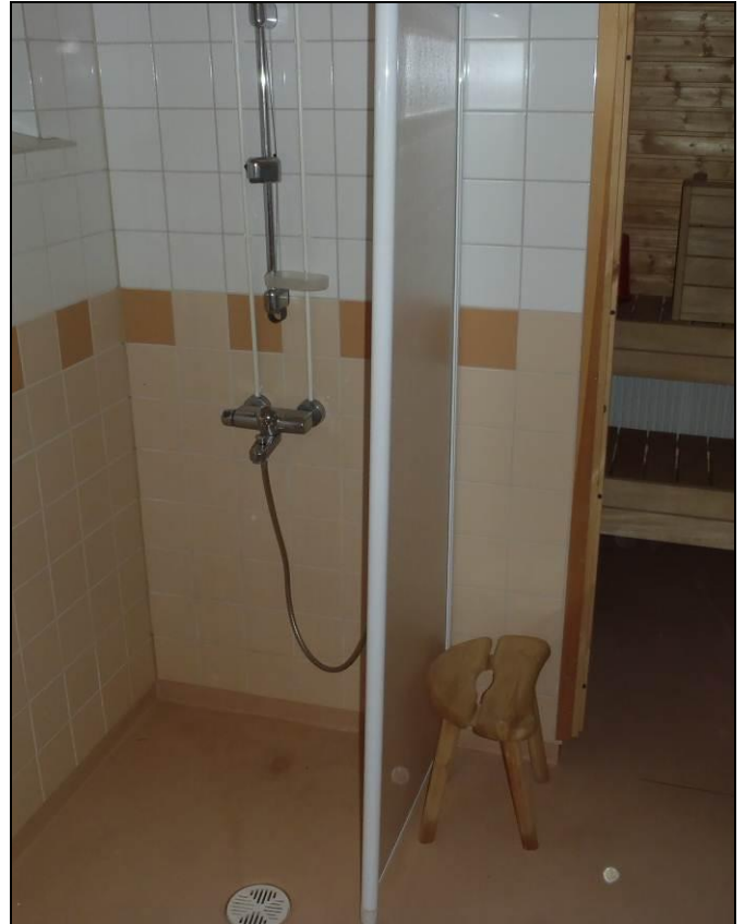
RAK-kuva Kellarikerroksen pesuhuone , sauna 26
