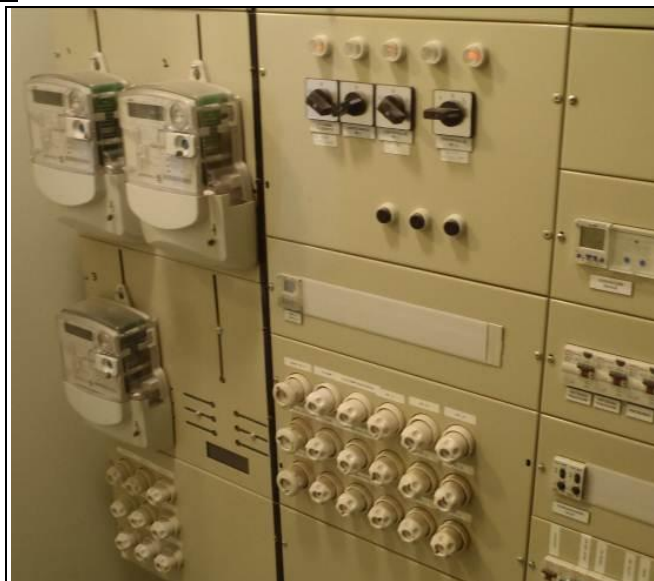
S-kuva 2. Yleiskuva nousukeskuksesta.
