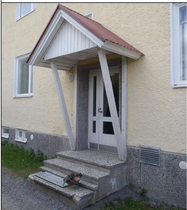
RAK-kuva 15 Sisäänkäyntikatot pohjoispuolella
