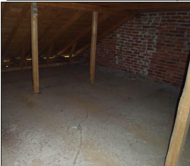
RAK-kuva 17 Yläpohjan rakenteita matalamman osan alueella
