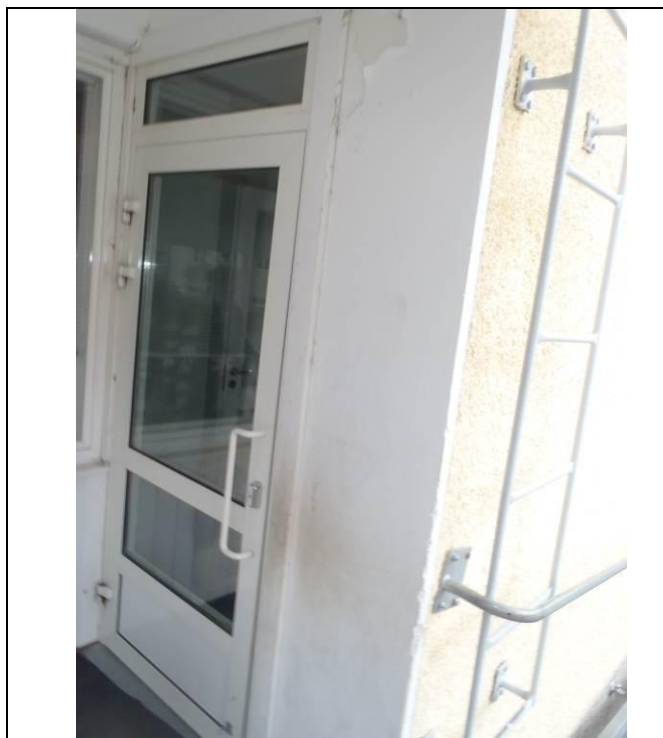
RAK-kuva 12 Uusittu hyväkuntoinen ulko-ovi
