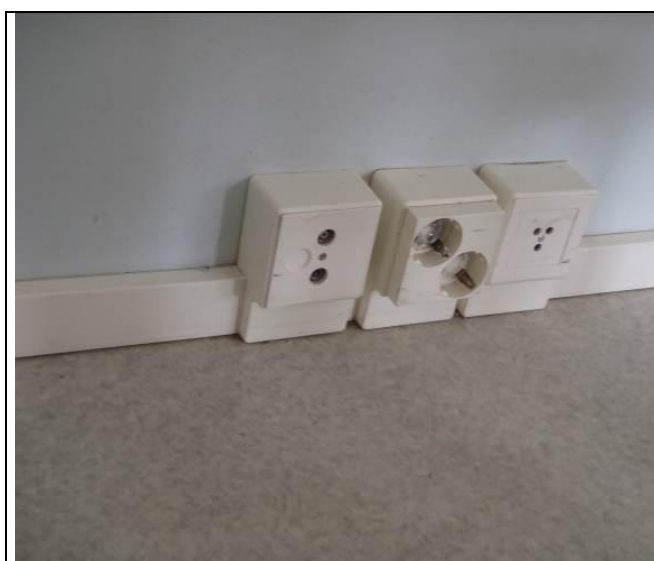
S-kuva 4. Yleiskuva lista-asennuksista.
