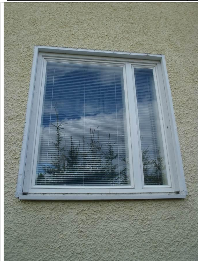
RAK-kuva 9 Uusittu hyväkuntoinen ikkuna
