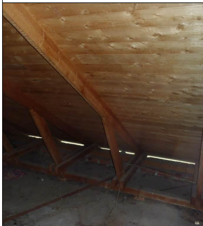
RAK-kuva 16 Yläpohjan rakenteita
