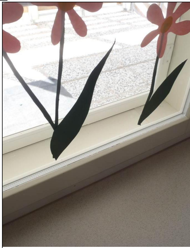
RAK-kuva 10 Uusittu hyväkuntoinen ikkuna
