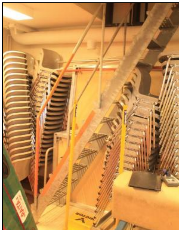
RAK-kuva Laajennusosan metallirakenteinen porras iv-kojehuoneeseen 48.
