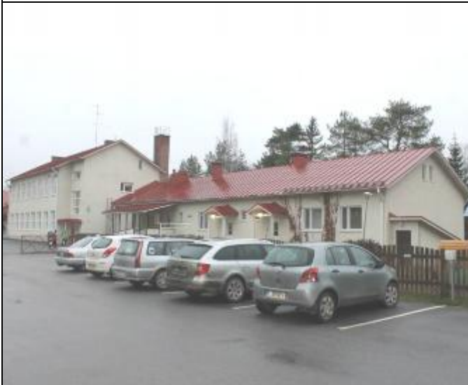
RAK-kuva 41. Vesikattoja vanhan kouluosan ja päiväkodin osalla
