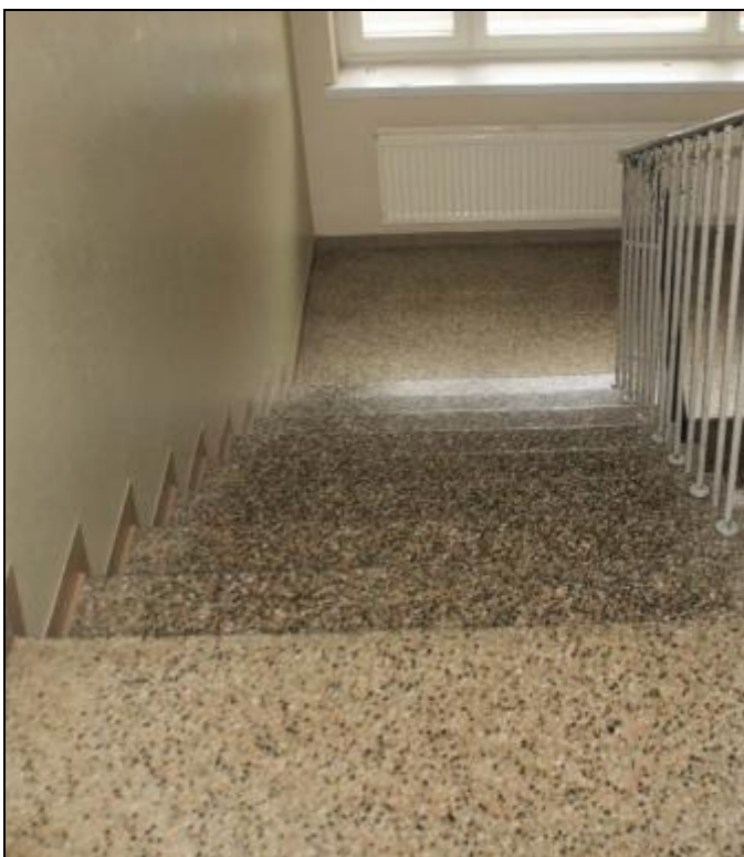
RAK-kuva Kouluosan sementtimosaikkipintainen betoniporras 47.
