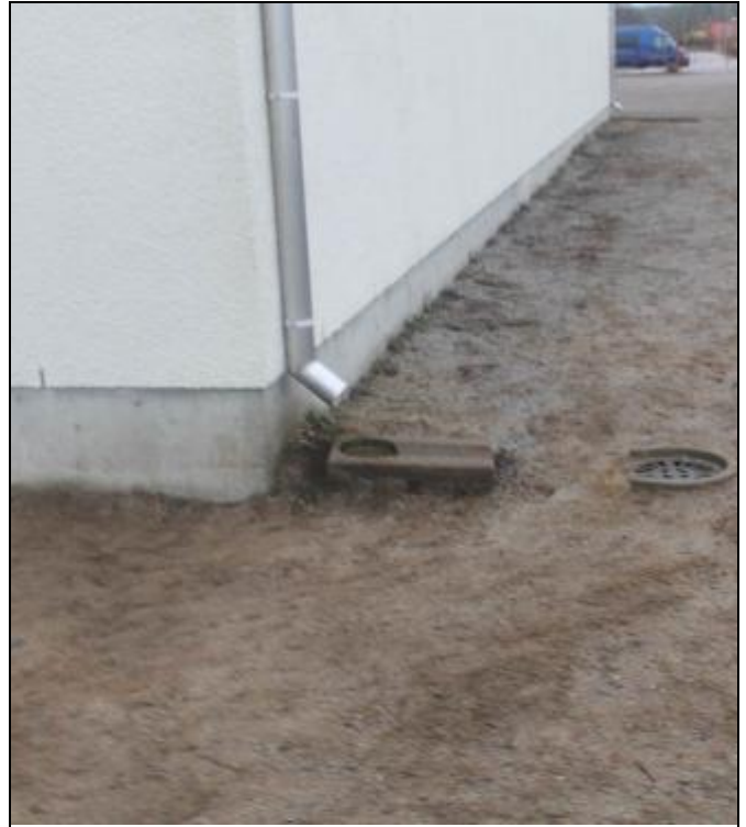
RAK-kuva 6. Kattovesien poistoja..
