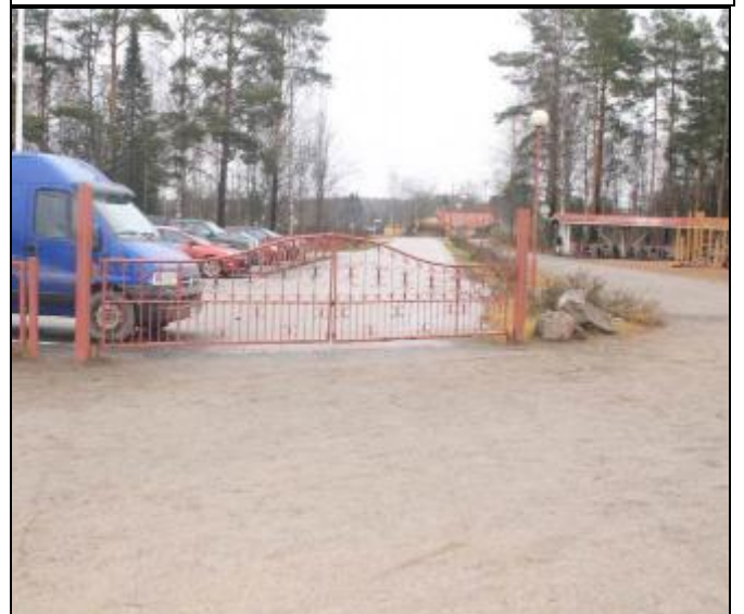
RAK-kuva 4. Asfaltoitua ajoväylää ja pysäköin- tialuetta ja sorapintaista piha- aluetta
