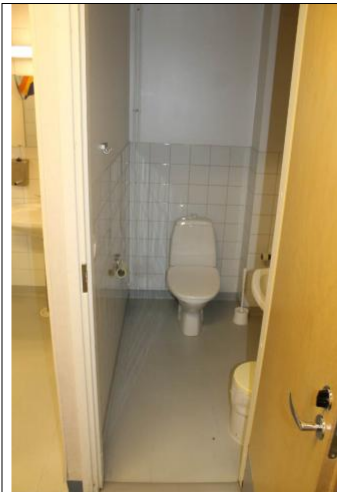
RAK-kuva Laajennusosan wc 59.
