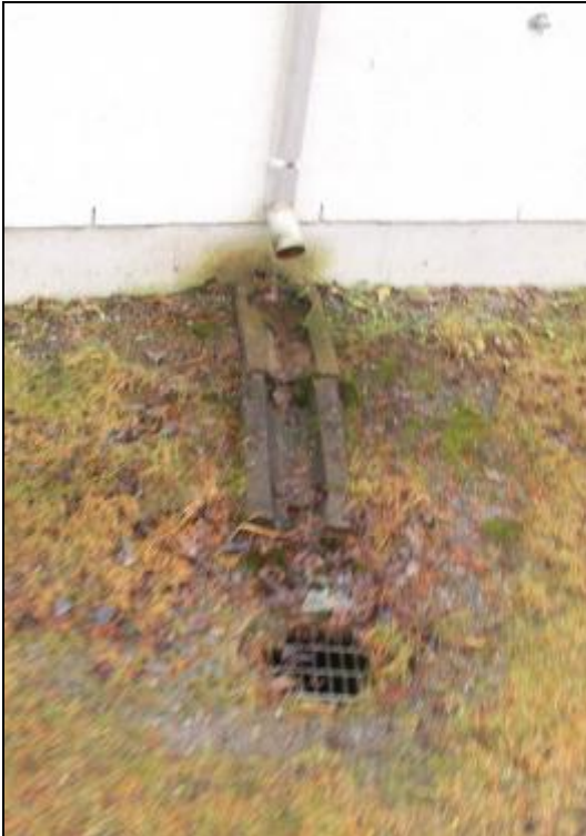
RAK-kuva 5. Kattovesien poistoja.
