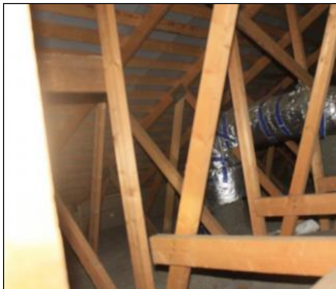
RAK-kuva 22. Kouluosan laajennuksen yläpohjan kantavia puuristikkorakenteita
