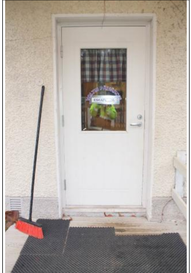
RAK-kuva 34. Uusittu päiväkodin ulko-ovi
