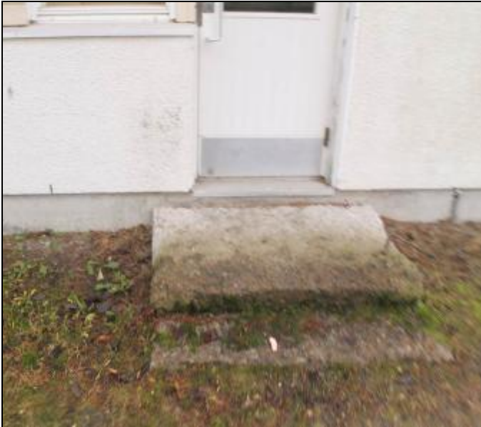
RAK-kuva 17. Betoninen porraslaatta koululaajennuksen osalla
