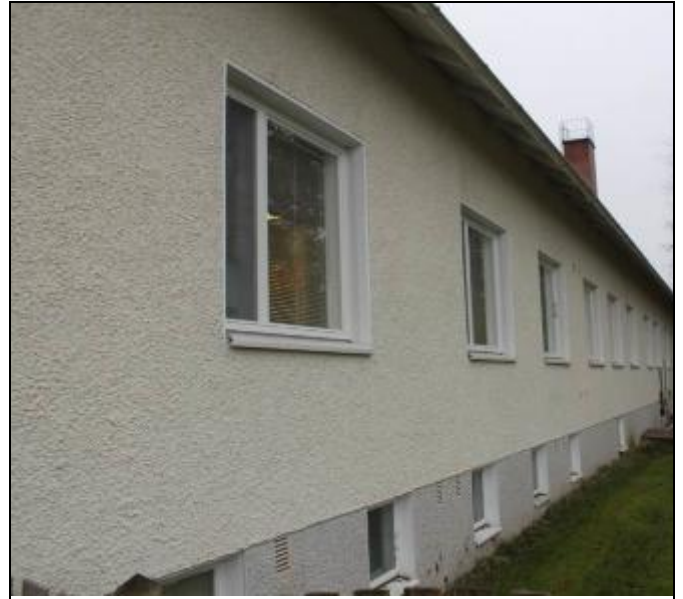
RAK-kuva 18. Alkuperäistasoista rapattua sokkeliosuutta päiväkotiosalla
