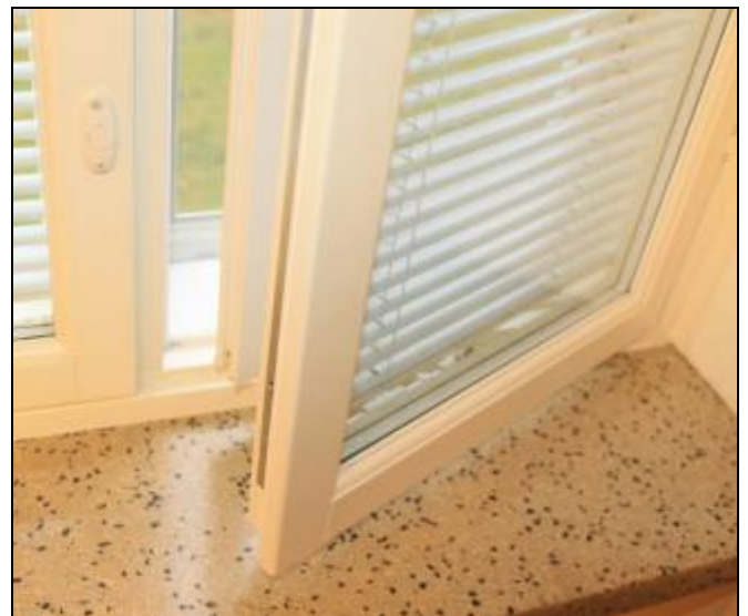
RAK-kuva 28. Uusittu puu-alumiini-ikkuna päiväkotiosalla
