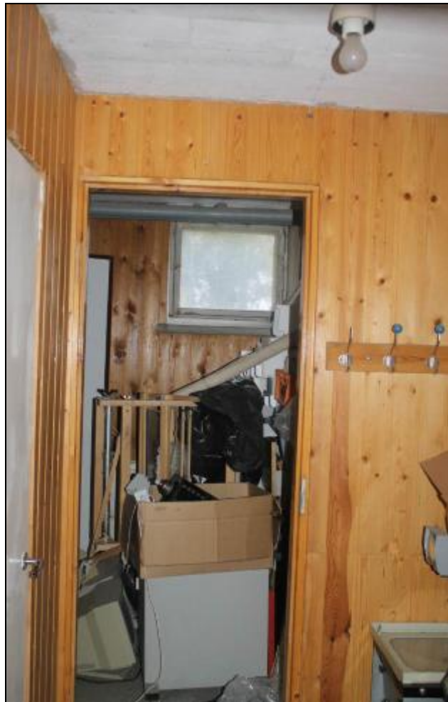
RAK-kuva Päiväkotiosan tilapintoja kellarikerroksessa, tilat lähinnä varastokäytössä,
