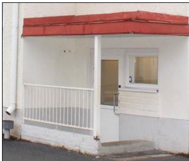
RAK-kuva 38. Vanhan kouluosan katos kellari-sisäänkäynnin kohdalla
