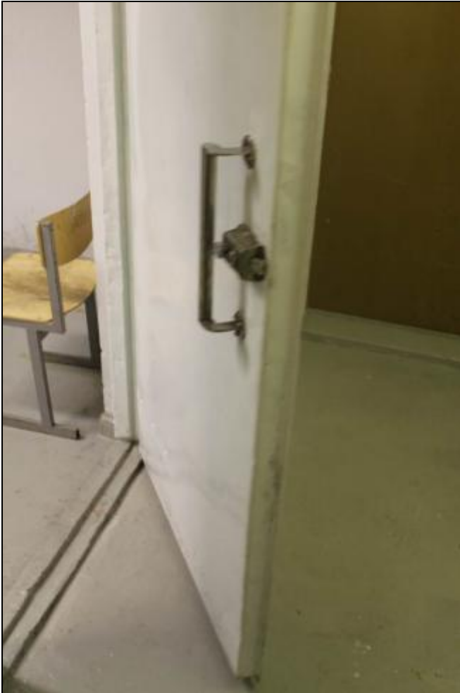
RAK-kuva 43. Metallirakenteinen palo-ovi kellaritilassa
