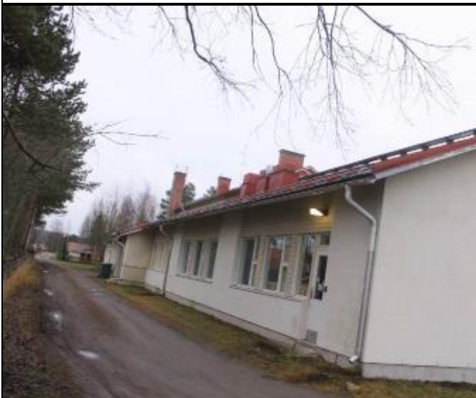
RAK-kuva 3. Koululaajennuksen pohjoispuolen alue. Kulkuväylä sora/ hiekkapintai- nen
