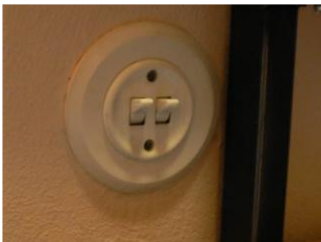
S-kuva 11. Alkuperäiset sähkökalusteet ovat elinkaarensa loppupuolella.
