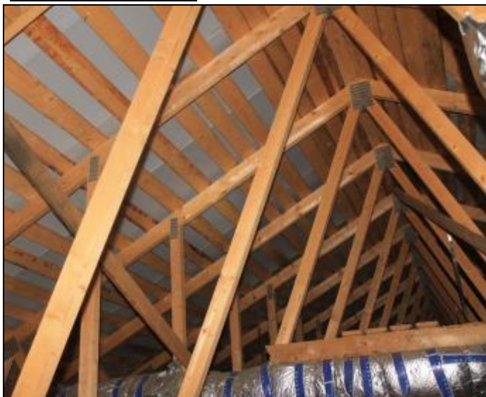
RAK-kuva 21. Kouluosan laajennuksen yläpohjan kantavia puuristikkorakenteita
