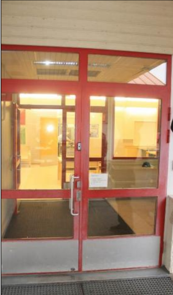
RAK-kuva 33. Metalliprofiilirakenteinen, lasiaukollinen ulko-ovi
