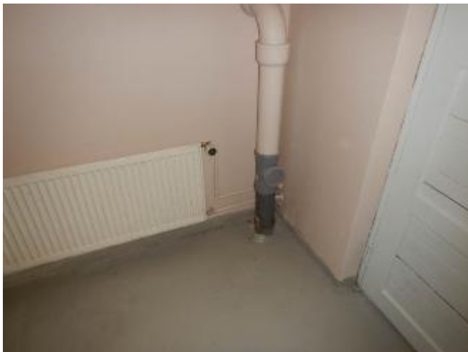
LVI-kuva 7. Yleiskuva vanhoista patteriventtiileistä
