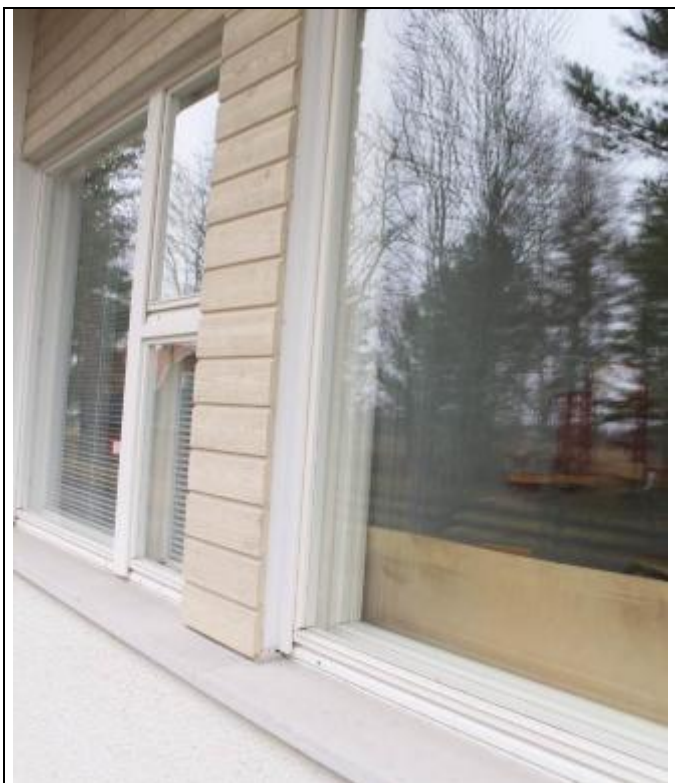
RAK-kuva 31. Koulun laajennusosan ikkuna
