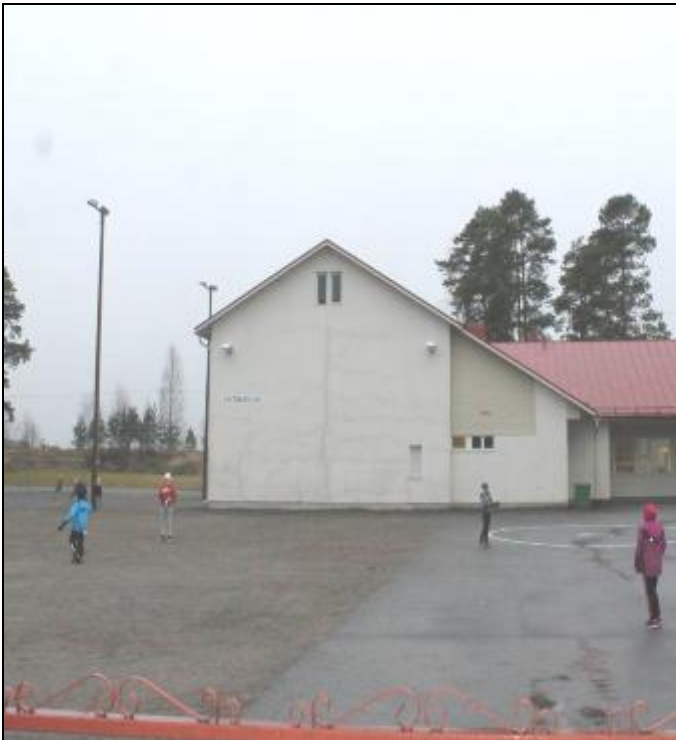
RAK-kuva 1. Koulun eteläpuoleista asfaltoitua / sorapintaista välituntipihaa.
