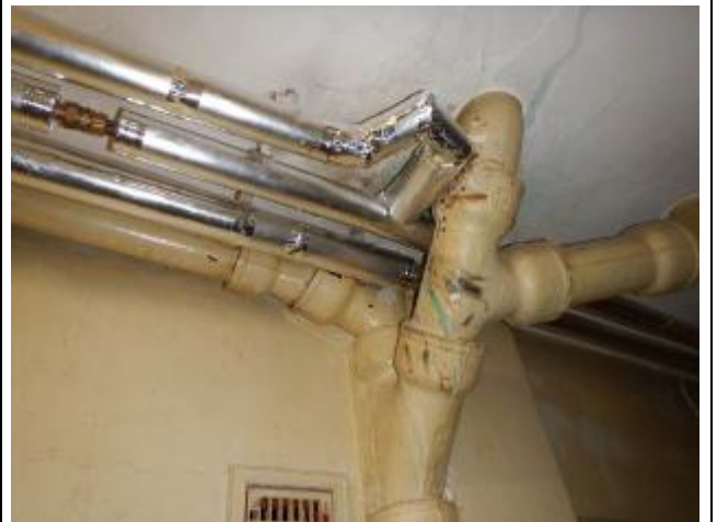
LVI-kuva 12. Päiväkodin puolella on vanhoja viemäreitä.
