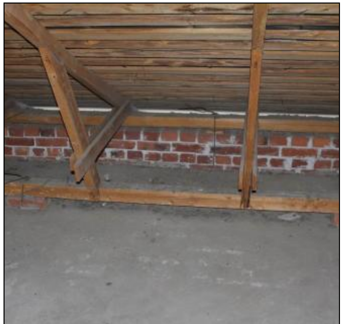
RAK-kuva 20 Alkuperäisen kouluosan yläpohjan kantavia puurakenteita
