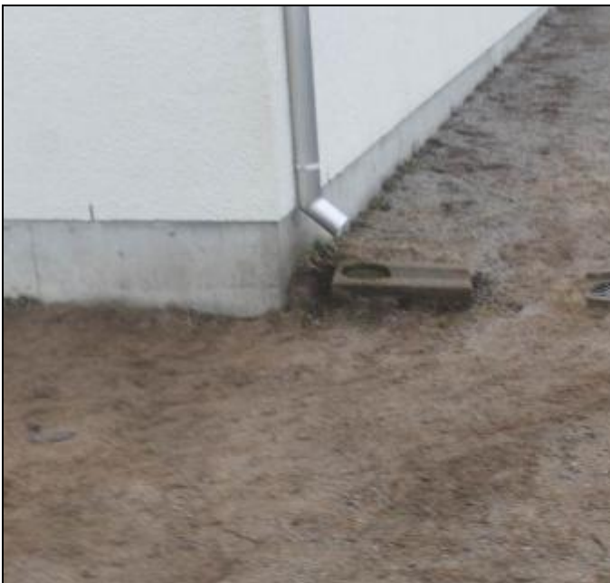
RAK-kuva 19. Pinnoittamaton betonisokkeli laajennusosalla.
