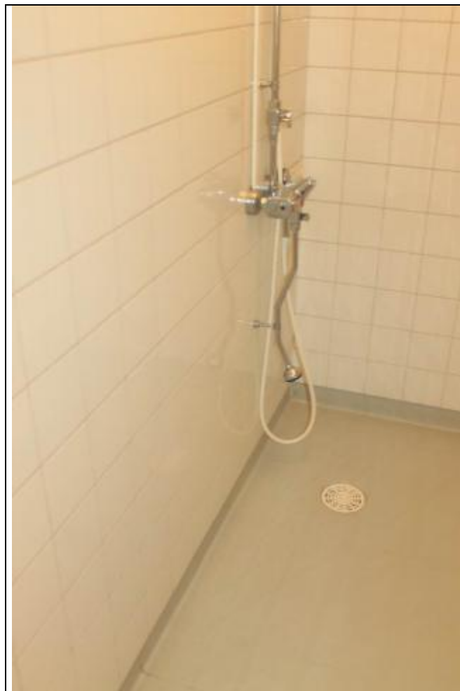
RAK-kuva Laajennusosan pesuhuone 60.
