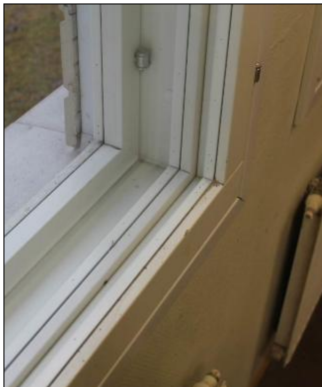
RAK-kuva 32. Koulun laajennusosan ikkuna
