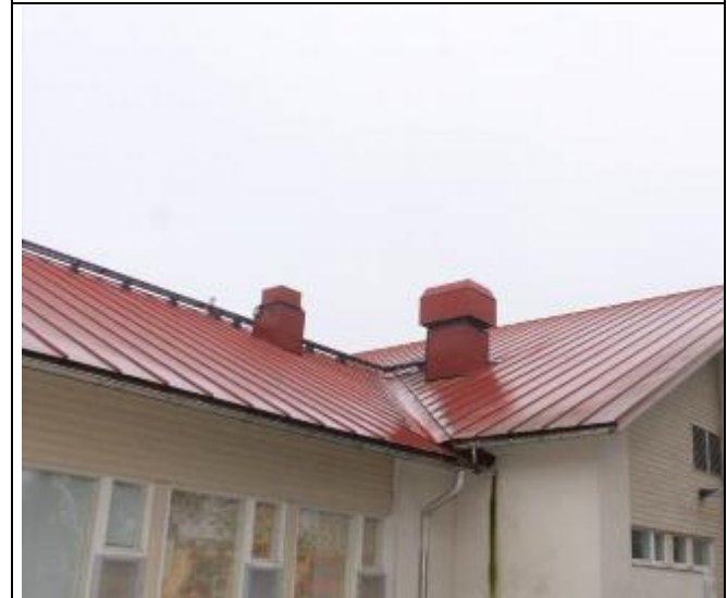
RAK-kuva 42. Vesikattoja laajennusosan alueella
