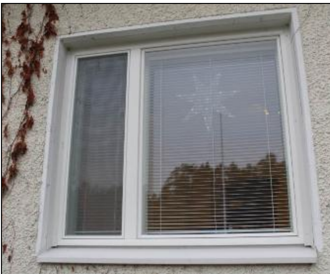
RAK-kuva 27. Uusittu puu-alumiini-ikkuna päiväkotiosalla
