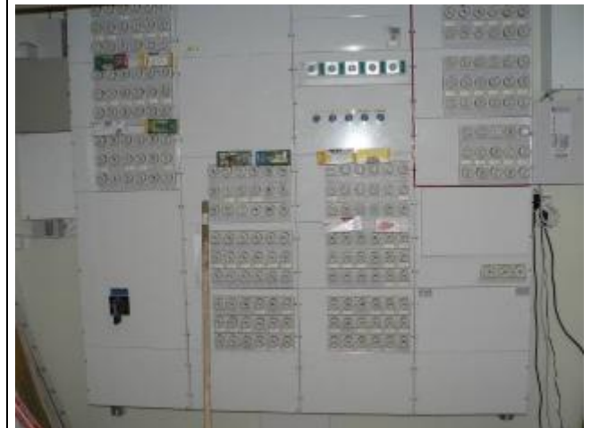
S-kuva 4. Tuulikaappiin asennettu jakokeskus JK-1.
