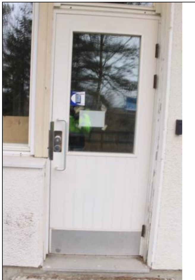
RAK-kuva 36. Laajennusosan ulko-ovi.
