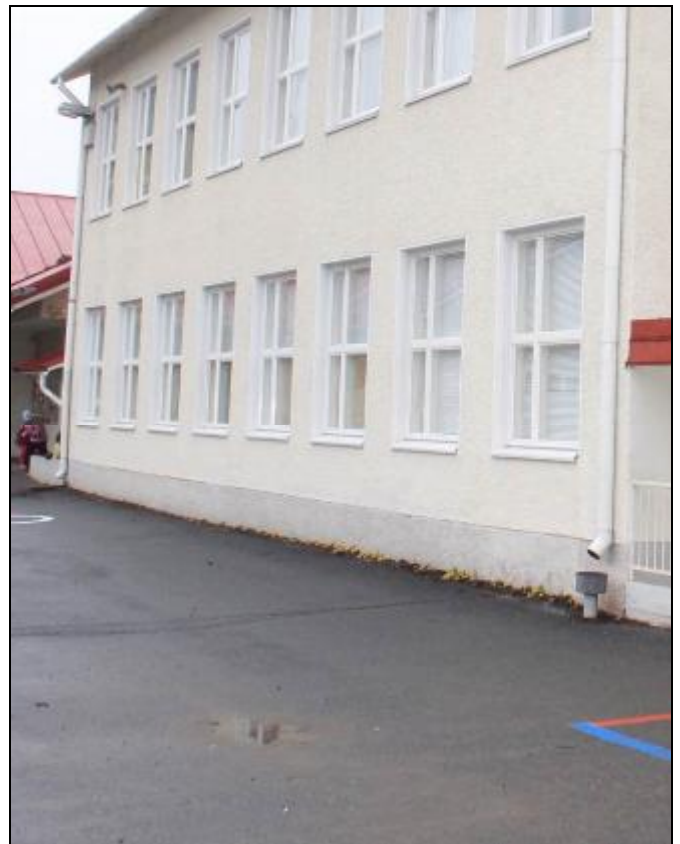
RAK-kuva 8. Kattovesien poistoja
