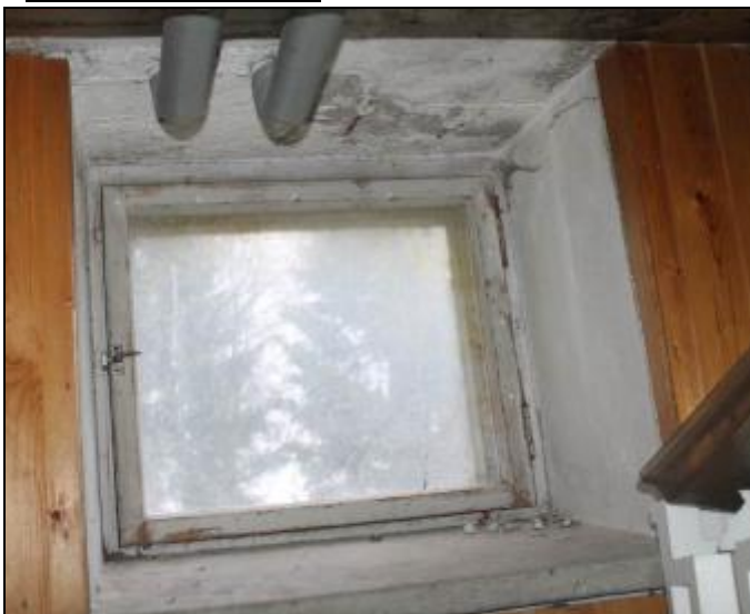
RAK-kuva 29. Alkuperäinen puukarmillinen kellarin ikkuna.
