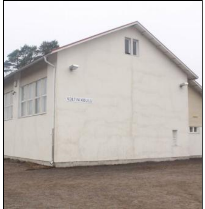
RAK-kuva 26. Rapattu julkisivuja laajennusosan liikuntahallin osalla
