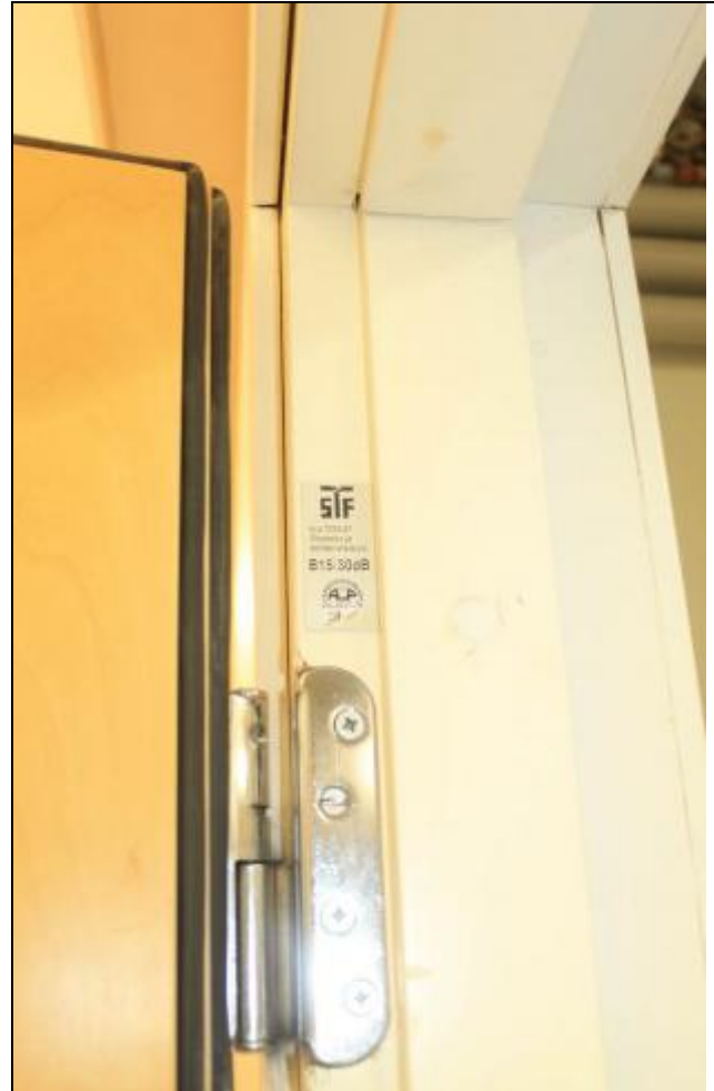
RAK-kuva 44. Desibeliluokiteltu luokkatilan ovi
