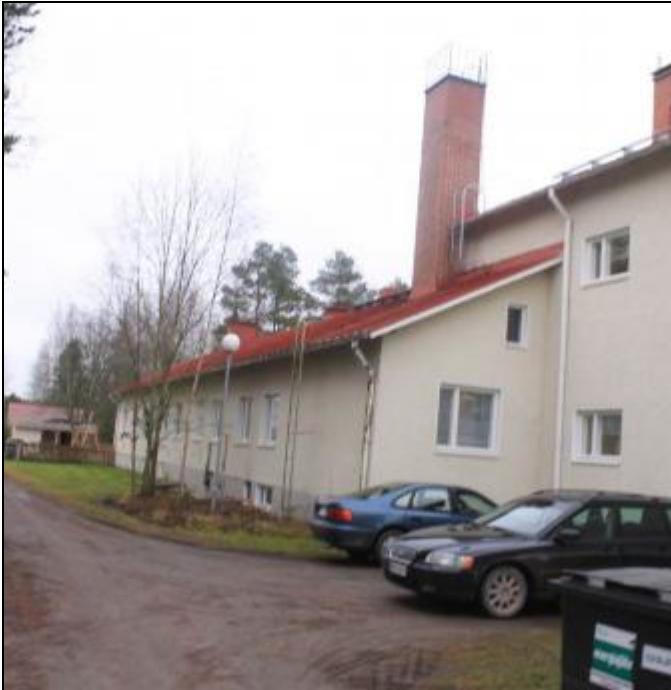
RAK-kuva 25. Rapattu julkisivuja alkuperäisen kouluosan ja päiväkotiosan alueella (pohjoispuoli)
