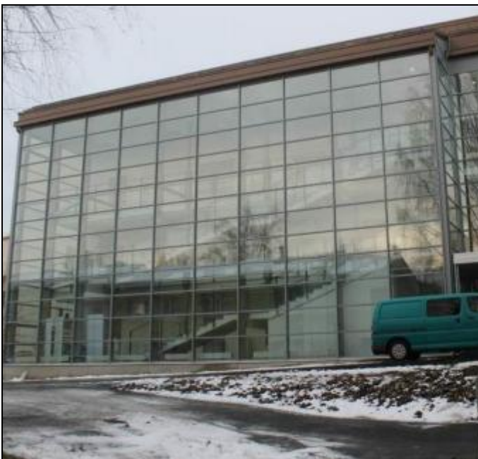
RAK-kuva 7. Etelänpuoleista lasijulkisivua
