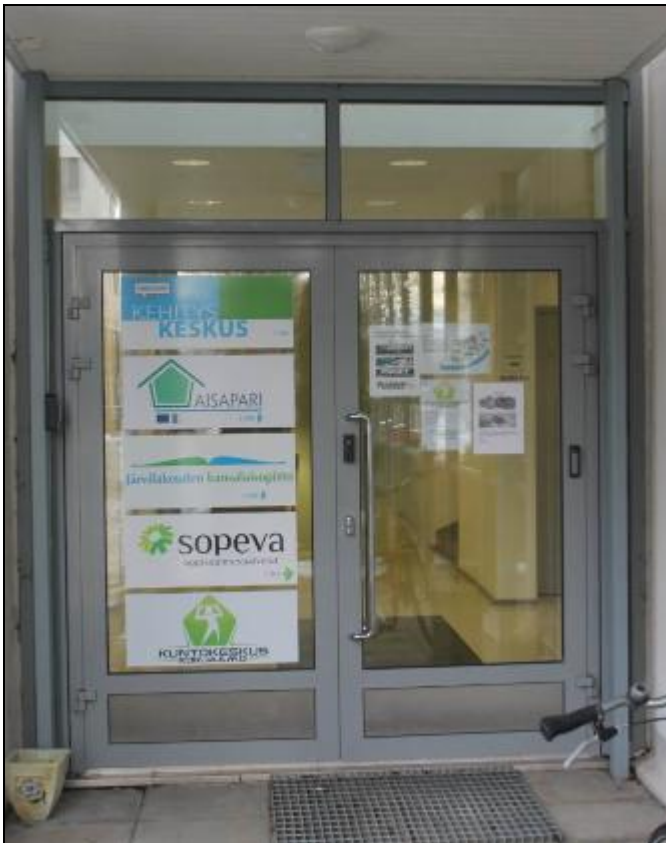
RAK-kuva 13. Hyväkuntoinen alumiiniprofiilirakenteinen, lasiaukollinen ulko-ovi
