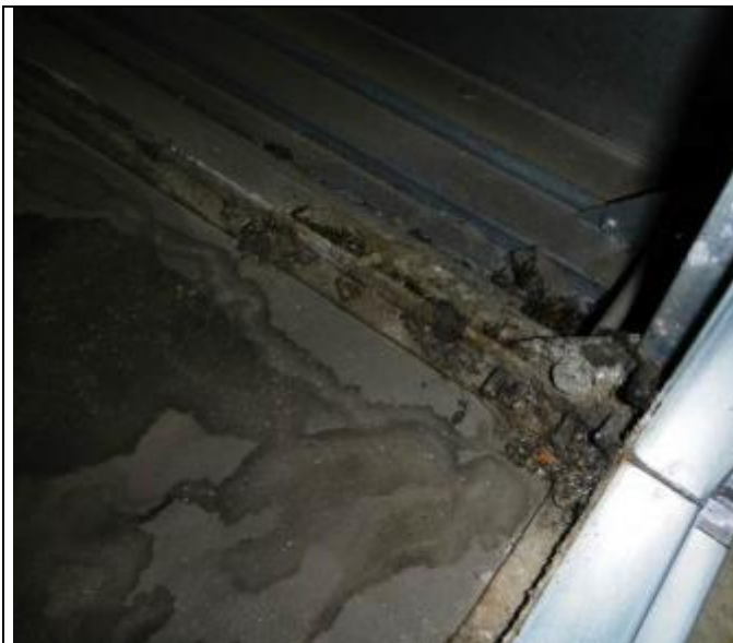
LVI-kuva 7. Yleiskuva TK2 koneen sisältä (epäpuhtauksia).
