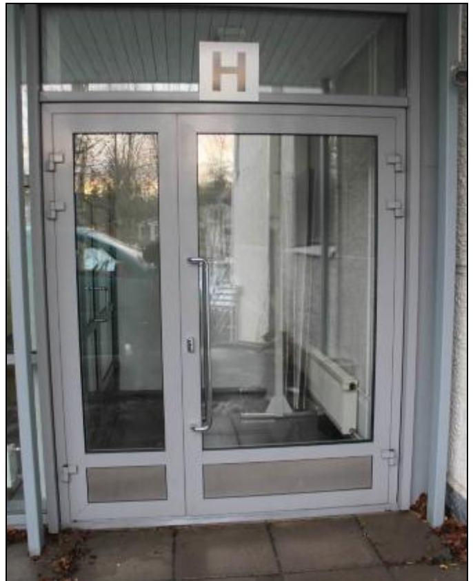
RAK-kuva 14. Hyväkuntoinen alumiiniprofiilirakenteinen, lasiaukollinen ulko-ovi
