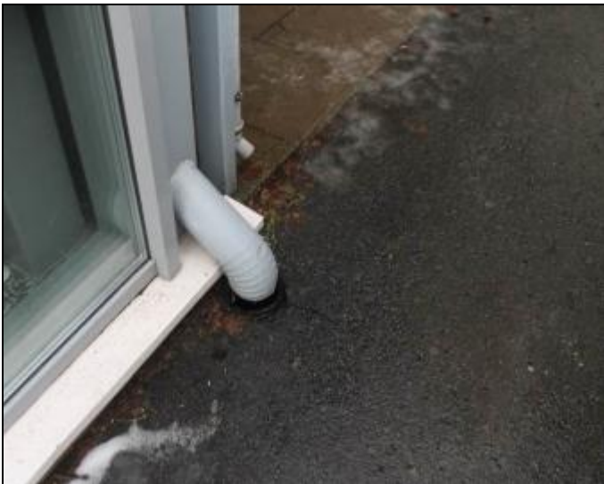
RAK-kuva 3. Kattovesien poistoa
