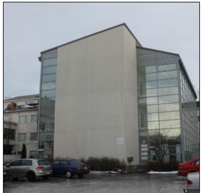
RAK-kuva 8. Länsipäädyn elementti- ja lasiseiniä.
