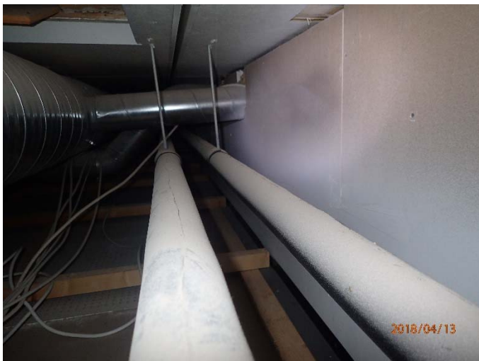
Kuva 28. Alakaton yläpuolella paksuhko pölykerros. Pölyn koostumisnäytteen mukaan pölyssä runsaasti kalkkipohjaista rakennuspölyä ja myös mineraalivillakuituja. Ks. liite 4.
