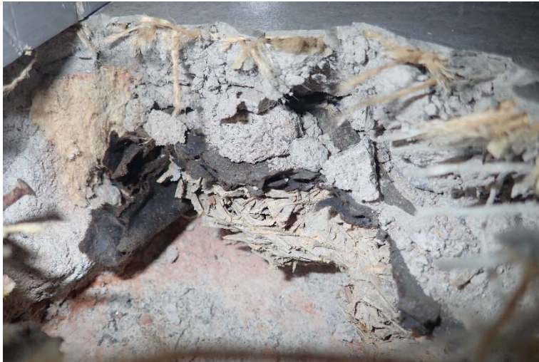
Kuva 21. Tilan 358 rakenneavaus. (Materiaalinäytteet M5, M7 ja M8)
