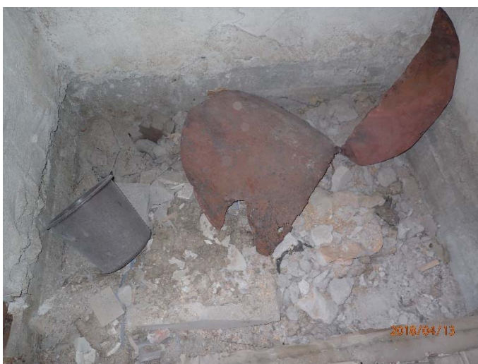
Kuva 29. Kaksoislaattapalkiston eristeet koostuvat osin rakennusjätteistä
