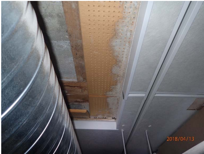
Kuva 27. 4 - kerroksen alakaton yläpuoli. Vanhat sisäkattoverhoukset ja puuosia on jätetty paikoilleen.
