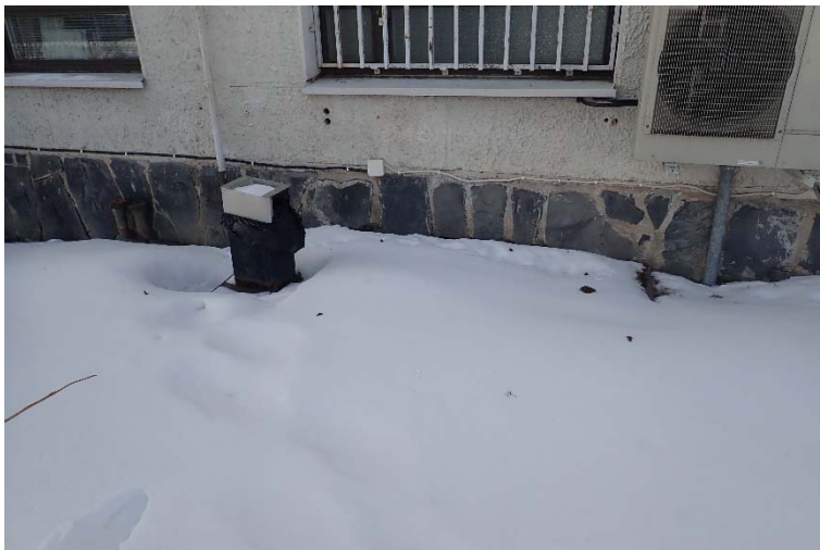
Kuva 3. Itäjulkisivu. Vanhan osan kivijalkana todennäköisesti laastilla perusmuuriin kiinnitetty kivilaatta
