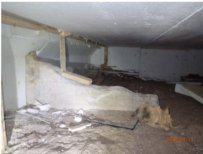
Kuva 16. Näkymä alapohjasta rakennusten liitosten kohdalla.
