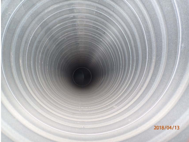
Kuva 30. Tilan 451 ilmanvaihtokanavat olivat puhtaita.
