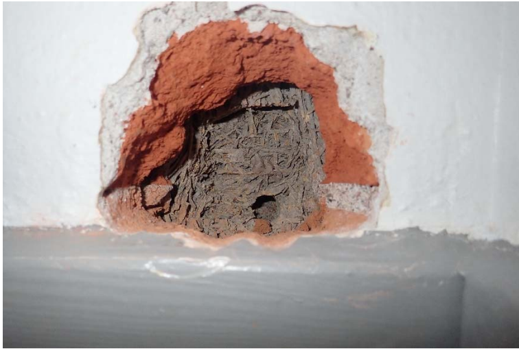
Kuva 11. Tilan 258 rakenneavauskohta jalkalistan yläpuolelle. (M9).
