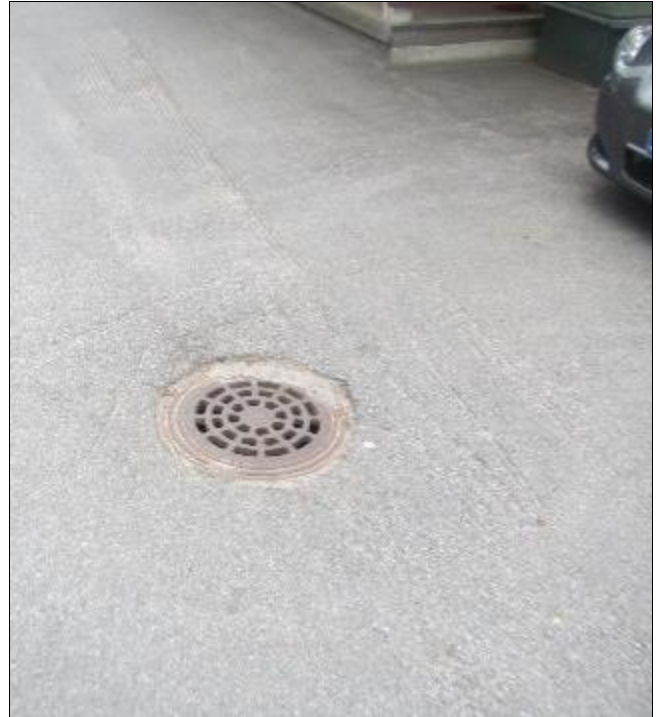
RAK-kuva 6. Asfalttialueella sade- ja sulamisvedet ohjataan sadevesikaivoihin
