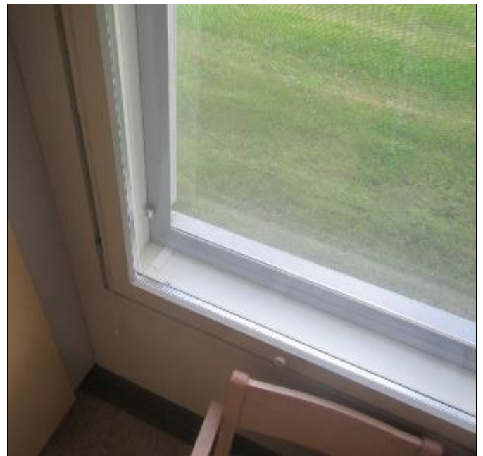
RAK-kuva 24 Rakennuksen ikkunoita, puu-alumiini-ikkunat.
