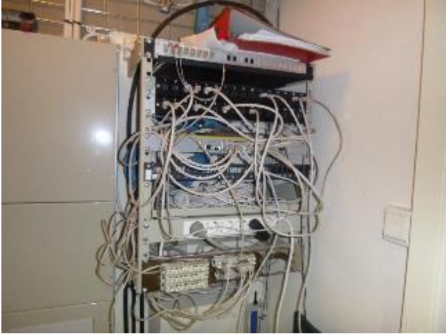
S-kuva 11. Pääkeskuskomeroon asennettu talojakamo.
