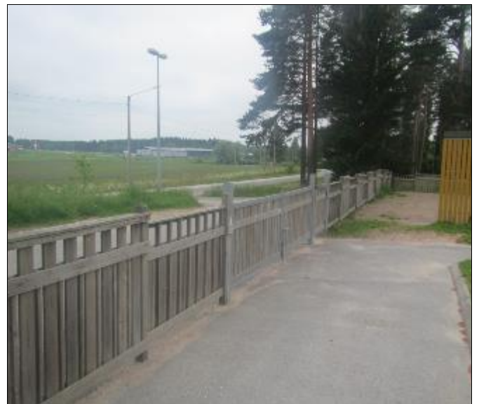
RAK-kuva 16. Puurakenteista raja-aitaa
