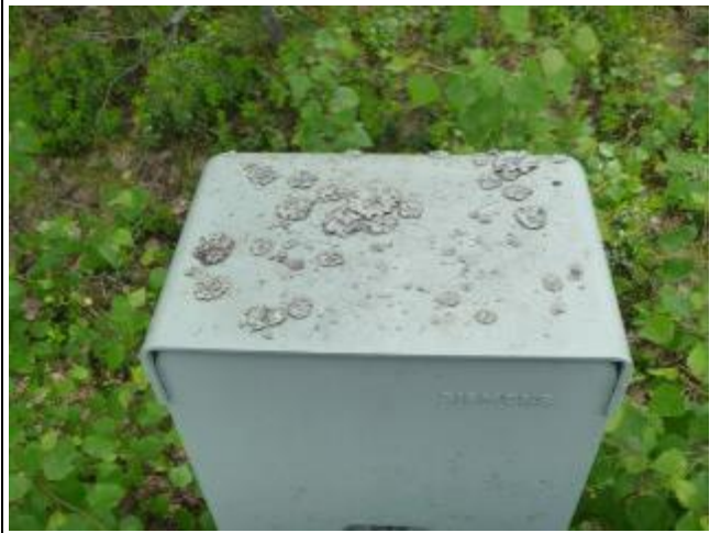
S-kuva 6. Autolämmityspistorasiakoteloiissa kasvaa jäkälää.
