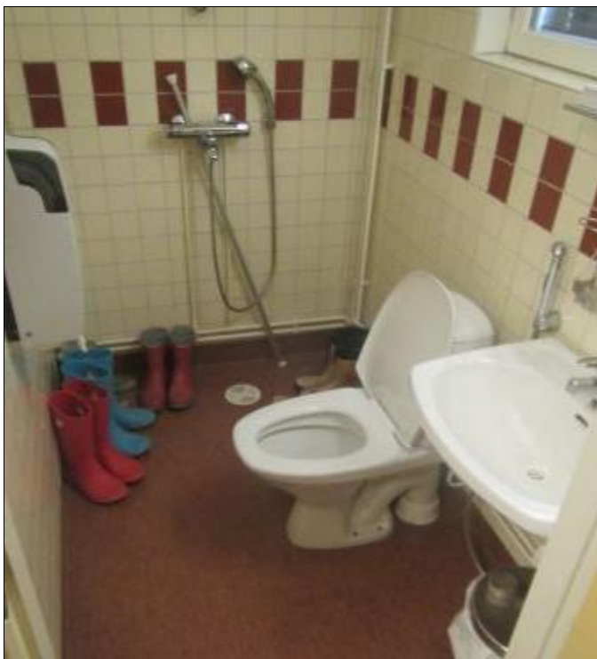
RAK-kuva Wc- pesuhuonetilaa 41.
