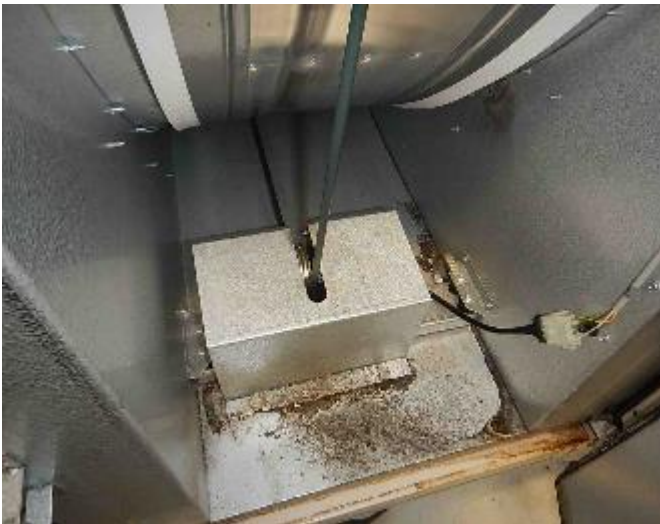
LVI-kuva 11. LTO-kiegon kammiossa on epäpuhtauksia.
