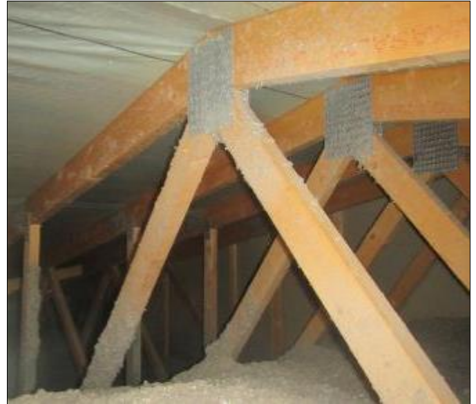
RAK-kuva Nivelosan yläpohja 18.
