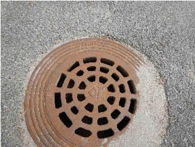
LVI-kuva 5. Yleiskuva kaivosta.
