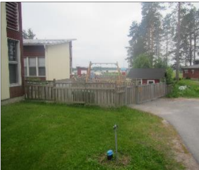
RAK-kuva 15. Puurakenteista raja-aitaa
