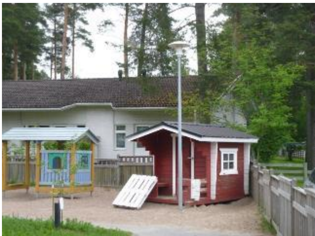
S-kuva 9. Yleiskuva pylväsvalaisimesta.
