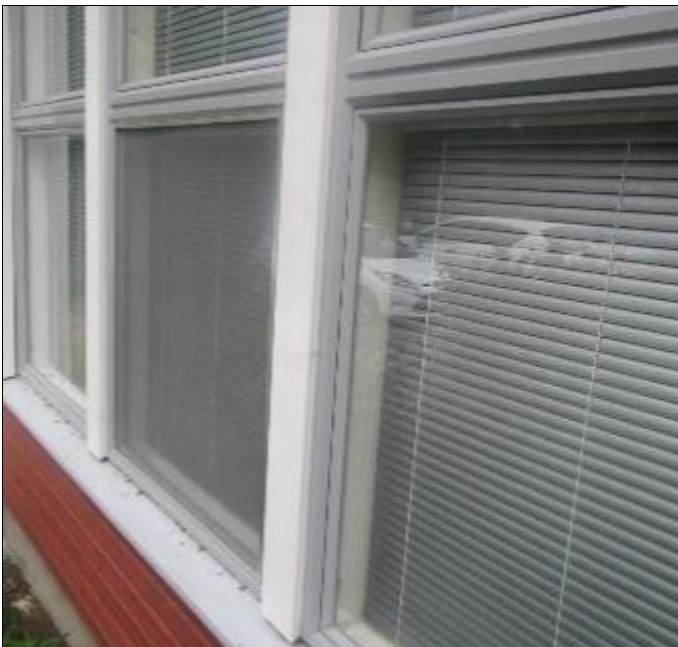
RAK-kuva 23. Rakennuksen ikkunoita, puu-alumiini-ikkunat.
