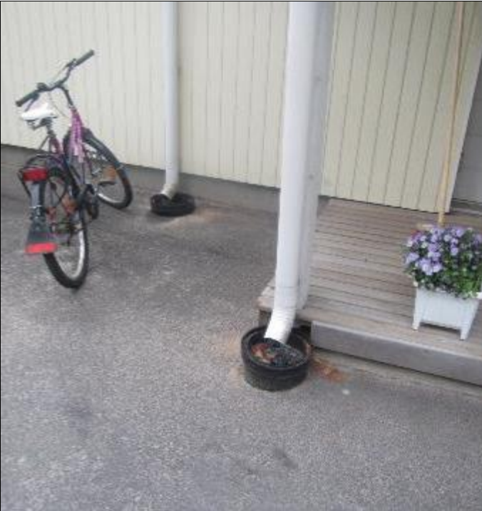
RAK-kuva 5. Kattovesien poistot on ohjattu hallitusti rännikaivoihin
