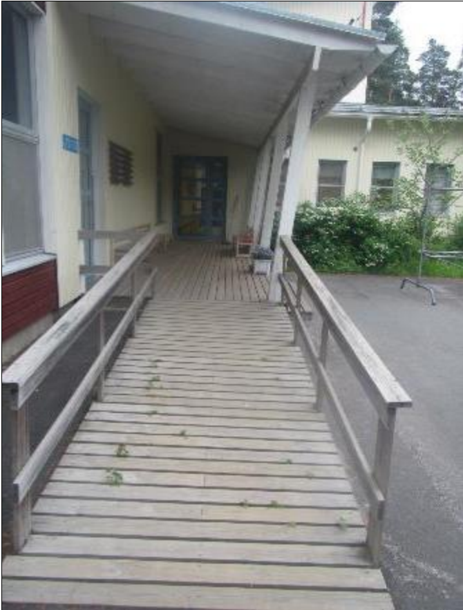
RAK-kuva Katosrakenteita ja porrasluiskia 31.
