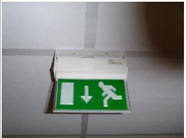
S-kuva 10. Merkkivalaistusjärjestelmän yksikkövalaisin.
