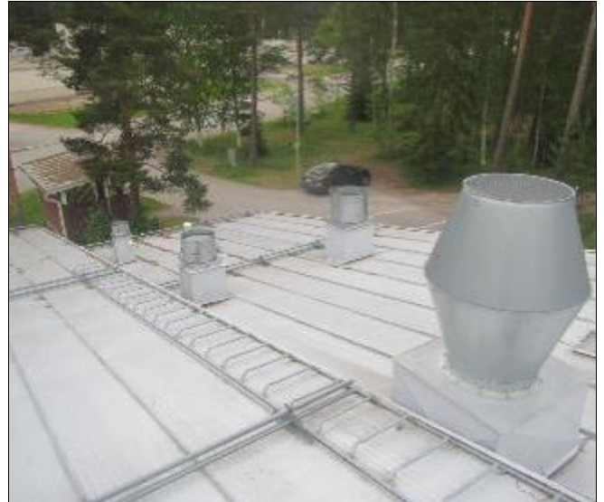
RAK-kuva Vesikattoja ja vesikattovarusteita 36.
