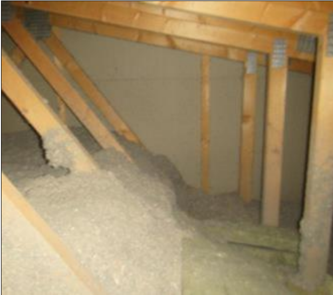
RAK-kuva Nivelosan yläpohja 17.
