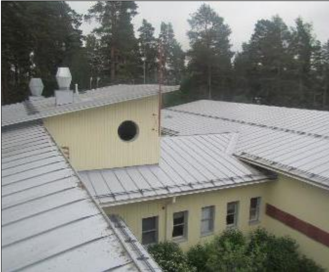
RAK-kuva Vesikattoja ja vesikattovarusteita 35.
