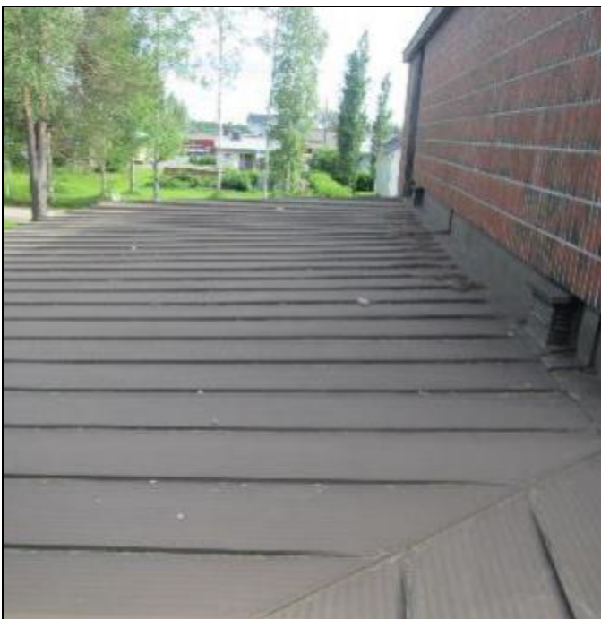
RAK-kuva Punttialin päädyn vesikattoa 25.
