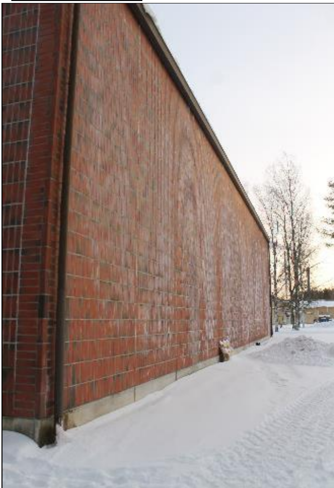
RAK-kuva 11. Julkisivuja, valokuva keväältä 2016 Etelänpuolen julkisivurakenteessa runsaasti "kalkkikertymä"
