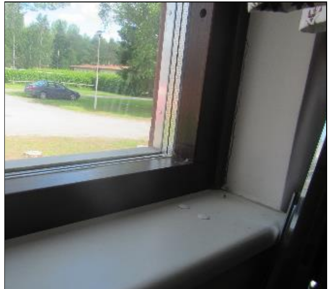
RAK-kuva 18. Yleiskuva kiinteästä ikkunasta
