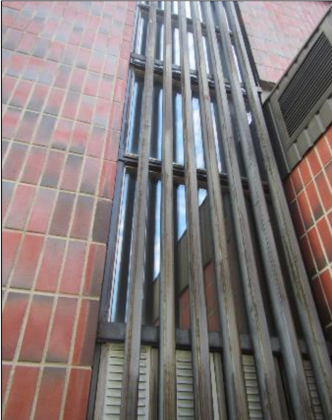
RAK-kuva Voimistelusalin päädyn ikkunoita 19.
