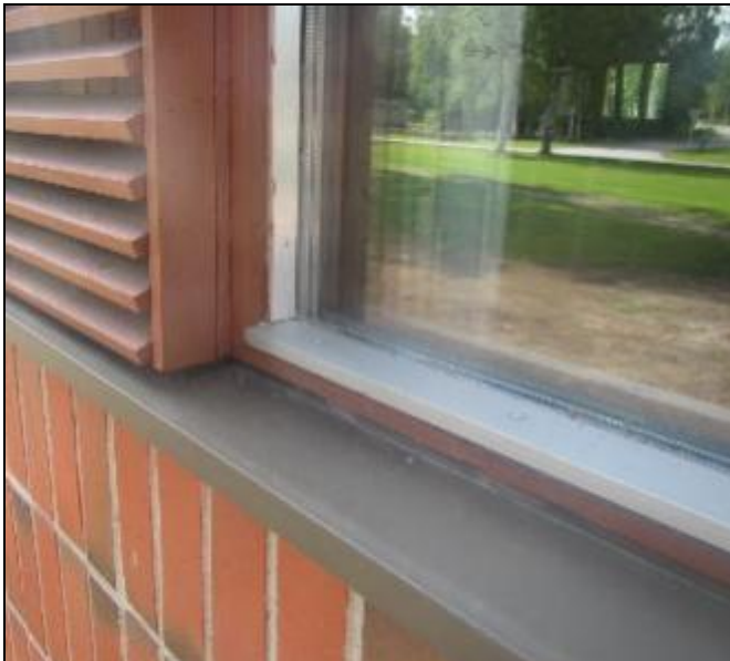
RAK-kuva 17. Yleiskuva kiinteästä ikkunasta
