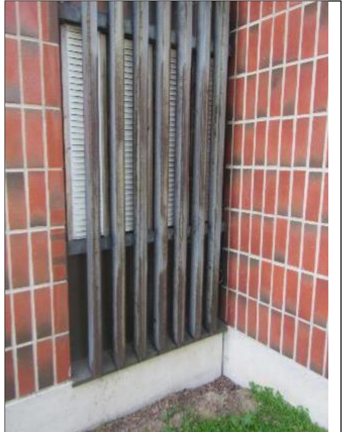
RAK-kuva 20 Voimistelusalin päädyn ikkunoita
