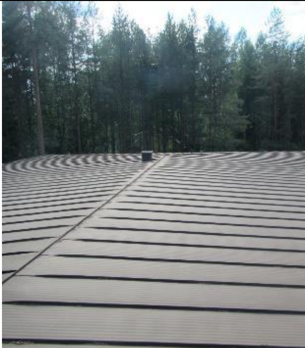
RAK-kuva Yleiskuva saliosan vesikatolta 23.
