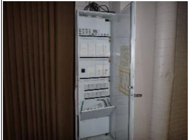
S-kuva 2. Näyttämölle asennettu ryhmäkeskus O11.
