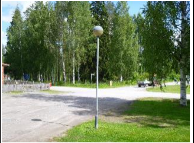
S-kuva 6. Ulkoalueen pylväsvalaisin.
