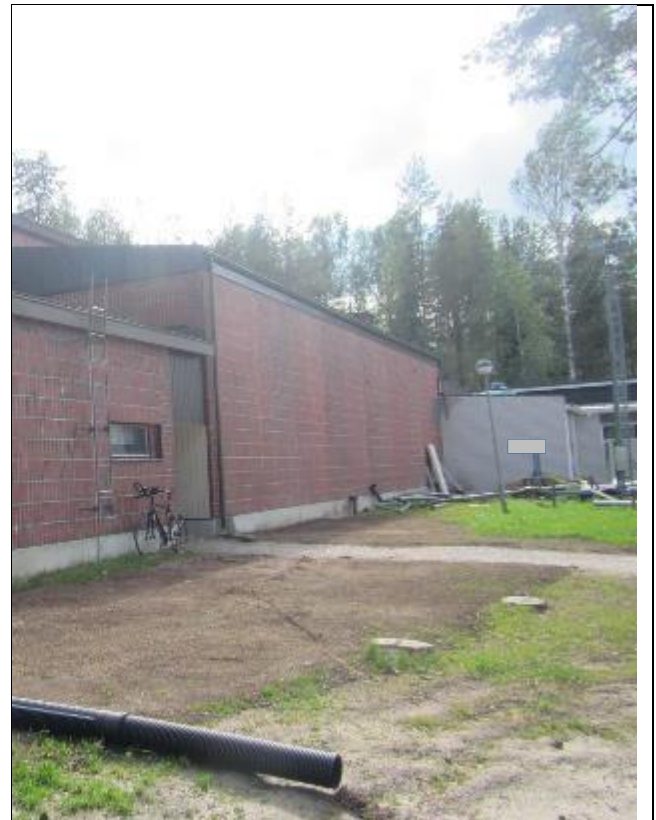
RAK-kuva 4. Yleiskuva itä ja pohjoispuolen pihalueelta. Alueen nurmikoita on osin uudistettu.
