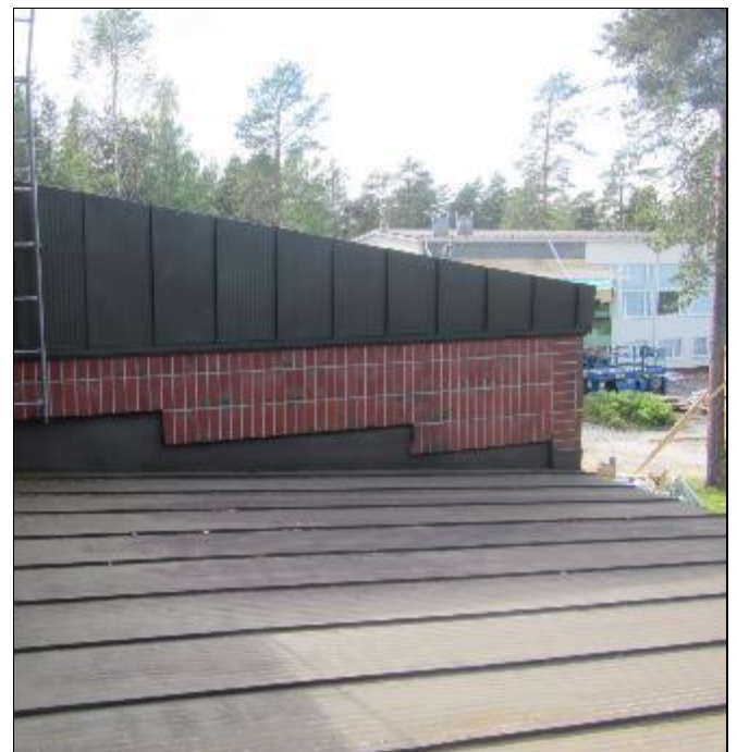
RAK-kuva Punttialin alueen vesikattoa 26.
