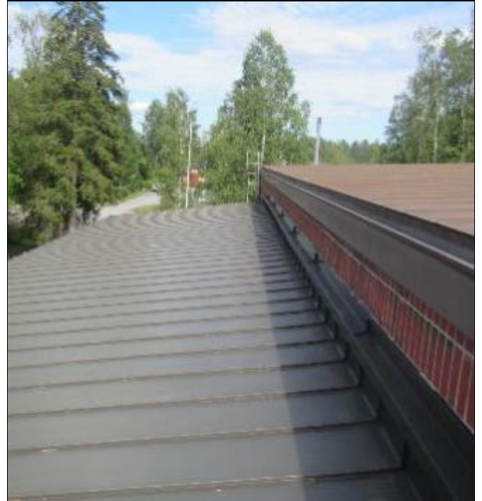
RAK-kuva Yleiskuva näyttämön alueen vesikatolta. Lähtötietojen perusteella ko vesikateosuus on uusittu ja yläpohjaa lisälämmöneristetty
