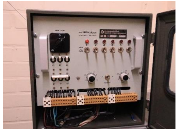
Kuva 68 Kompensoinnin säädin.
