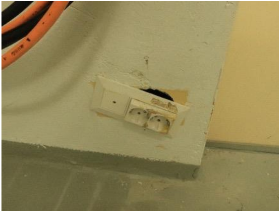
Kuva 71 Yleiskuva irronneesta pistorasiasta.
