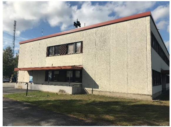
Kuva 21 Päädyn nuorisotilaan johtava portaan kohdalla oleva katoslippa.
