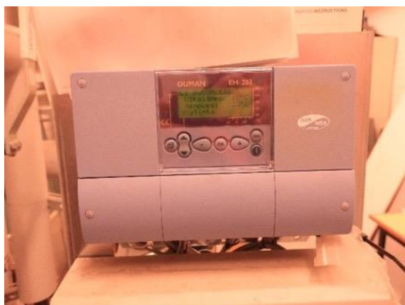
Kuva 83 Lämmönjakohuoneen yksikkösäädin.
