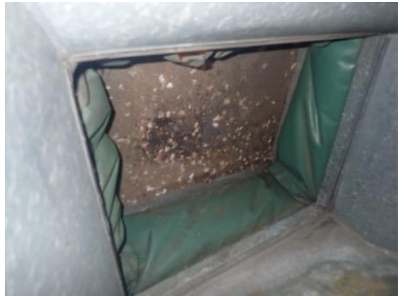
Kuva 56 Yleiskuva koneiden epäpuhtauksista.
