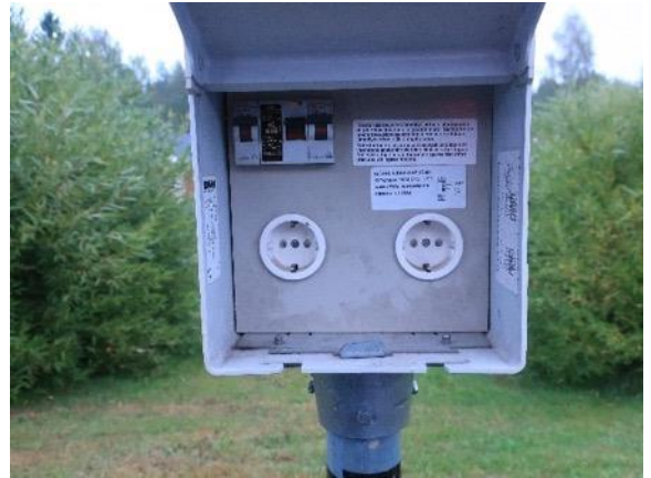
Kuva 72 Vanhemman mallinen autolämmityspistorasia.
