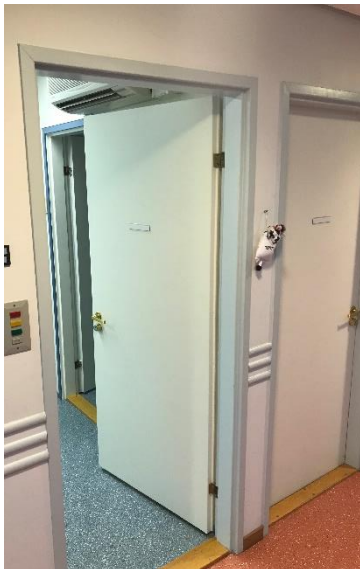
Kuva 28 2. kerroksen toimistuhuoneen laakaovi
