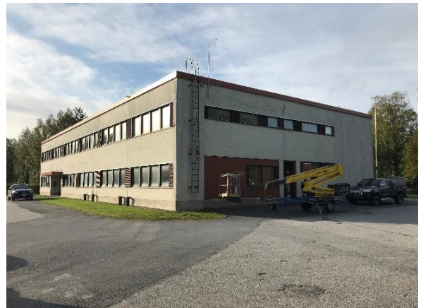
Kuva 15 Yleiskuva rakennuksen julkisivuista
