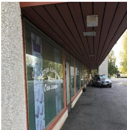
Kuva 18 Liiketilöjen metalliprofiilirakenteisia ikkunoita.
