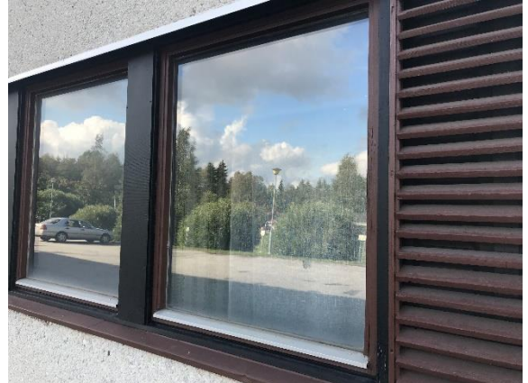
Kuva 17 Museo-osan ikkuna ulkopuolelta kuvattuna
