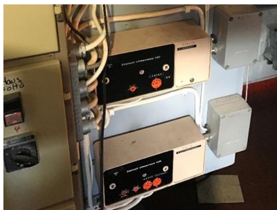
Kuva 84 Iv-konehuoneen yksikkösäätimet.
