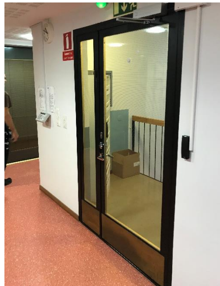
Kuva 29 2. kerroksen porraskäytävän palo-ovi
