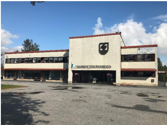
Kuva 14 Yleiskuva rakennuksen julkisivuista
