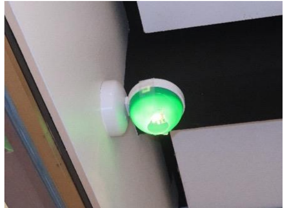
Kuva 78 Rikkinäinen opasvalaisimen kupu.
