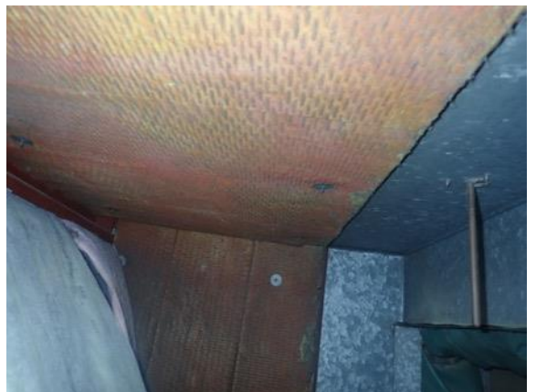
Kuva 58 Koneissa on suojaamattomia mineraalivillapintoja.
