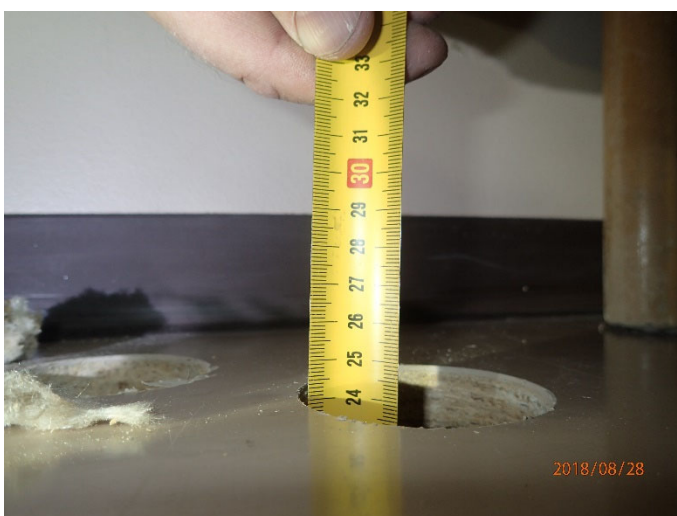
Kuva 6. Opetusvälinevaraston alapohjarakenteen kerrospaksuus pohjalaatan päältä.
