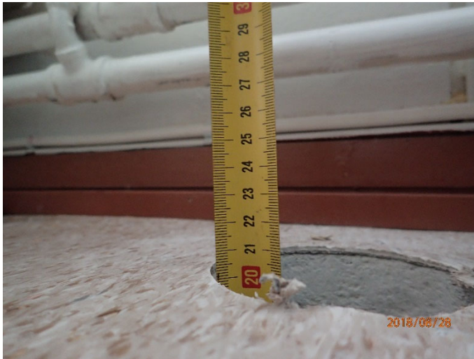
Kuva 4. Eskarin alapohjarakenteen paksuus pohjalaatan päältä.
