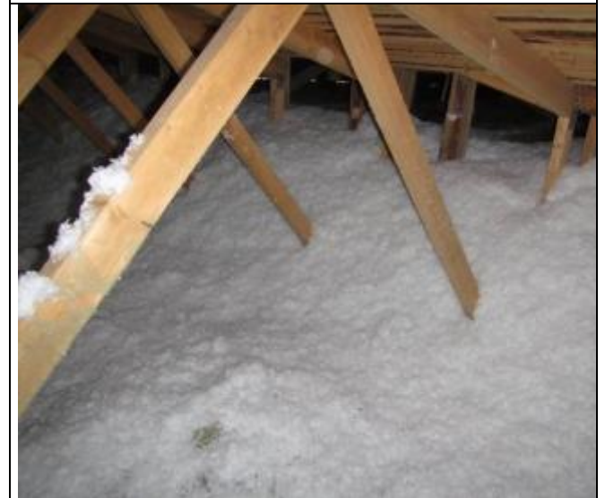
RAK-kuva 44. Laajennusosan yläpohjatilaa, tilaan puhallettu lisälämmöneristystä.
