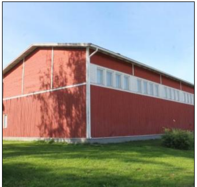
RAK-kuva 20 Yleiskuva liikuntahalliosan puujulkisivuista.
