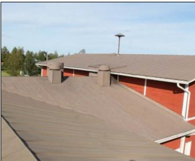
RAK-kuva 39. Yleiskuvaa vanhan osan vesikatolta laajennusosan vesikatoille.
