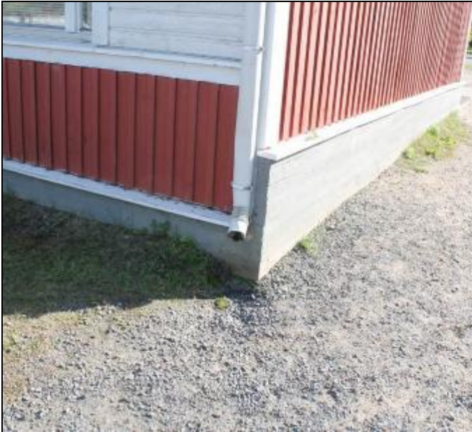
RAK-kuva 9. Kattovesien poisto on laajennusosan päädyllä suoraan sokkelin viereen.
