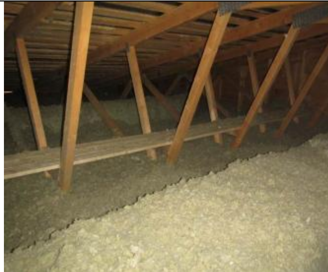
RAK-kuva 45. Liikuntahallin yläpohjatilaa ja vesikaton alustarakenteita.
