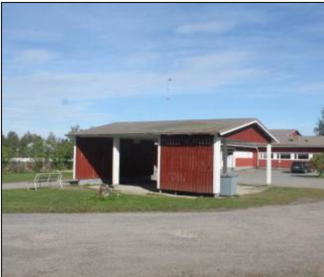
RAK-kuva 15. Piha-alueen varasto "sadekatos/jätteidenkeräyspiste".
