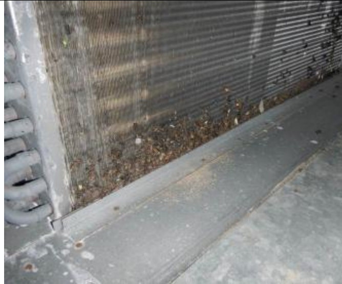
LVI-kuva 19. Lämmityspatterissa on runsaasti kuolleita hyönteisiä.
