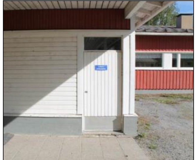
RAK-kuva 34. Laajennusosan alkuperäinen paneliverhoiltu ovi (sähköpääkeskus).
