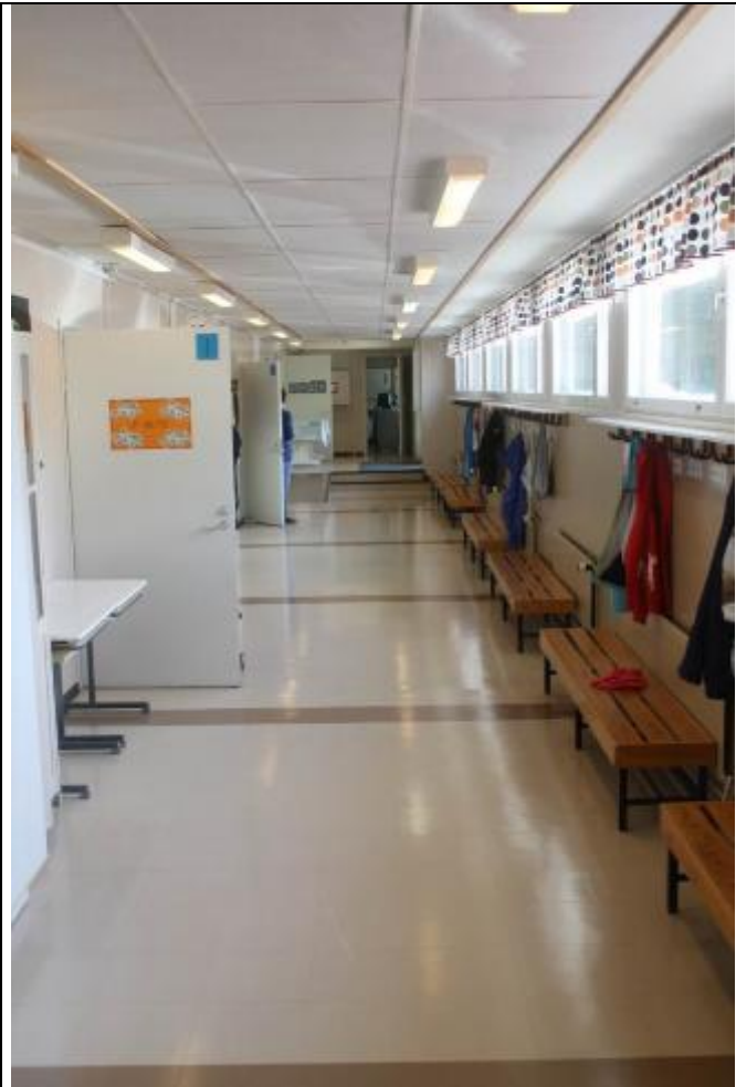
RAK-kuva 49. Yleiskuva vanhan osan käytävältä pintamateriaaleineen.
