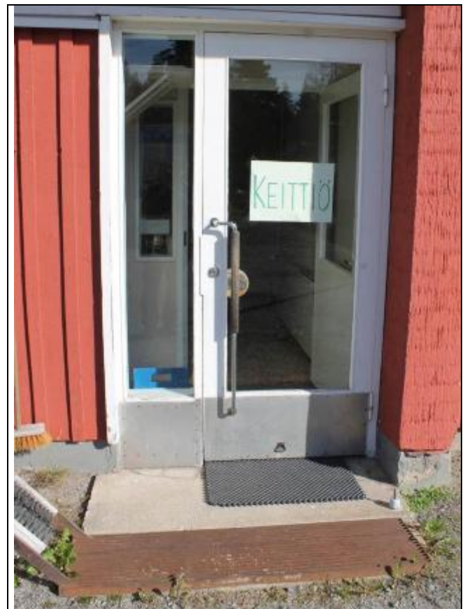
RAK-kuva 32. Vanhan osan alkuperäinen puurakenteinen, lasiaukollinen ulko-ovi.
