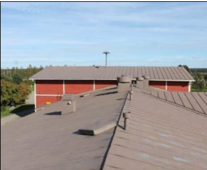
RAK-kuva 35. Yleiskuva laajennusosan vesikatolta.
