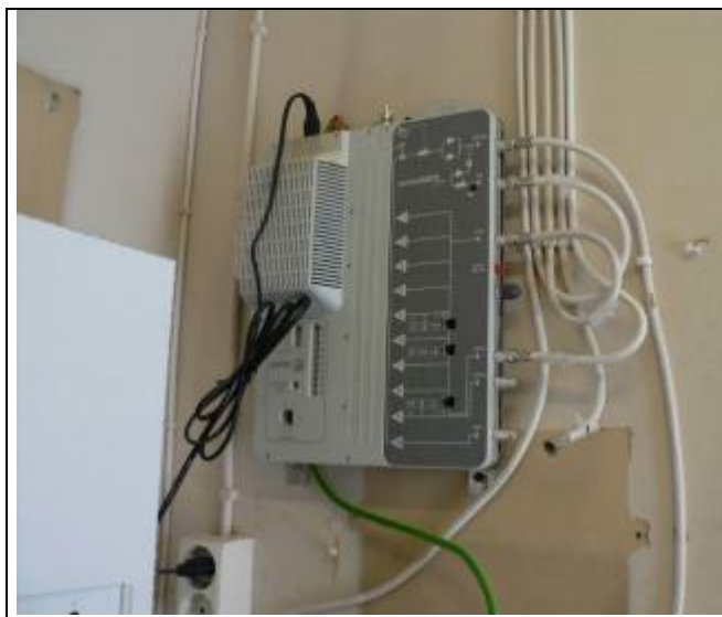
S-kuva 18. Yleiskuva antennivahvistimesta.
