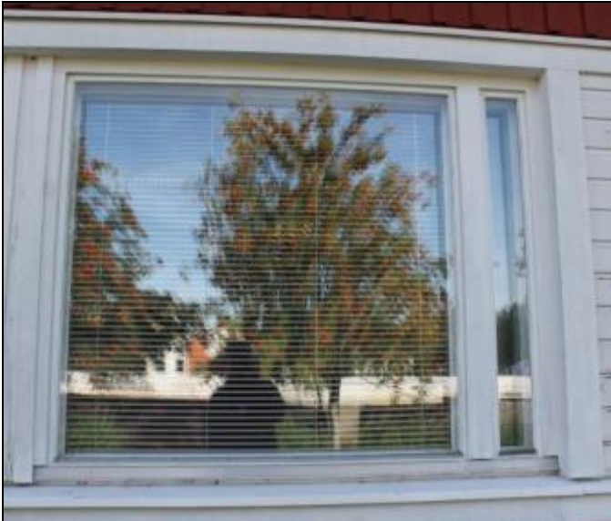
RAK-kuva 29. Laajennusosan luokkatilan tyypillinen 3-lasinen ikkuna.
