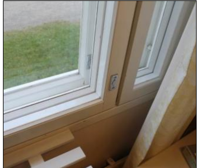
RAK-kuva 30. Laajennusosan luokkatilan tyypillinen 3-lasinen ikkuna.
