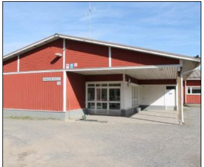
RAK-kuva 16. Laajennusosan päädyn sisäänkäyntikatos.
