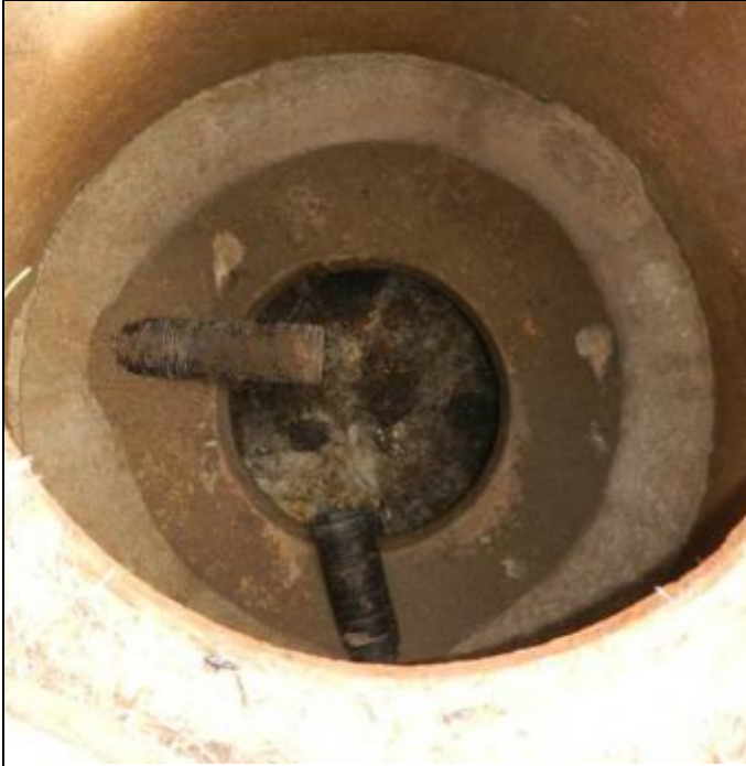
RAK-kuva 5. Liikuntahallin pohjoispuolella oleva sakokaivo. Kaivoon on johdettu 2 kpl salaojaputkia.
