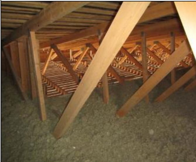
RAK-kuva 43. Laajennusosan yläpohjatilaa ja vesikaton alustarakenteita.
