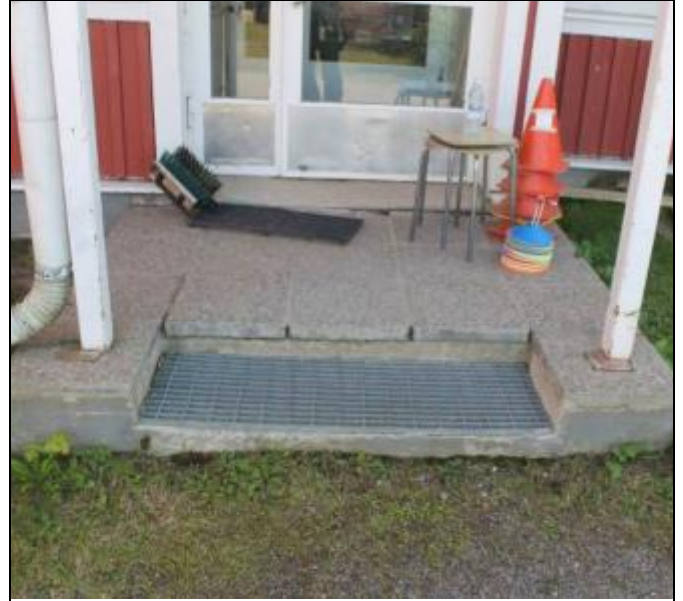
RAK-kuva 18. Betoniporras, päällystetty pesubetoni-laatoin.
