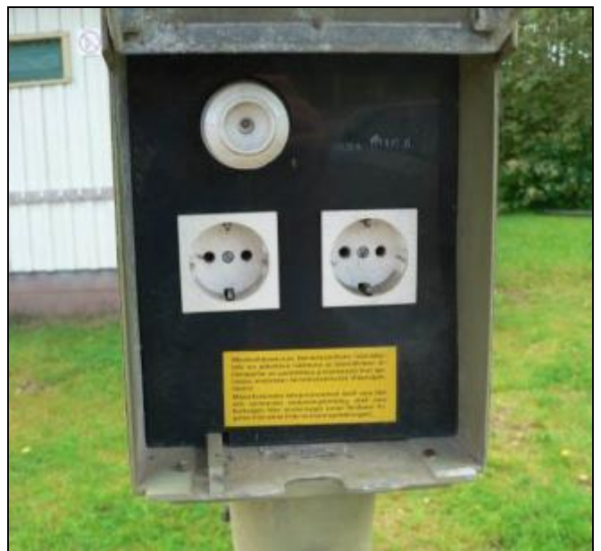
S-kuva 8. Yleiskuva vanhemmasta autolämmituspistorasiasta.
