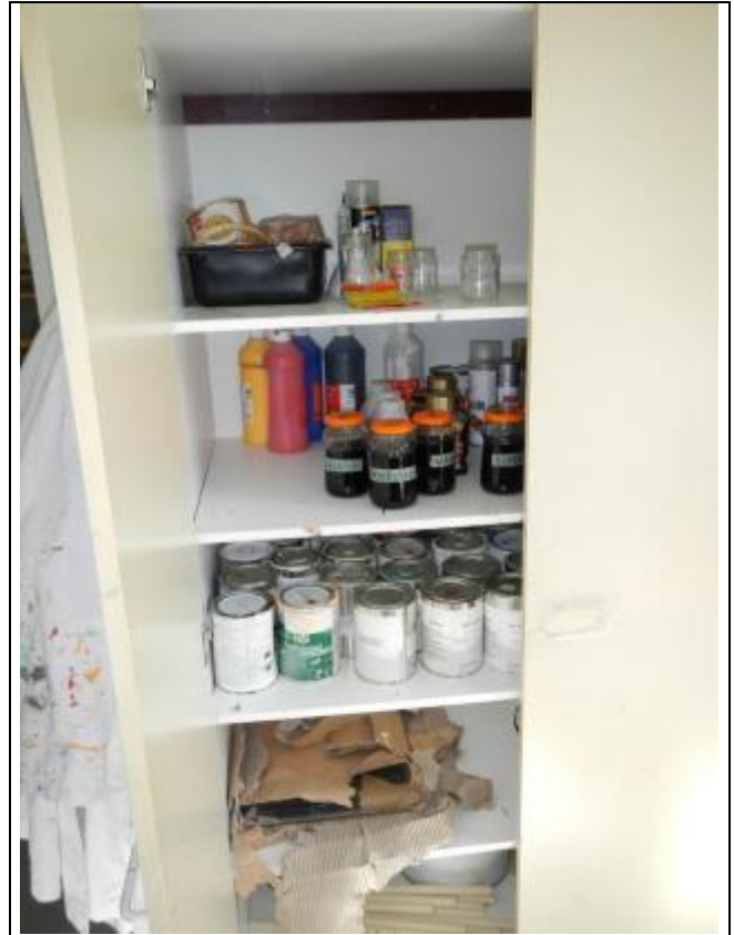
LVI-kuva 24. Teknisen työn maalikaapissa ei ole erillispoistoa.
