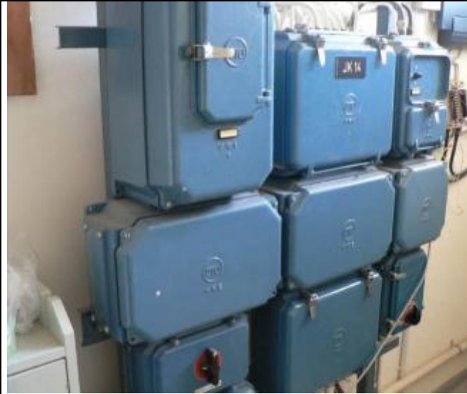
S-kuva 5. Vanha valurautainen pääkeskus toimii nykyisin ryhmäkeskuksena.
