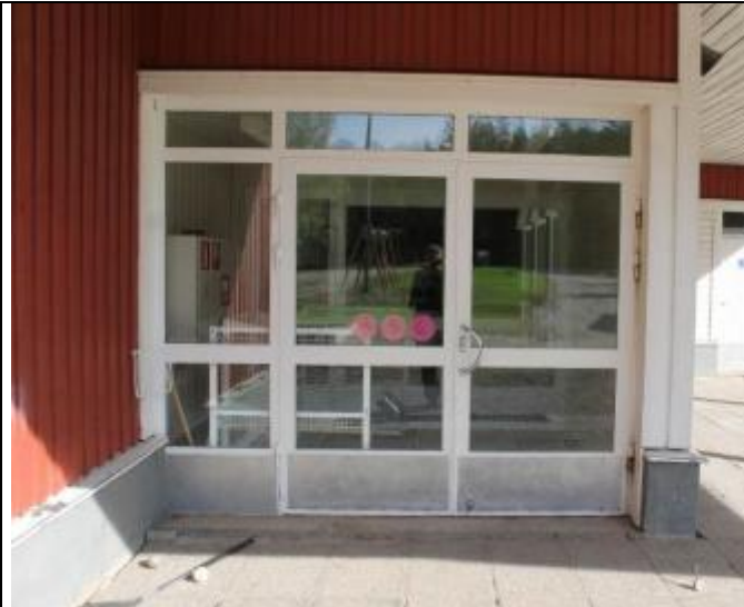
RAK-kuva 33. Laajennusosan alkuperäinen metallirakenteinen, lasiaukollinen pääulko-ovi.
