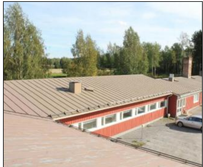
RAK-kuva 36. Yleiskuva laajennusosan vesikatolta vanhan osa vesikatoille.
