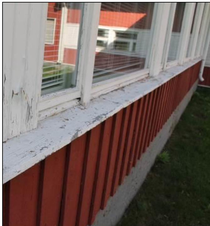
RAK-kuva 26. Vanhan osan alkuperäinen ikkunalinja rakennuksen pohjoispuolella.
