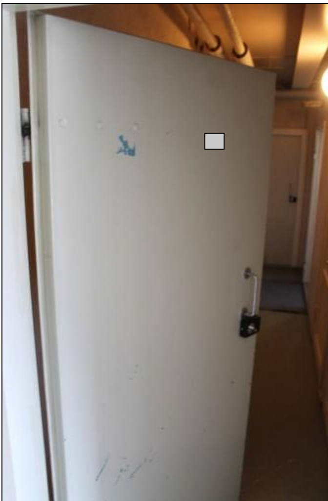
RAK-kuva 47. Vanhan osan alkuperäinen metallirakenteinen palo-ovi.
