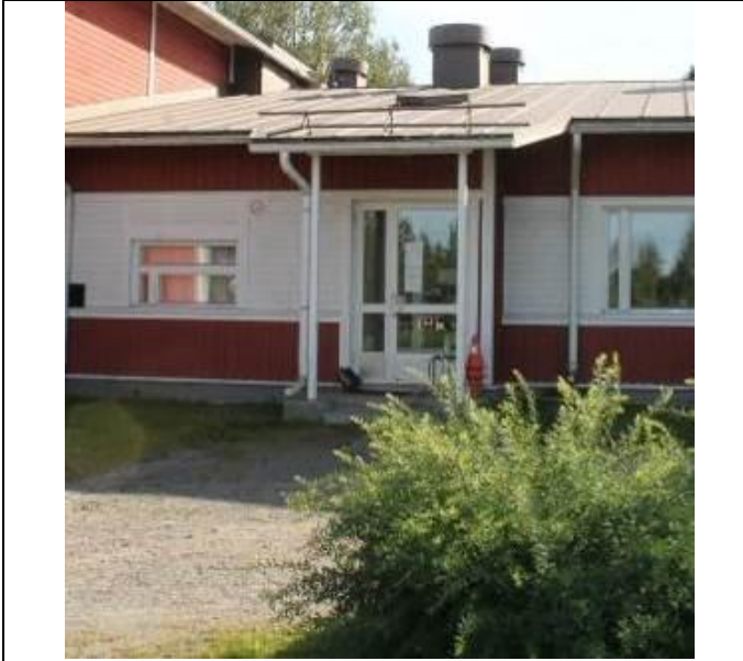
RAK-kuva 17. Laajennusosan länsipuolella sisäänkäynnin kohdalla oleva katoslippa.
