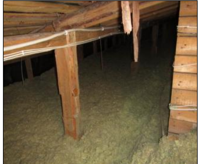
RAK-kuva 42. Vanhan osan yläpohjatilaa ja vesikaton alustarakenteita.
