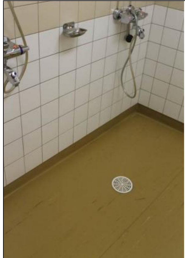
RAK-kuva Liikuntasalin pesuhuone. 58.
