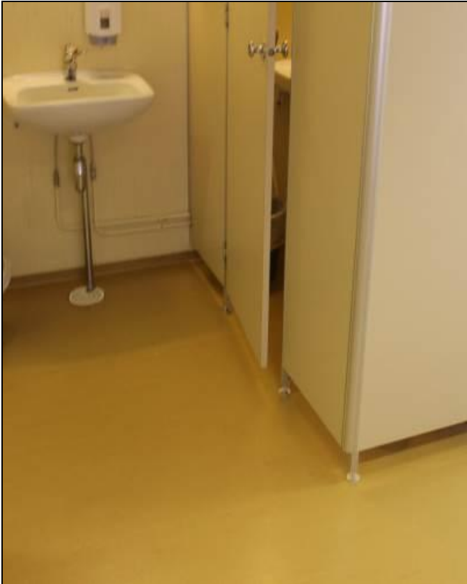
RAK-kuva Liikuntasalin pukuhuone / wc. 57.
