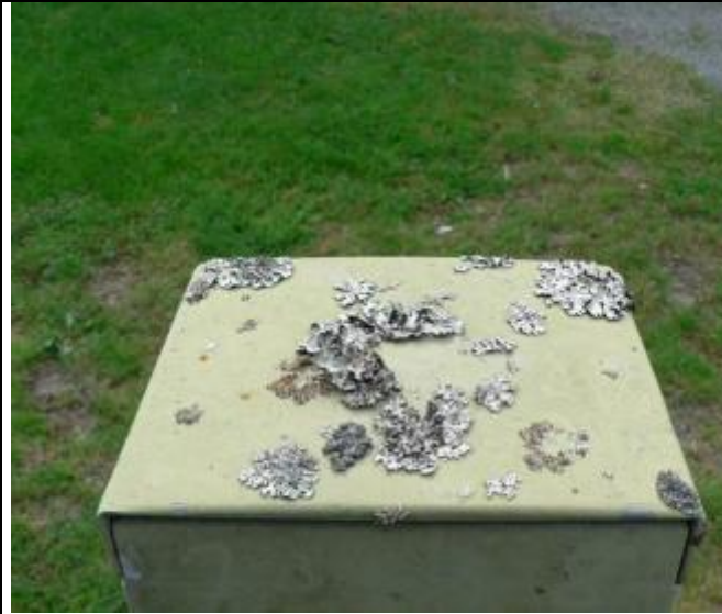
S-kuva 9. Pistorasiakoteloiden päällä kasvaa jäkälää.
