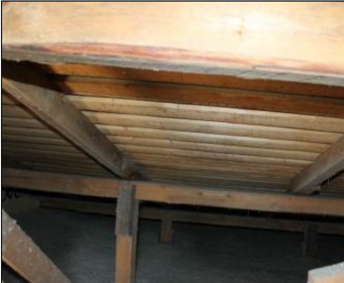
RAK-kuva 41. Vanhan osan yläpohjatilaa ja vesikaton alustarakenteita.
