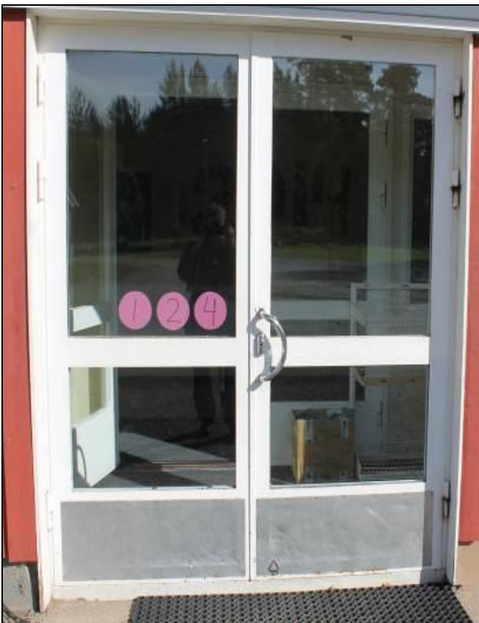
RAK-kuva 31. Vanhan osan alkuperäinen metallirakenteinen, lasiaukollinen pääulko-ovi.
