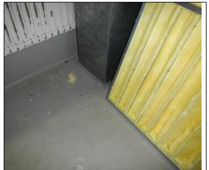
LVI-kuva 18. Uusien suodattimien säilytys mahdollistaa niiden likaantumisen.
