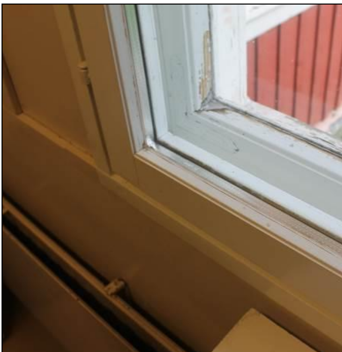
RAK-kuva 27. Vanhan osan alkuperäinen ikkuna. Vuoden 1986 peruskorjauksen yhteydessä sisäpuitte on uusittu ja sisäpuitteeseen on asennettu umpiolasielementti.
