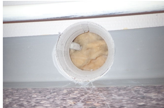
Kuva 1. Vuonna 1974 rakennetun ulkoseinän rakenneavauskohta. Perusmuurin yläpinta 22 cm lattiapinnan alapuolella. Kohdasta otettiin materiaalinäyte RM2019-070 mikrobi 2
