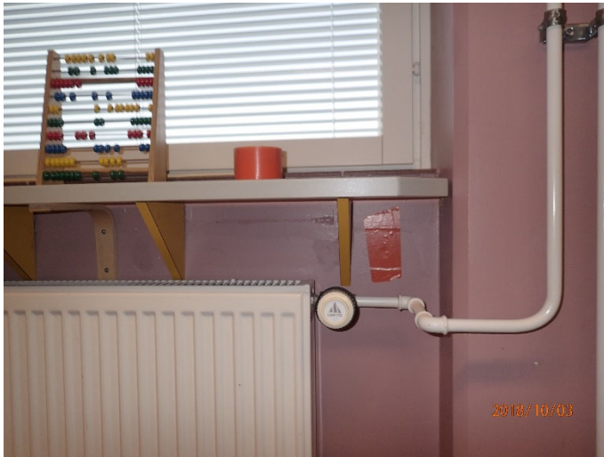
Kuva 2. Laajennusosan ulkoseinä on todennäköisesti tiivistettävissä, koska kyseessä rapatut kivipinnat.
