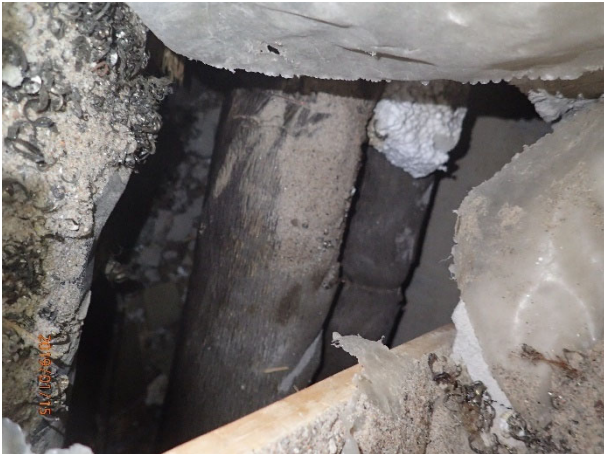
Kuva 8. Näkymä käytöstä poistettuun tekniikkakuiluun. Kuilusta oli voimakas ilmavirtaus sisälle.
