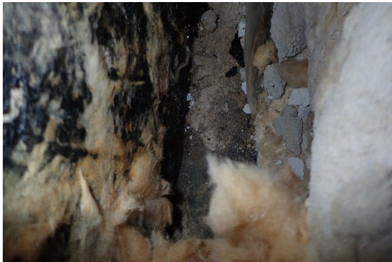
Kuva 1. Vuonna 1974 rakennetun ulkoseinän rakenneavauskohta. Perusmuurin yläpinta 22 cm lattiapinnan alapuolella. Kohdasta otettiin materiaalinäyte RM2019-070 mikrobi 2
