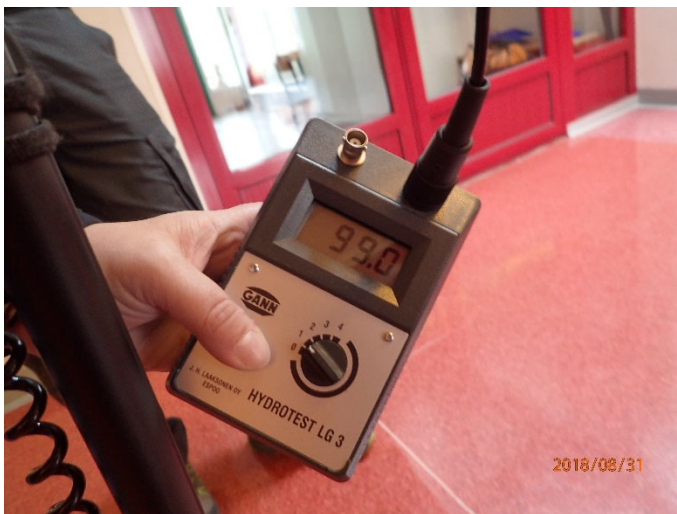
Kuva 6. Kosteus tiivistyy muovimattojen alapintaa vasten vanhalla osalla.
