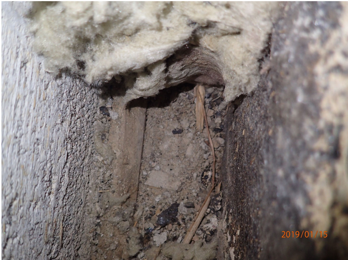
Kuva 3. Vanhan osan ulkoseinän eristeen alapinnassa on myös muottipuutavaraa. Perusmuurin yläpinta 15 cm lattiapinnan alapuolella.
