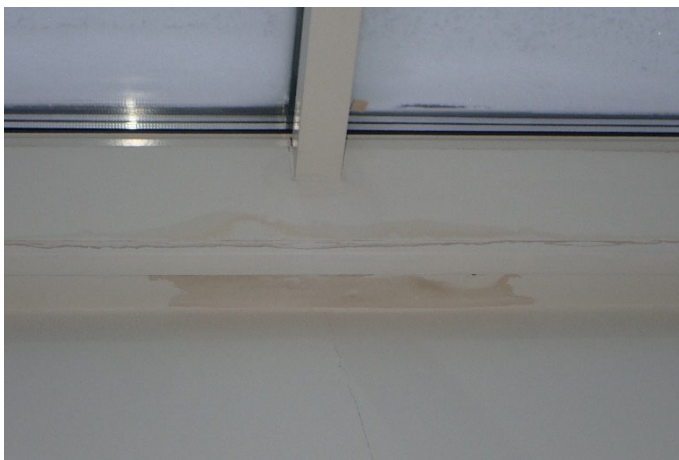
Kuva 14. Vesivuotojälkiä (1974) käytävällä
