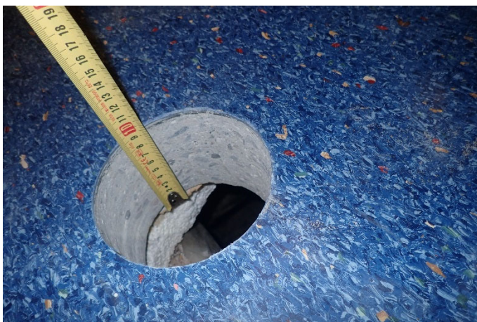
Kuva 7. Käytävän rakenneavaus (1974)
