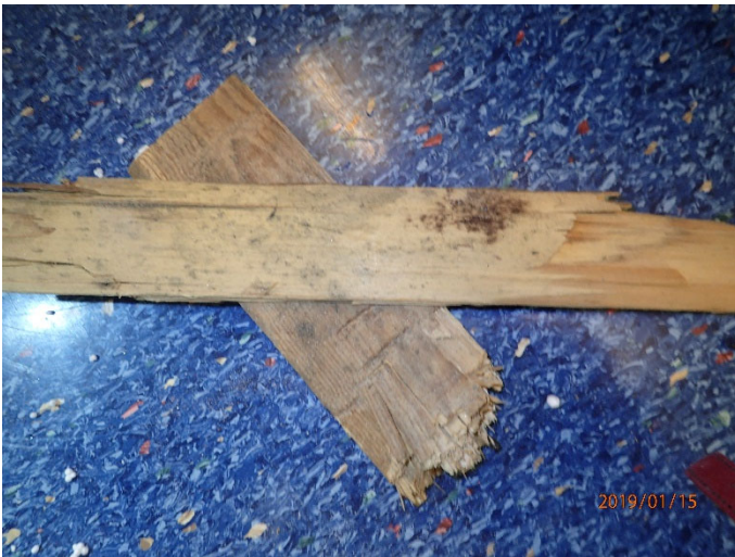
Kuva 9. Tekniikkakuilun muottipuissa oli näkyvää mikrobikasvustoa
