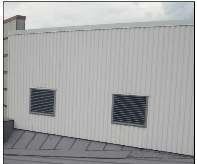
RAK-kuva 16 Iv kojehuoneiden ulkoseinien profiilipeltiverhousta
