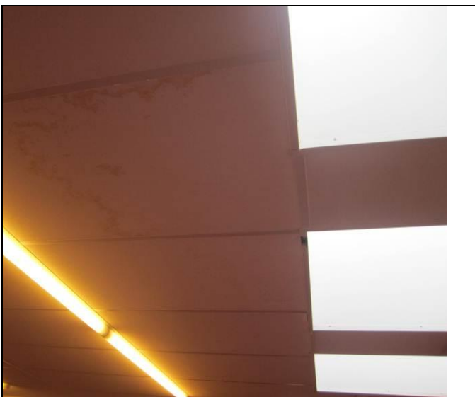
RAK-kuva Kattoikkunan kohdalla käytävän alakatossa kosteusjälkiä 39
