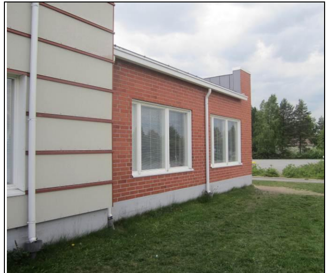
RAK-kuva 10 Kattovesien poistot alla oleviin sadevesisuppiloihin / sadevesijärjestelmään
