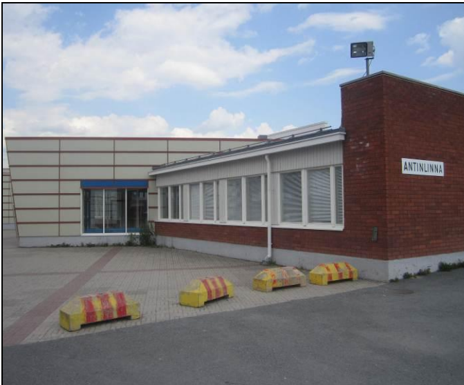
RAK-kuva 13 Julkisivuja. Tiiliverhousta, puuverhouksia ja levyverhouksia
