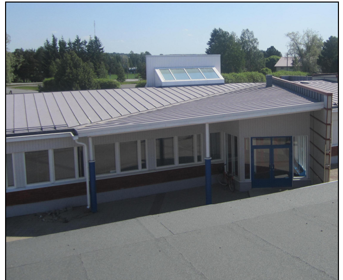
RAK-kuva 26 Yleiskuva rakennusten vesikatto- muodoista
