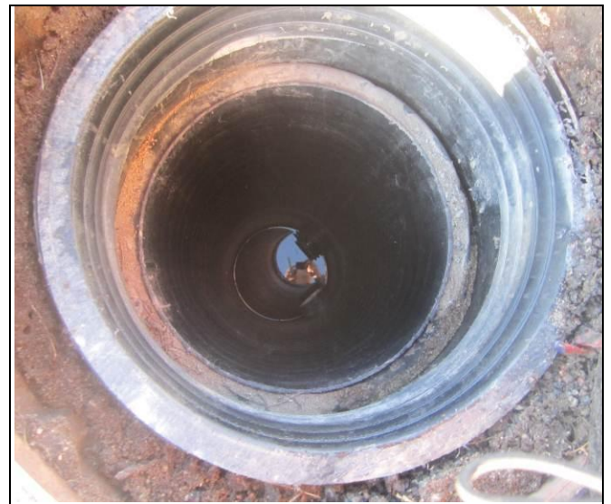
RAK-kuva 8 Salaojan tarkastuskaivo
