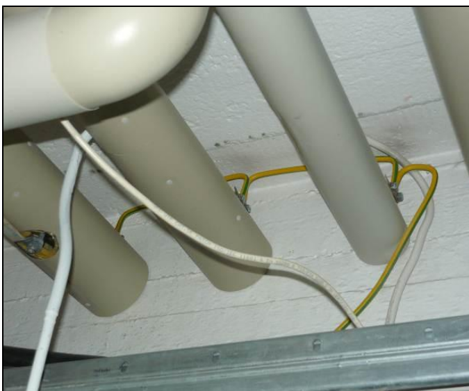
S- kuva 7. Yleiskuva potentiaalintasauksesta.
