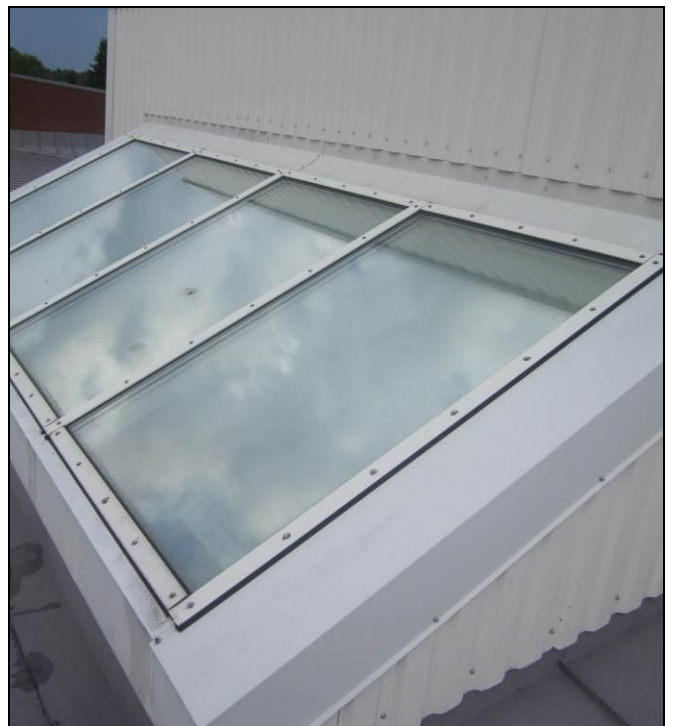
RAK-kuva 32 Yleiskuva kattoikkunoista
