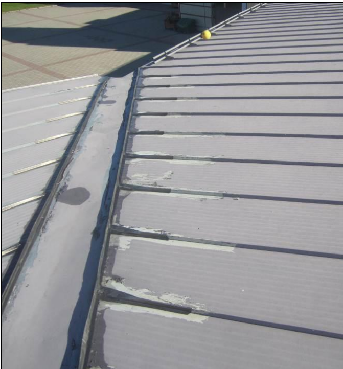
RAK-kuva 29 Yleiskuva pitkän jirrin alueelta. Jiirinpohjalla peltien saumoja on tiivistetty teippauksin ja massauksin.
