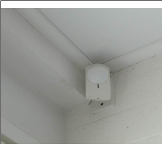
S- kuva 19. Yleiskuva murtohälytysjärjestelmän liiketunnistimesta.
