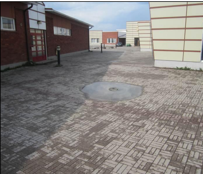
RAK-kuva 3 Sidekiveyspinnoitettua piha-aluetta. Sadevesikaivo on osin ympäristöään korkeammalla
