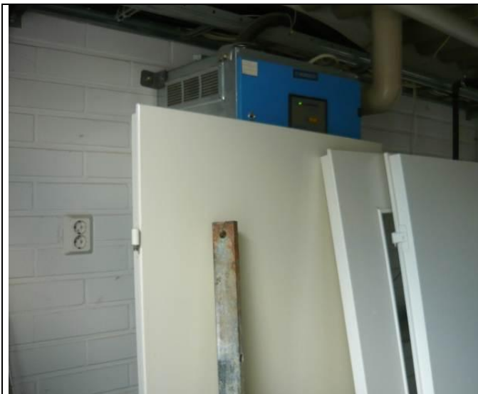
S- kuva 5 Yleiskuva kompensointiparistosta.
