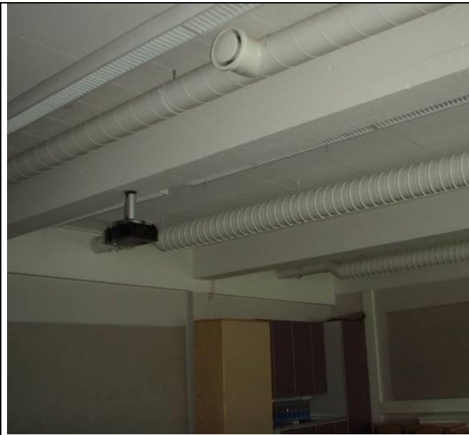
LVI-kuva 13. Yleiskuva luokkatilan päätte-elimistä.
