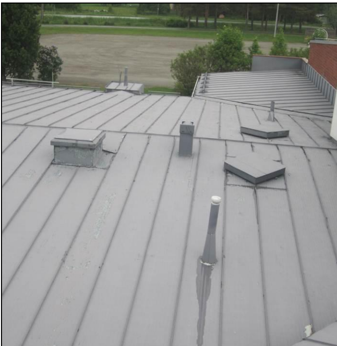
RAK-kuva 27 Yleiskuva vesikatolta
