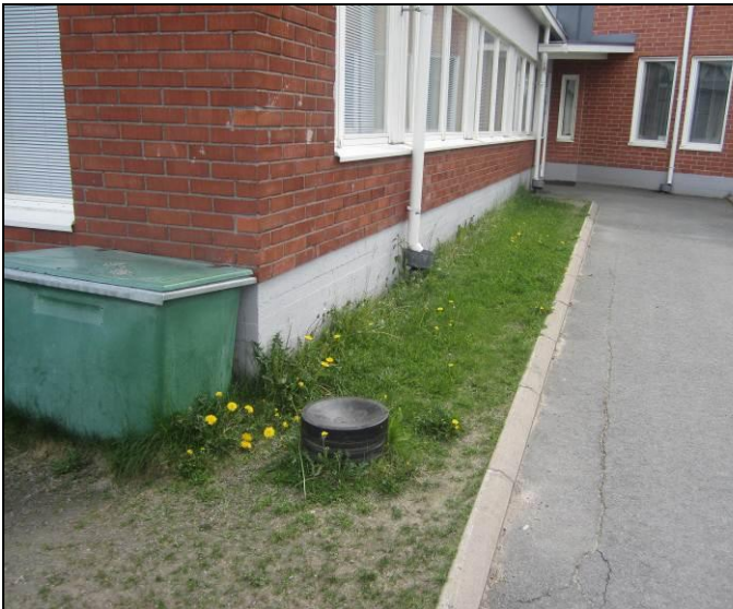
RAK-kuva 9 Salaojan tarkastuskaivo rakennuksen kulmalla
