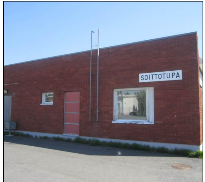
RAK-kuva 6. Yleiskuva päädyn tiilijulkisivusta ja aukkojen levyverhoiluista osista
