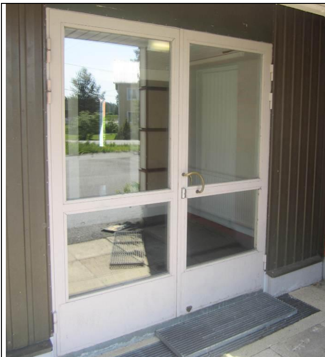
RAK-kuva 15 Alkuperäinen teräsrakenteinen pääulko-ovi
