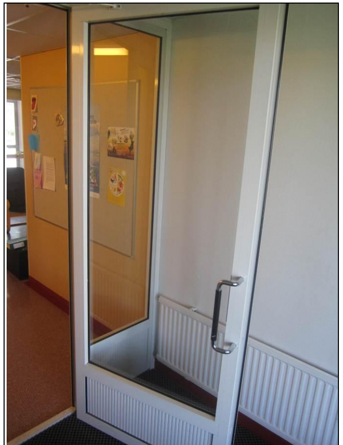
RAK-kuva 24 Tuulikaappiosan alumiiniprofiilirekanteinen sisäovi
