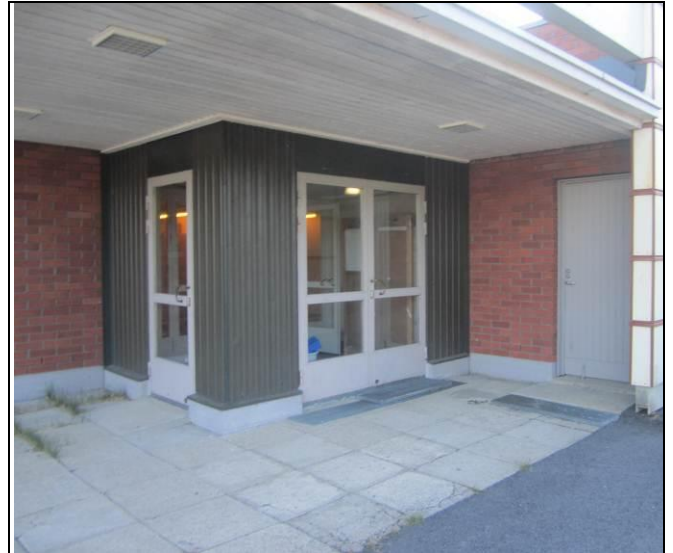
RAK-kuva 10 Tuulikaappiosan julkisivun peltiverhous
