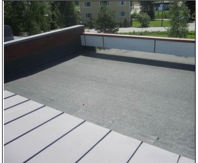
RAK-kuva 22 Eteläpuolen tuulikaappiosan bitumikermikatetta
