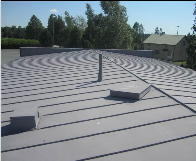
RAK-kuva 21 Yleiskuva vesikatolta
