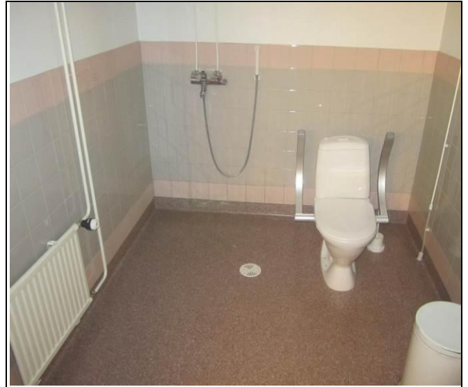
RAK-kuva Yleiskuva wc-tilasta 26
