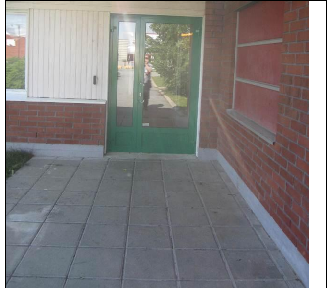
RAK-kuva 14 Uusittu alumiiniprofiilirakenteinen pääulko-ovi
