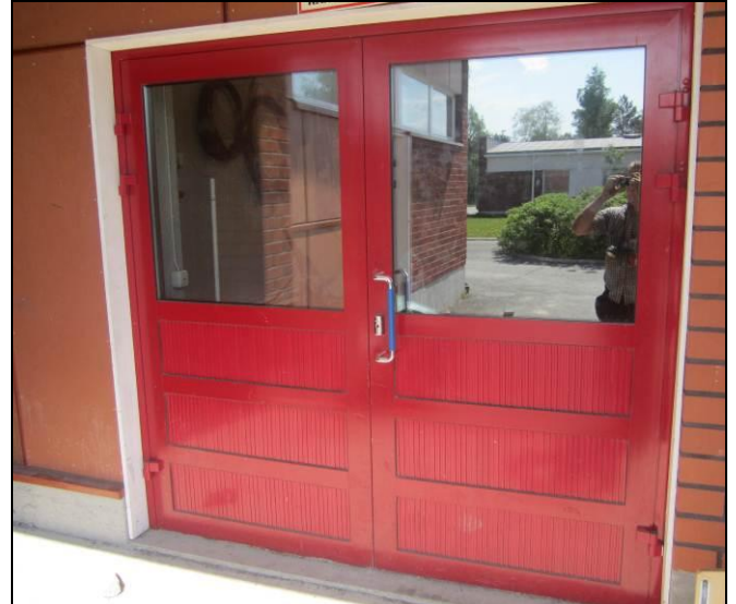
RAK-kuva 14 Uusittu alumiiniprofiilirakenteinen ulko-ovi. Ovet ovat hyvässä kunnossa
