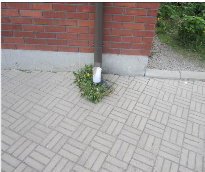
RAK-kuva 7 Kattovesien poistot tapahtuvat syöksytovista sadevesisuppiloiden kautta erilliseen sadevesijärjestelmään
