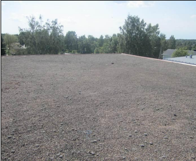
RAK-kuva 21 Yleiskuva vesikatolta (liikun- tasaliosa). Kate suojattu singelillä
