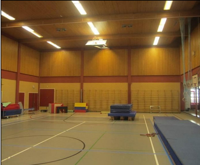
RAK-kuva Yleiskuva liikuntasalista 29
