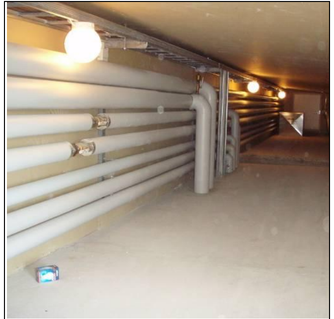
LVI- kuva 4. Yleiskuva lämpö- ja käyttövesiverkoston putkiasennuksista.
