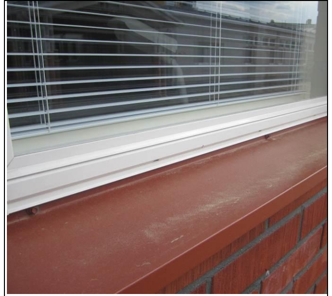
RAK-kuva 10 Uusittu hyväkuntoinen ikkuna ja vesipellitys
