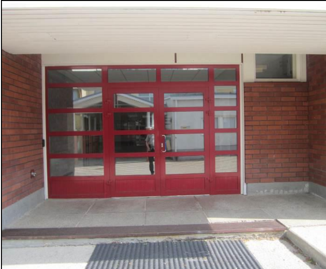
RAK-kuva 13 Uusittu alumiiniprofiilirakenteinen pääulko-ovi. Ovet ovat hyvässä kunnossa
