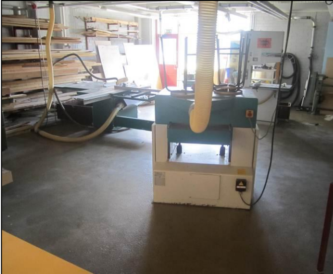
RAK-kuva Yleiskuva teknisistä tiloista 33
