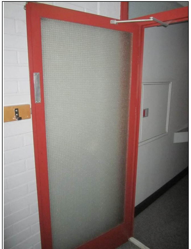
RAK-kuva 24 Yleiskuva osastoivasta käytävä- ovesta
