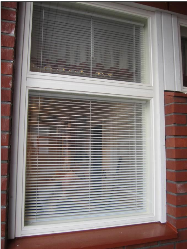
RAK-kuva 11 Uusittu hyväkuntoinen ikkuna
