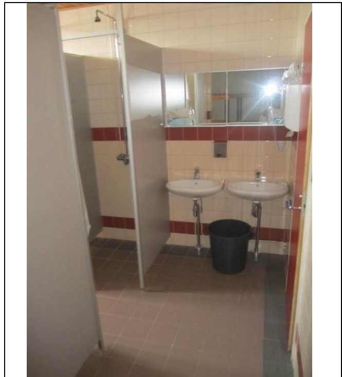
RAK-kuva Yleiskuva liikuntasalin pesuhuone- tilasta 28
