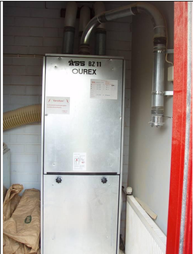
LVI- kuva 13. Yleiskuva purunpoistoimurista.
