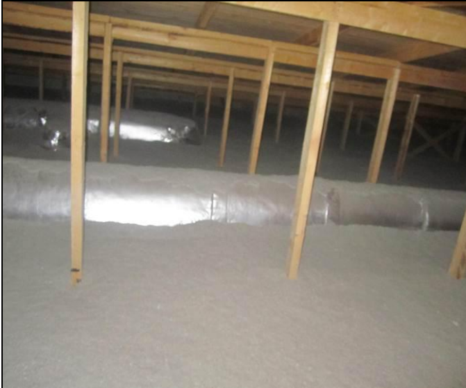
RAK-kuva 17 Puurakenteista yläpohjatilaa
