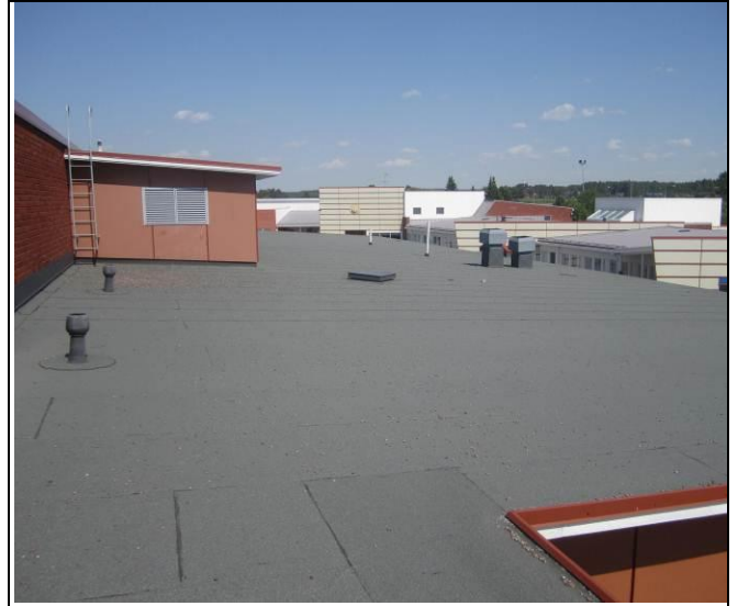
RAK-kuva 22 Yleiskuva vesikatolta
