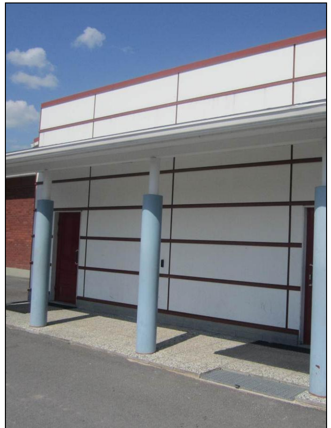
RAK-kuva 16 Hyväkuntoinen katosrakenne
