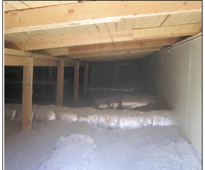
RAK-kuva 18 Yläpohjatilaa. Tilan puurakenteita ja lämmöneristyksiä sekä putkis-toeristystä
