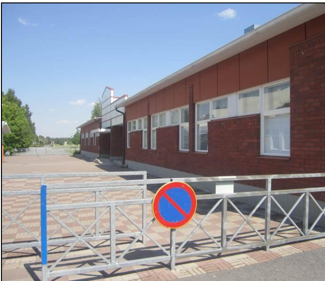
RAK-kuva 3 Metallirakenteinen aita. Aita on hyvässä kunnossa
