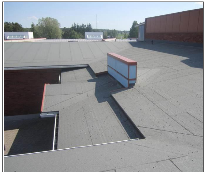
RAK-kuva 20 Yleiskuva vesikatolta
