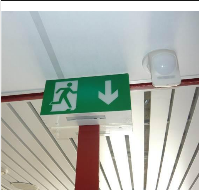
S- kuva 15. Yleiskuva murtohälytysjärjestelmän liiketunnistimesta.
