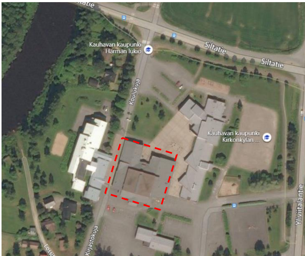
Kuva 1 Tutkimuskohde korostettuna ilmakuvassa (lähde Bing Maps).
