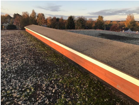
Kuva 28 Yleiskuva liikuntasalin vesikatolta.
