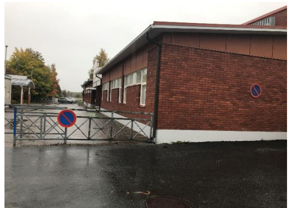
Kuva 11 Yläasteen ja kirjaston välinen metallirakenteinen aita.
