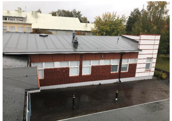
Kuva 15 Rakennuksen julkisivun tiili- ja levyverhouksia.
