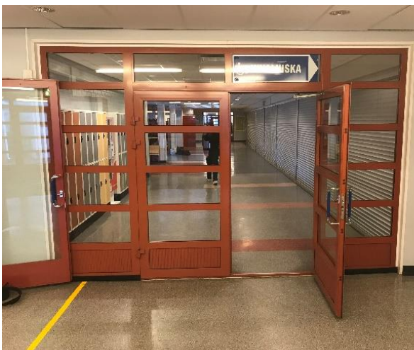
Kuva 40 Yleiskuva käytävän väliovista.
