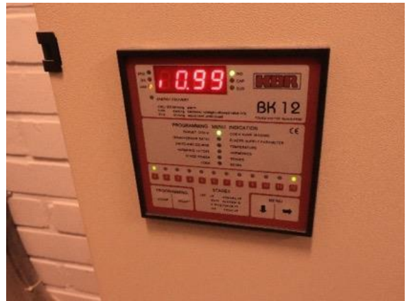
Kuva 70 Kompensoinnin säädin.
