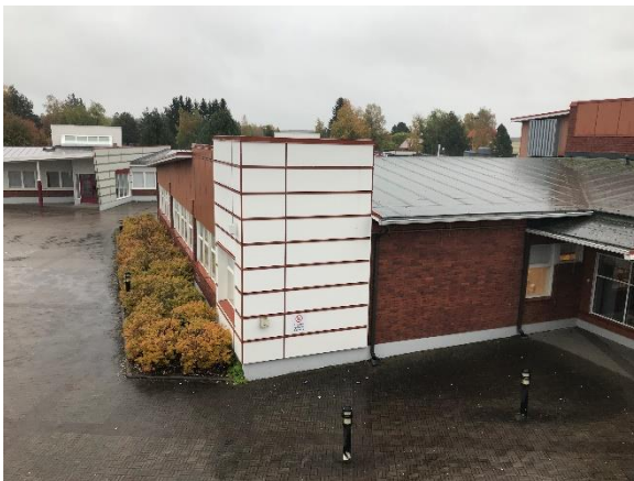
Kuva 16 Rakennuksen julkisivun tiili- ja levyverhouksia.
