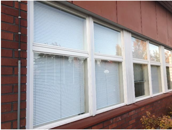
Kuva 18 Yleiskuva ikkunoista ja vesipellityksistä.
