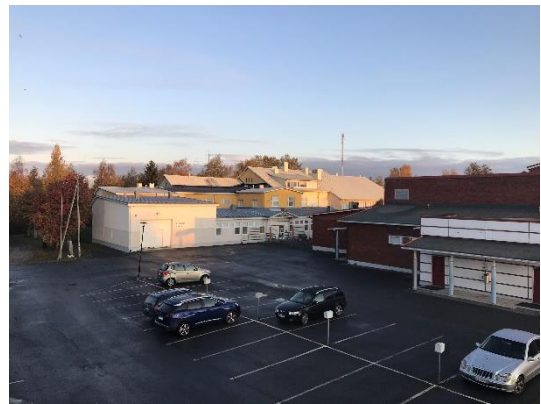
Kuva 3 Yleiskuva pysäköintialueen päällysteistä.
