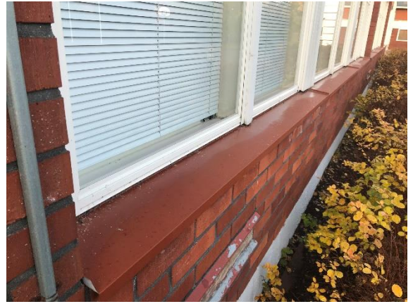
Kuva 19 Yleiskuva ikkunoista ja vesipellityksistä.
