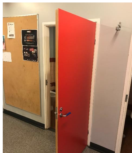
Kuva 41 Yleiskuva wc-tilan väliovesta.
