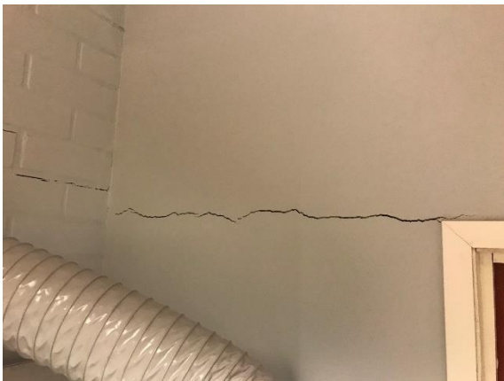
Kuva 36 Tiiliväliseinien halkeamia.
