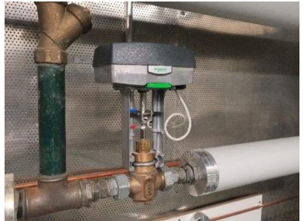
Kuva 77 Yleiskuva moottoriventtiilistä.
