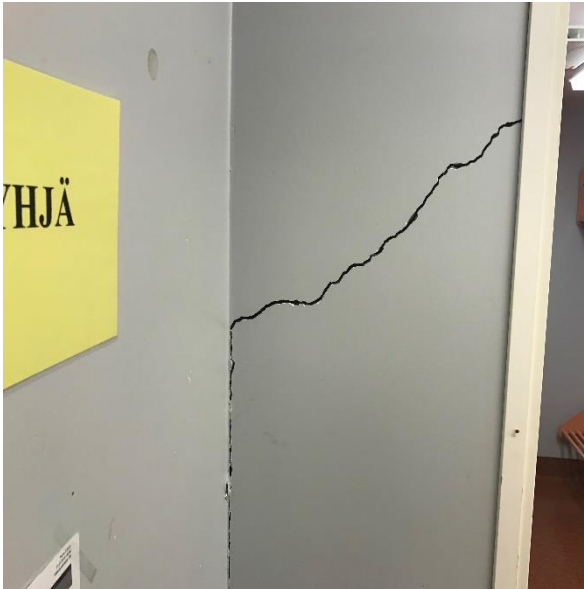
Kuva 38 Tiiliväliseinien halkeamia.
