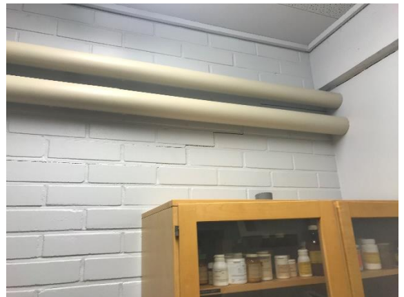
Kuva 37 Tiiliväliseinien halkeamia.
