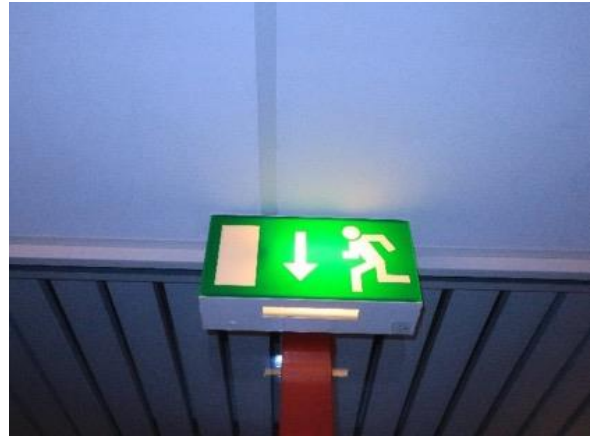
Kuva 74 Yleiskuva poistumistievalaisimesta.
