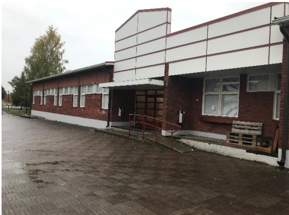
Kuva 14 Rakennuksen julkisivun tiili- ja levyverhouksia.
