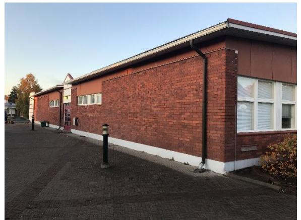
Kuva 17 Rakennuksen julkisivun tiili- ja levyverhouksia.
