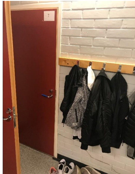
Kuva 39 Tiiliväliseinien halkeamia.
