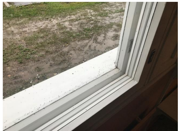
Kuva 19 Yleiskuva rakennuksen ikkunoista.
