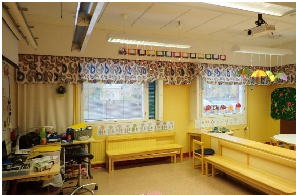
Kuva 38 Yleiskuva huonetilojen tilapinnoista.
