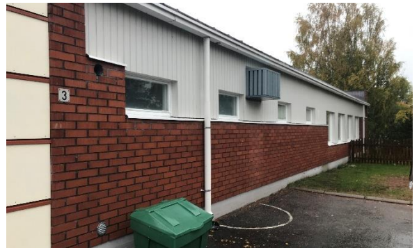
Kuva 17 Yleiskuva rakennuksen eteläpuolen julkisivuista.
