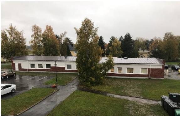
Kuva 2 Asfaltoituja ja nurmipintaisia piha-alueita rakennuksen pohjoispuolella.
