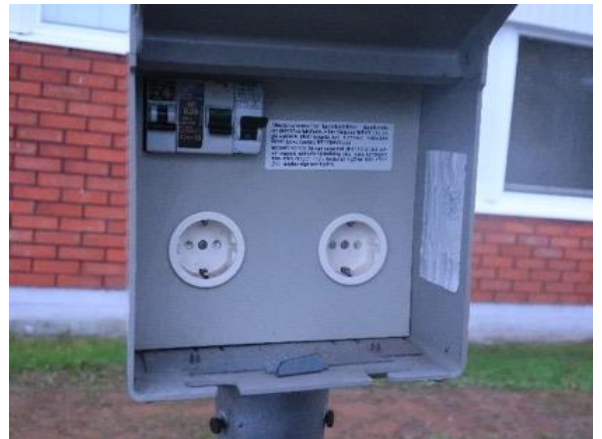
Kuva 55 Yleiskuva autolämmityspistorasiasta.
