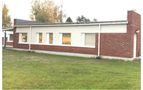
Kuva 15 Yleiskuva rakennuksen pohjoispuolen julkisivuista.
