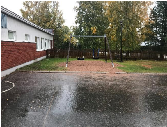
Kuva 4 Asfaltoitua ja nurmi / hiekkapintaista piha-aluetta rakennuksen eteläpuolella.
