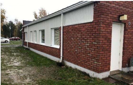
Kuva 16 Yleiskuva rakennuksen pohjois-länsipuolen julkisivuista.
