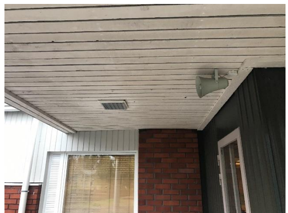
Kuva 26 Katoksen alakattolaudoituksia.
