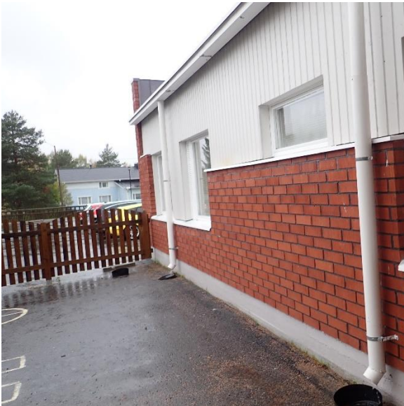
Kuva 8 Kattovesien poistoja rakennuksen eteläpuolella.
