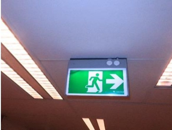
Kuva 59 Yleiskuva poistumistievalaisimesta.
