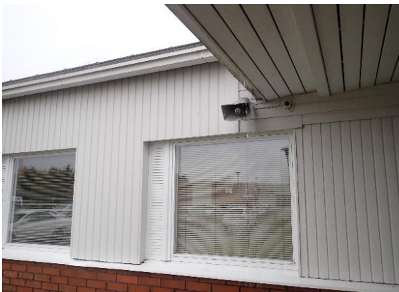
Kuva 18 Yleiskuva rakennuksen ikkunoista.
