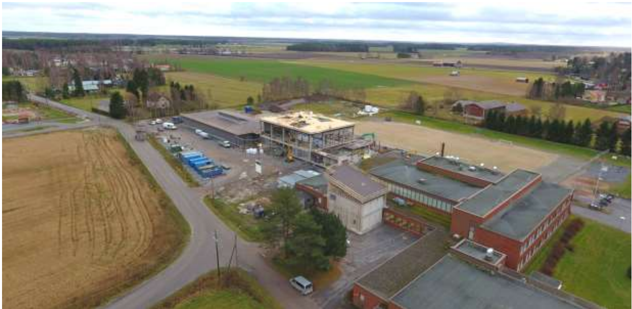
Kuva 2. Suunnittelualueen ympäristöä. Rakenteilla oleva Ylihärjän yhtenäiskoulu syksyllä 2020.
