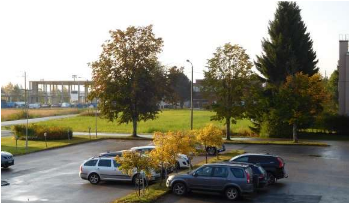
Kuva 22: Rakenteilla oleva Ylihärän yhtenäiskoulu syksyllä 2020.
